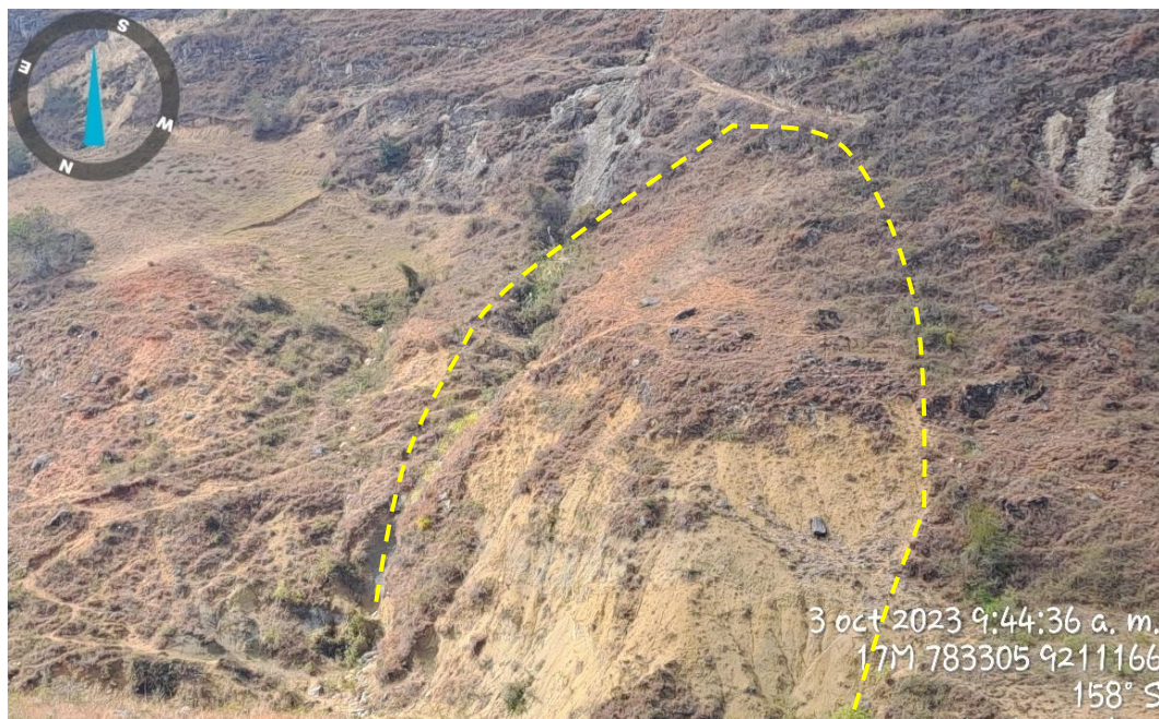
Foto 27. Deslizamiento favorecido por la pendiente en la Formación Celendín debido a los procesos denudativos .
