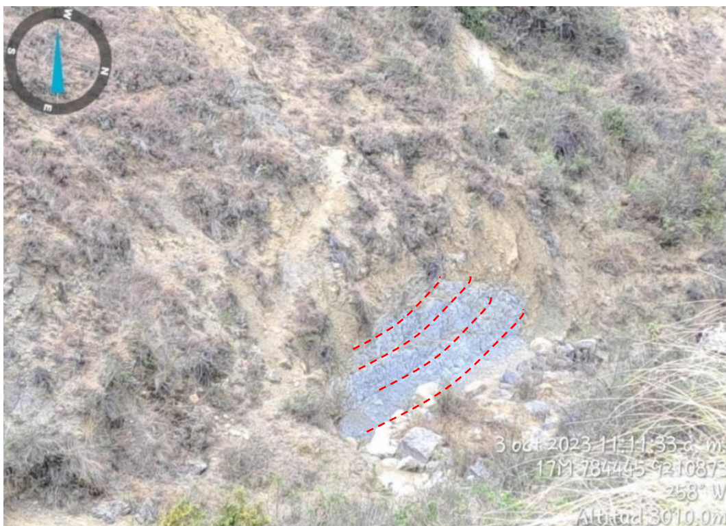
Foto 12. Deformación del Sinclinal en la Quebrada Campanarume.
