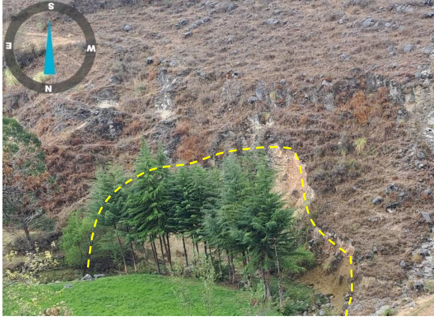
Foto 24. Deslizamiento en la Formación Celendín, ubicado al margen izquierdo de la Quebrada Campanarume, formado por movimientos de masa favorecido por la pendiente y gravedad. (Coordenadas 782486E 9211335N, Orientación de foto 178°S)
