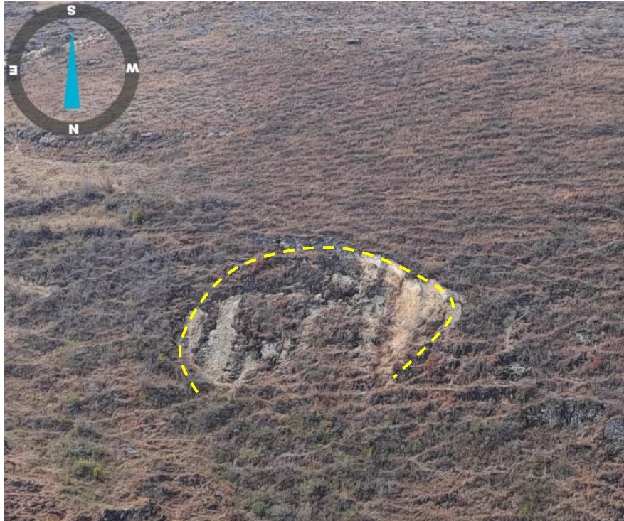
Foto 26. Deslizamiento en el lado izquierdo de la Quebrada Campanarume. (Coordenadas 783304E 9211166N, Orientación de foto 181°S)
