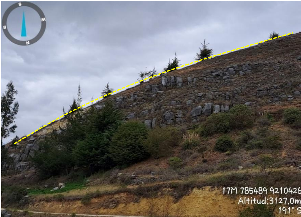
Foto 40. Ladera Ondulada Kárstica en rocas sedimentarias de la Formación Cajamarca, con una inclinación aproximada de 65°.
