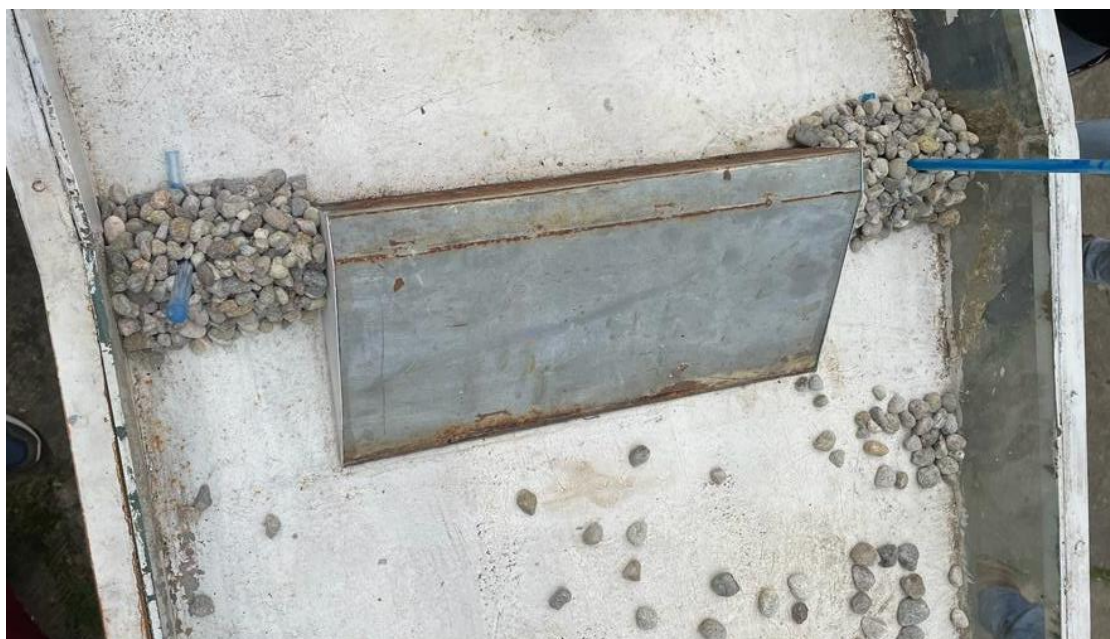
Figura 44. Construcción de barrage Fijo con apertura del 20% a cada lado, más barrage fusible de enrocado
