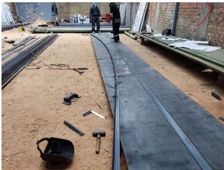
Figura 55. rolado de brida inferior del segmento de tijeral metálico
