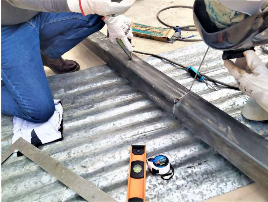
Figura 74. Soldadura de bridas de tijerales metálicos
