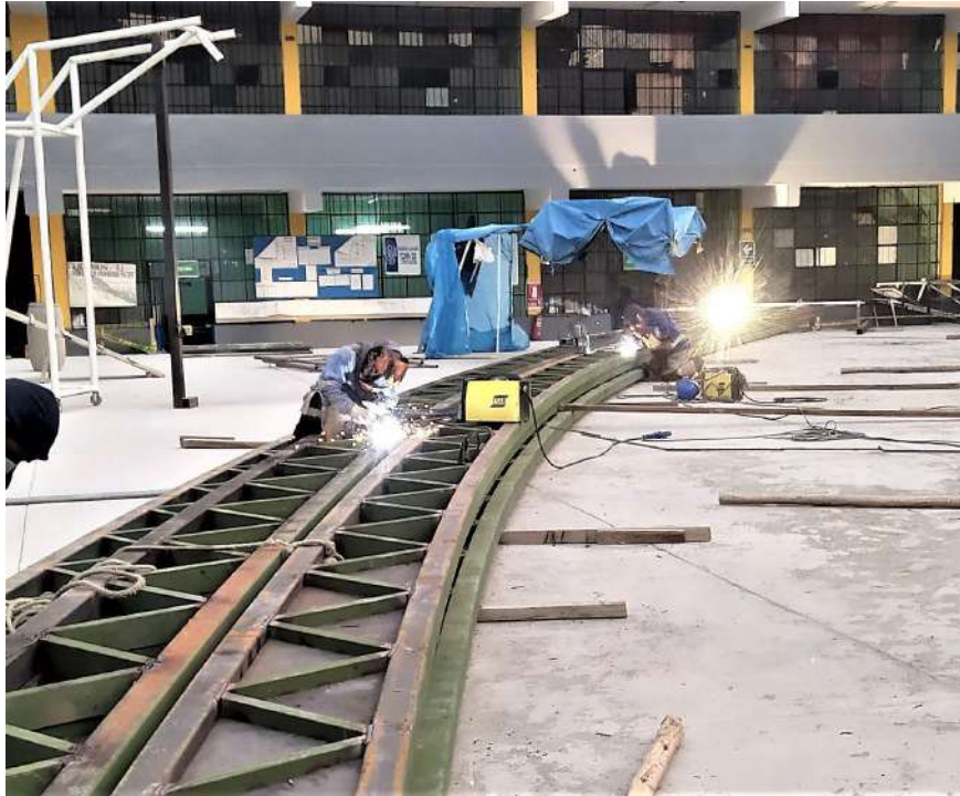
Figura 75. Soldadura en celosía del tijeral parabólico metálico
