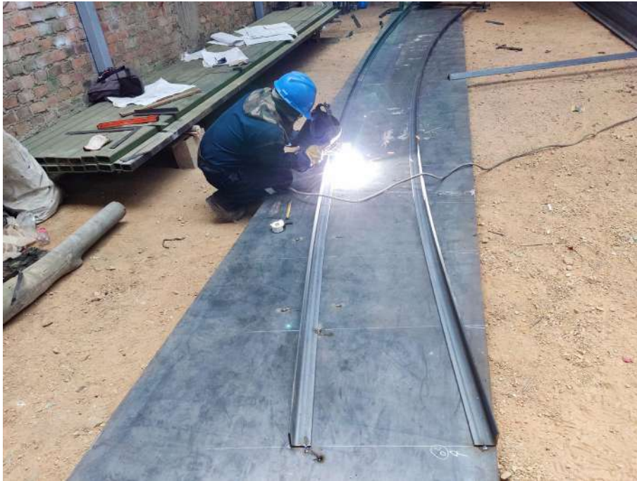
Figura 56. Ubicación de la brida superior
