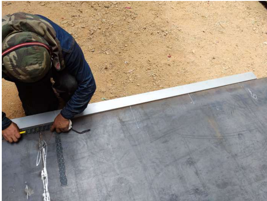
Figura 54. Ubicación de los puntos de doblé o rolado de brida inferior
