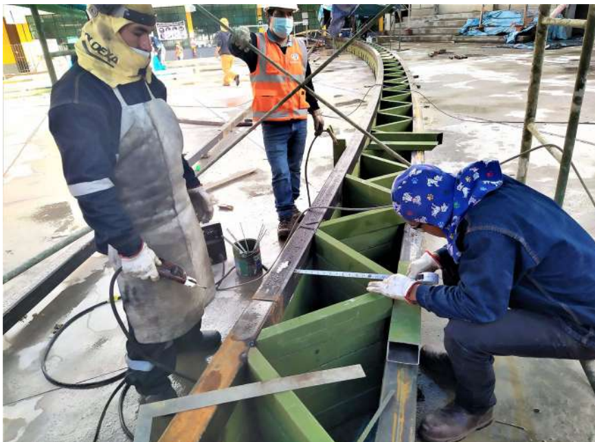
Figura 72. Control de dimensiones de peralte y espaciamento de celosía.
