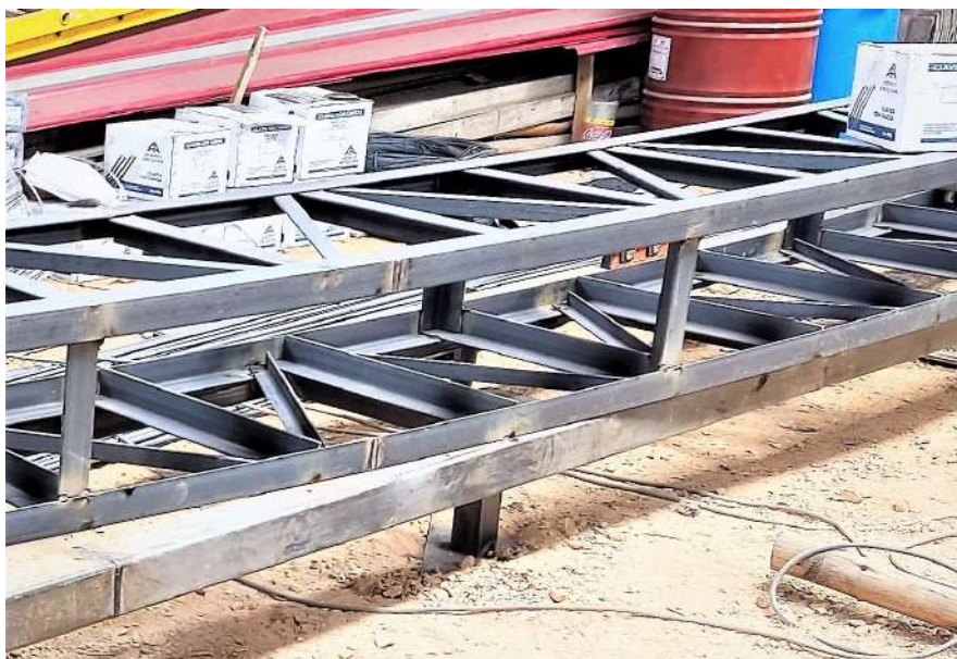
Figura 77. Soldadura de juntas en bridas y aleros
