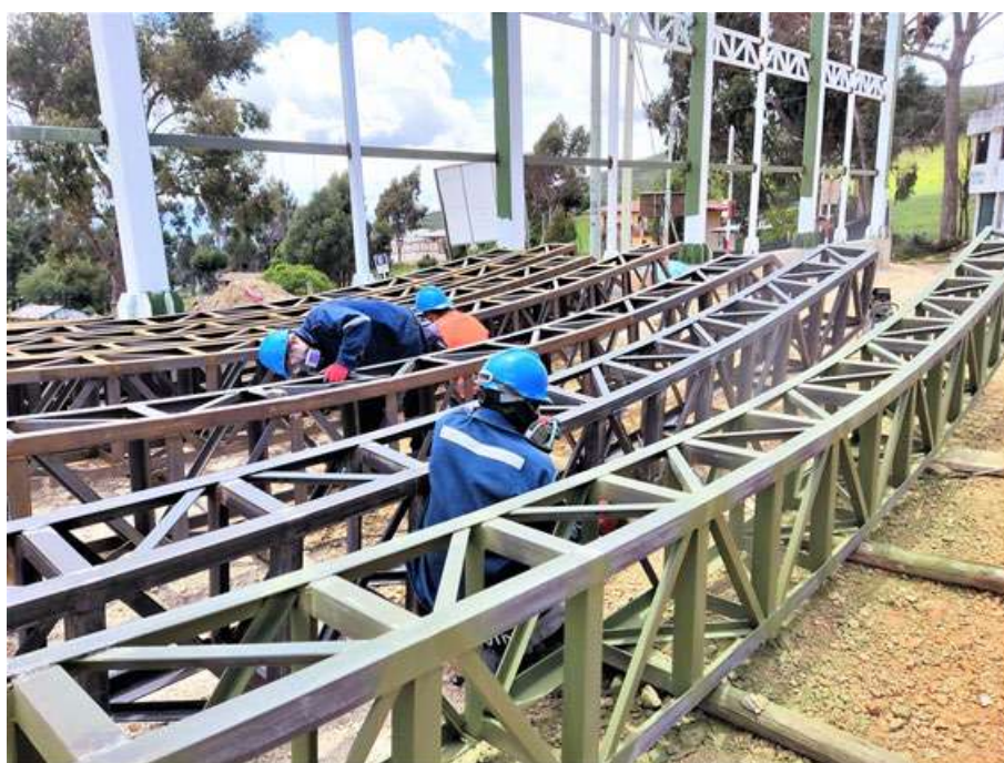
Figura 92. Segmento de tijeral limpios y en proceso de pintura
