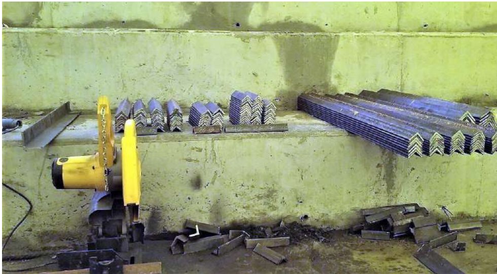
Figura 59. Habilitación de celosía para tijeral
