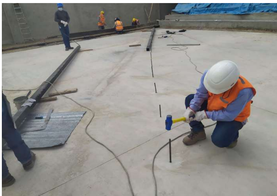
Figura 51. Colocación de puntos de anclaje para rolado de brida inferior
