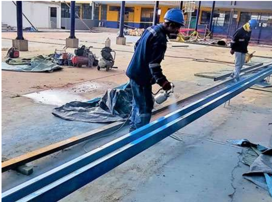
Figura 95. Aplicación de pintura de acabado - esmalte sintético
