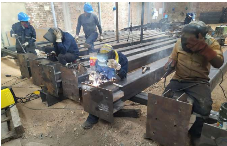
Figura 78. Soldadura de cartelas y planchas de apoyo de tijerales.
