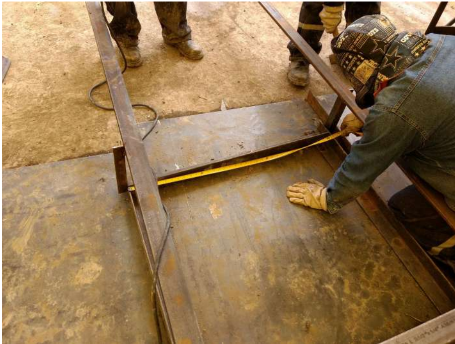
Figura 58. Verificación de medidas de la plantilla
