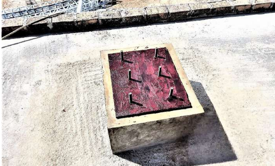
Figura 99. Nivelación de planchas de apoyo, sobre columnas de concreto y columnas metálicas-aplicación de grasa grafitada.
