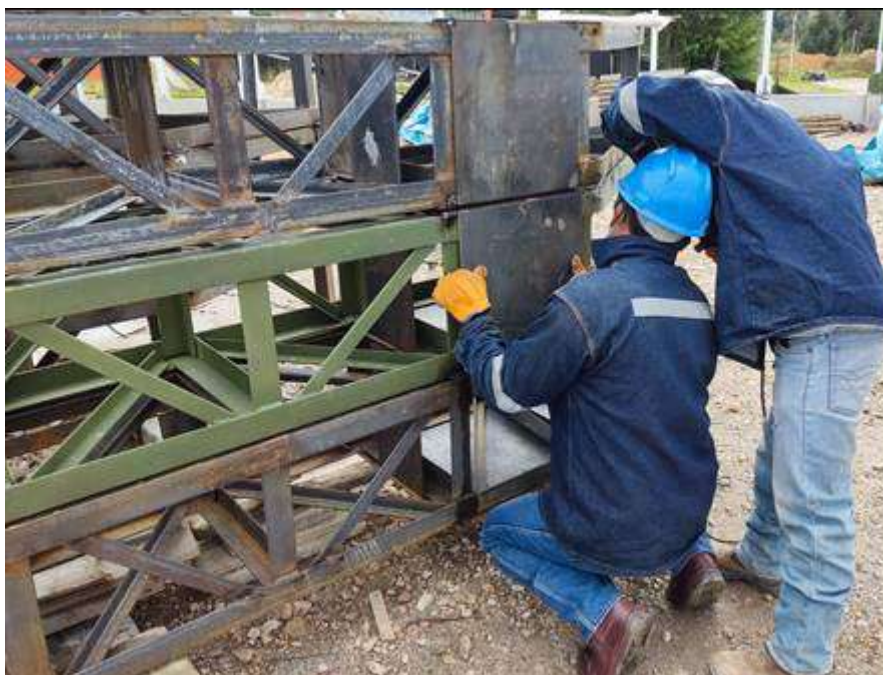
Figura 71. Armado de cajuelas de apoyo de tijerales
