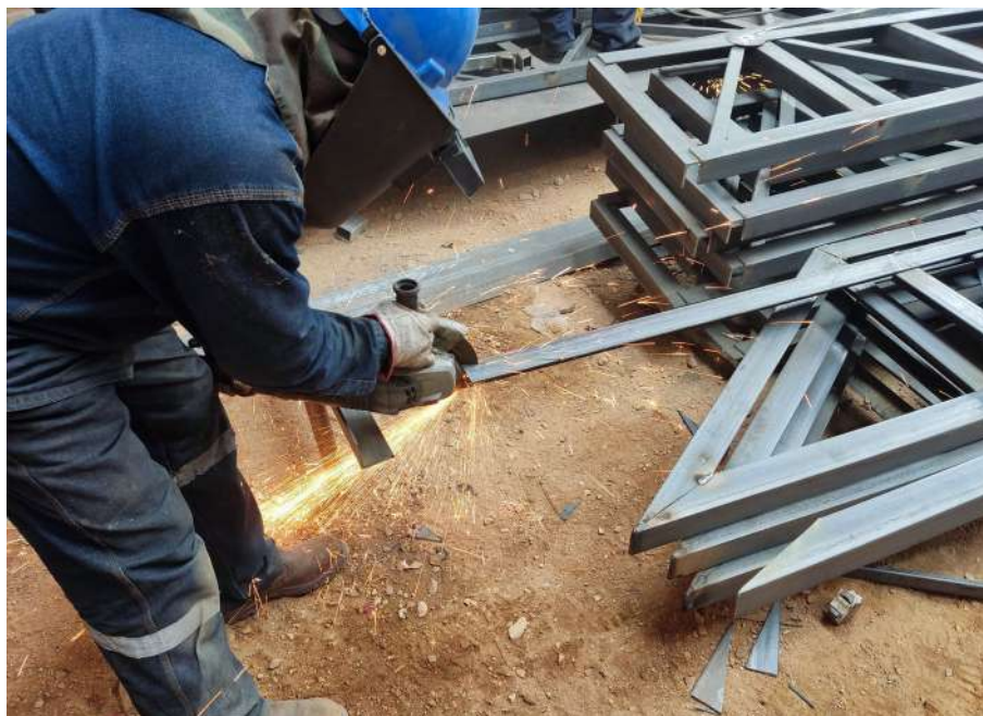
Figura 68. Armado de los aleros de los tijerales según plano de taller
