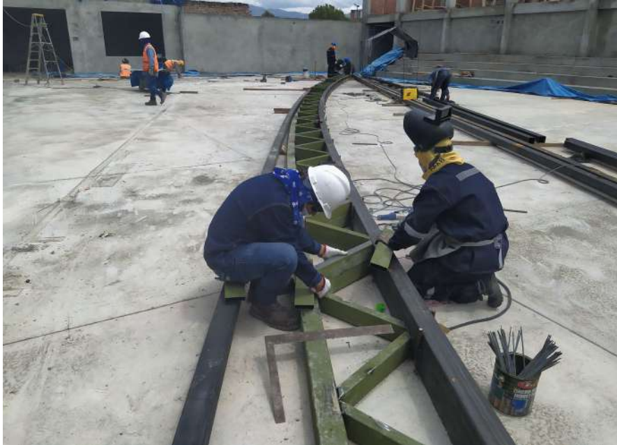
Figura 65. Armado de tijerales con apuntalado y fijación de piezas
