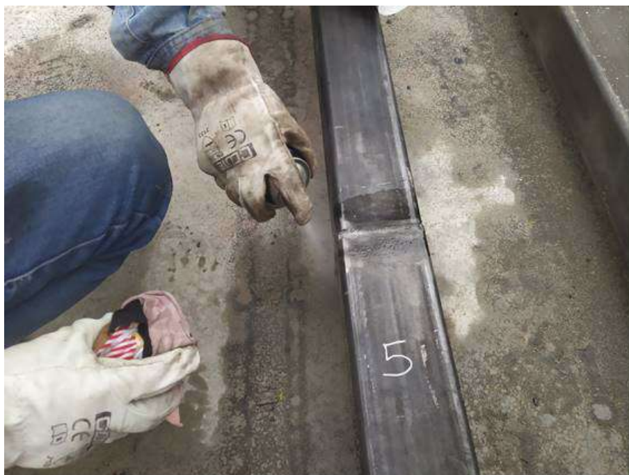
Figura 81. Aplicación de REMOVEDOR O LIMPIADOR en bridas.
