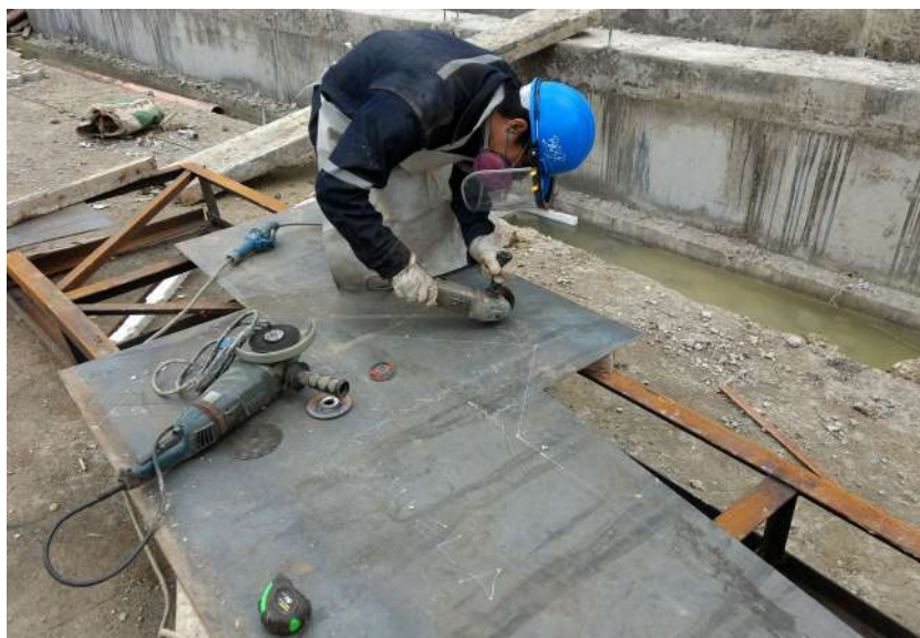
Figura 60. Corte con esmeril de cajuelas de apoyo
