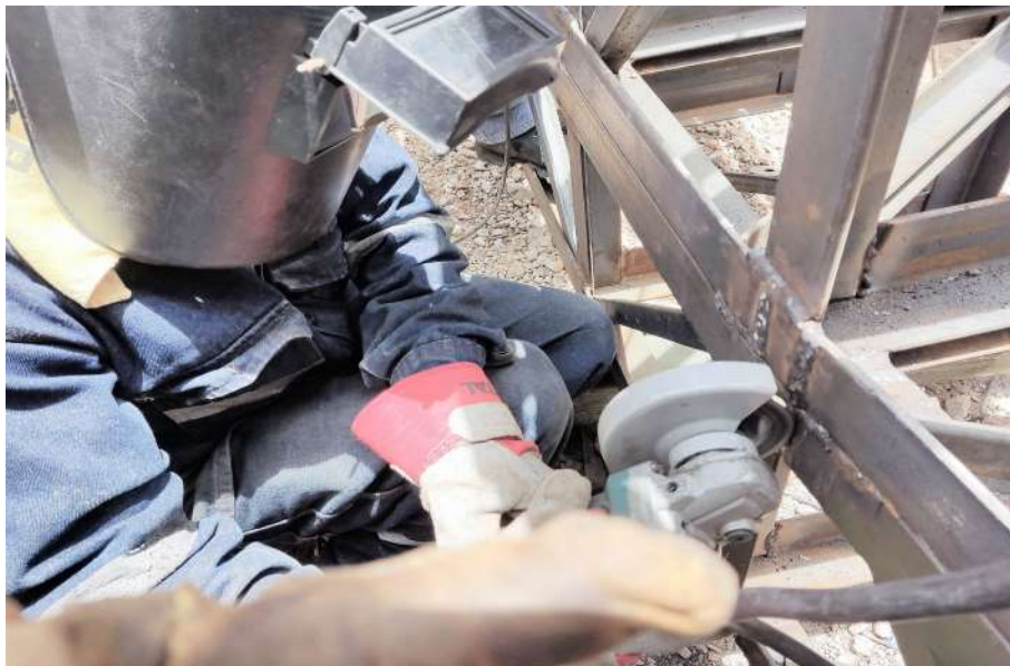
Figura 102. Soldadura en juntas de acoples de acuerdo al plano de taller
