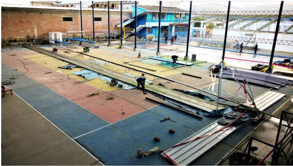
Figura 109. Montaje de viguetas por el método de unión y almacenaje
