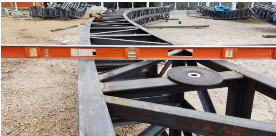
Figura 103. Control de nivelación y terminado de la pintura
