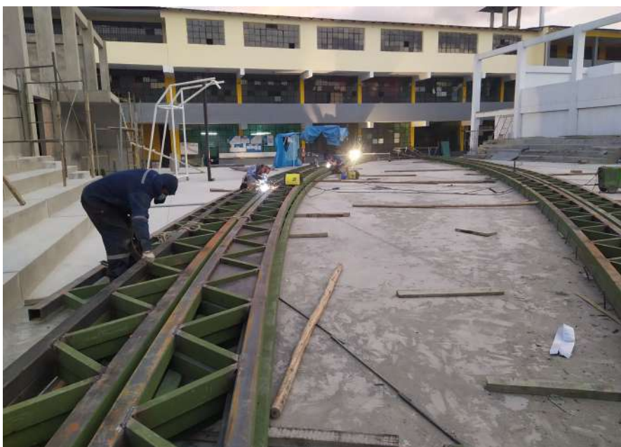
Figura 66. Producción de tijerales tomando como base la plantilla
