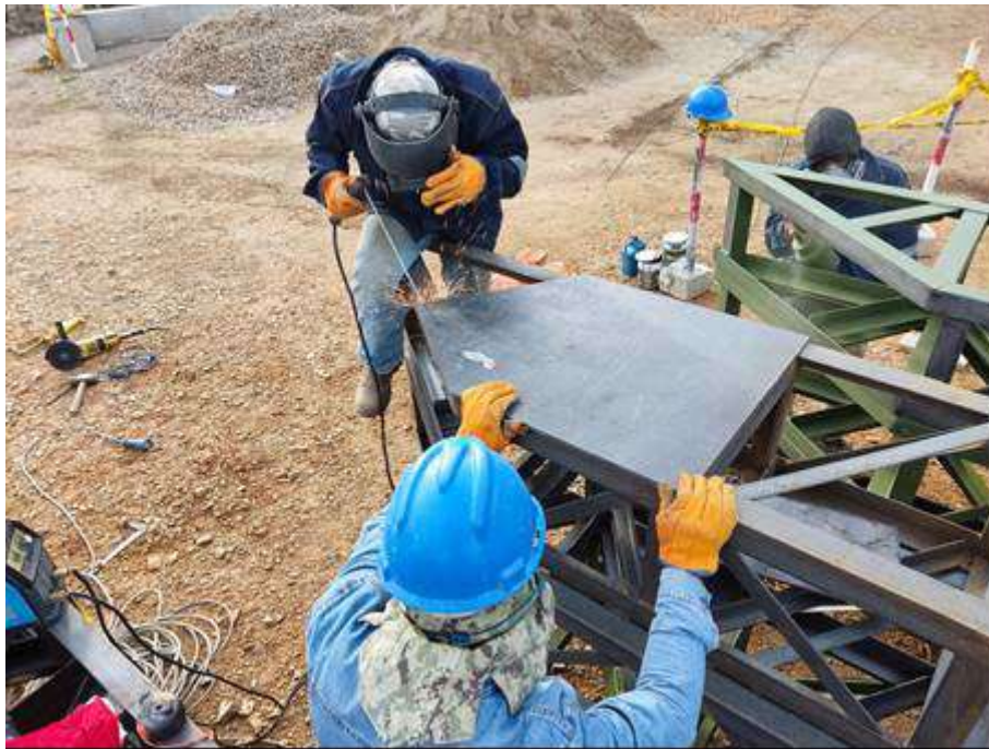
Figura 79. Soldadura de las cajuelas de apoyos de los tijerales.
