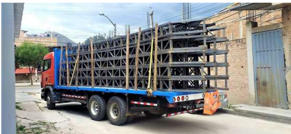
Figura 96. Cargado y traslado de estructura en vehículo de plataforma
