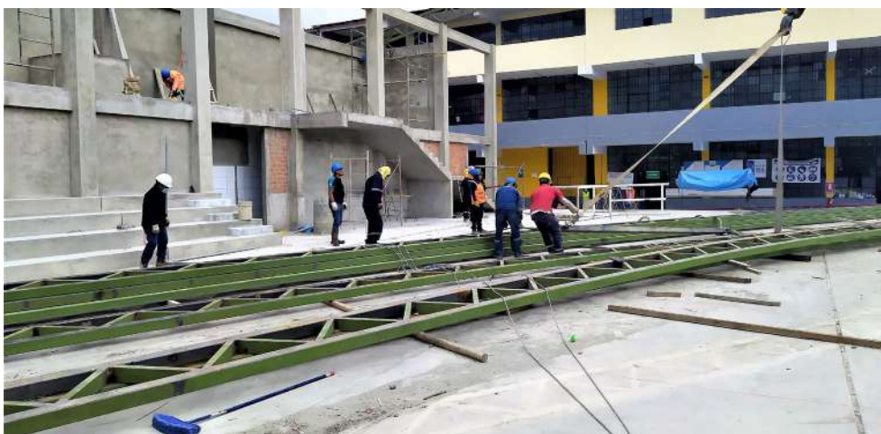
Figura 106. Colocación de eslingas según indicaciones del rigger
