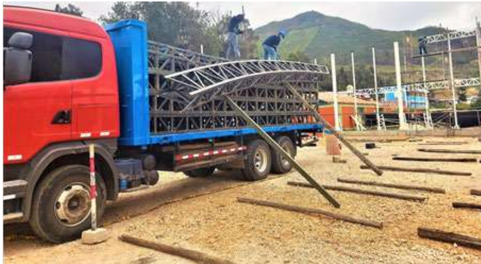
Figura 97. Descargado de estructuras, con método de rampa y retenida
