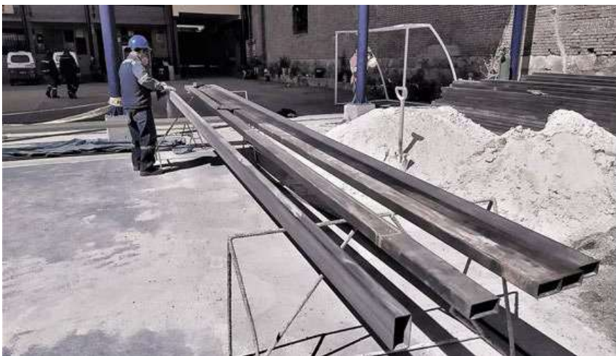
Figura 91. Limpieza con removedor de óxido
