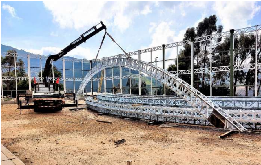
Figura 108. Montaje de tijerales – Almacén Semillero - Michiquillay
