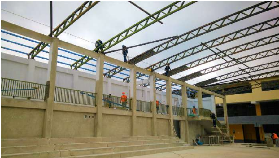
Figura 108. Montaje de tijerales – Almacén Semillero - Michiquillay
