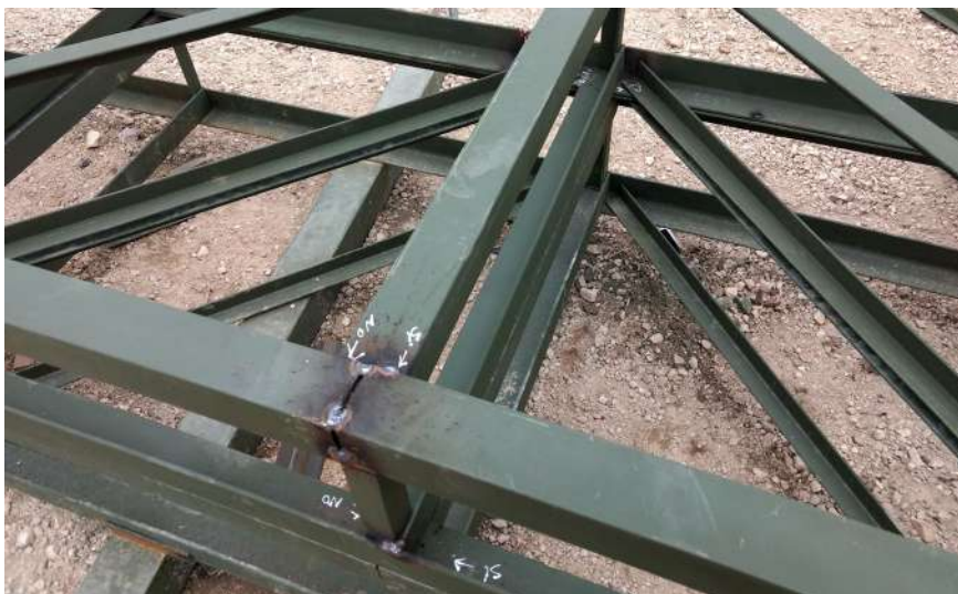
Figura 101. Acople de juntas de segmentos de tijeral, método mecánico
