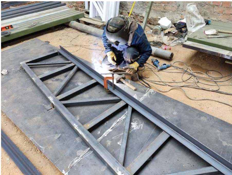
Figura 67. Armado de caras laterales de segmentos de tijeral
