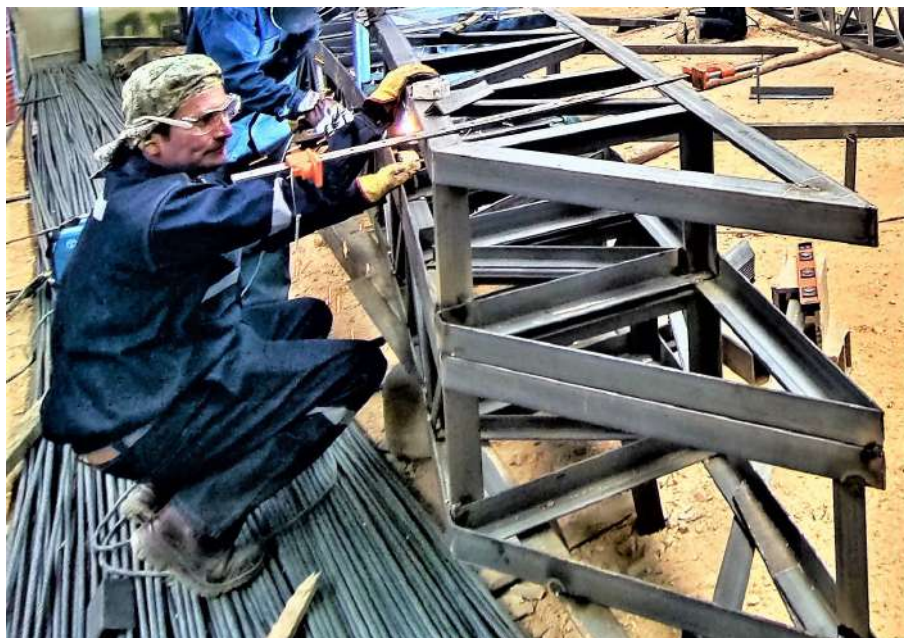
Figura 73. Control de conformación de los segmentos de tijerales
