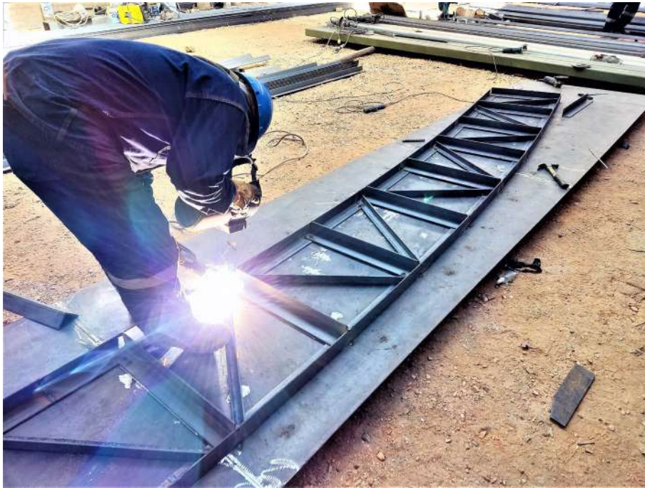
Figura 57. Armado de montantes y diagonales
