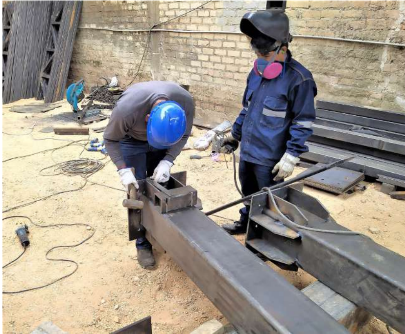
Figura 70. Armado de apoyos superior de tijerales metálicos
