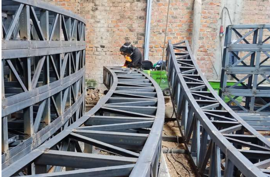
Figura 76. Soldadura en celosía de segmentos de tijerales
