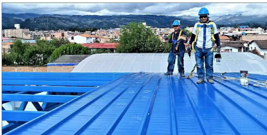
Figura 111. Montaje de cobertura metálica y traslucida, tipo TR-4
