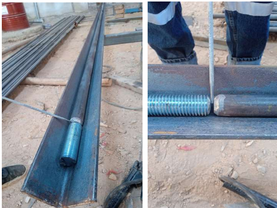
Figura 64. Proceso de soldadura de tensor con perno roscado
