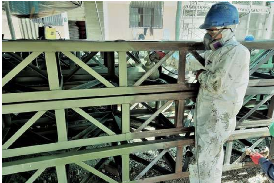
Figura 94. Aplicación de capa de zincromato base en bridas
