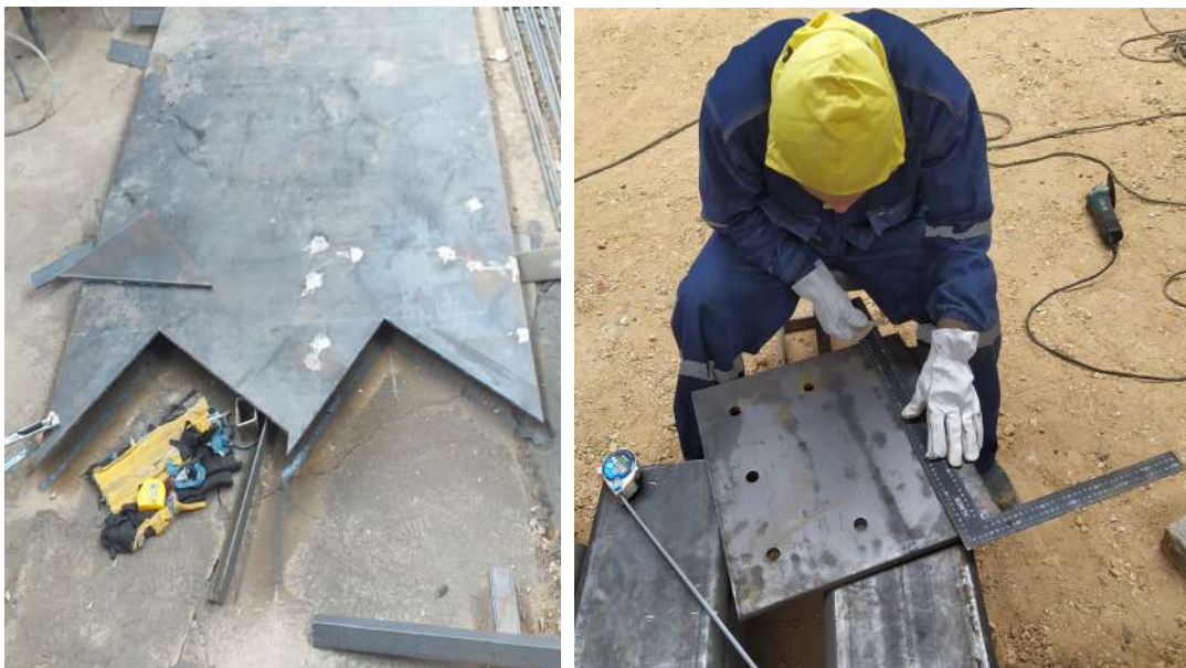
Figura 63. Corte y Habilitado de planchas metálicas para apoyos superiores y cajuelas
