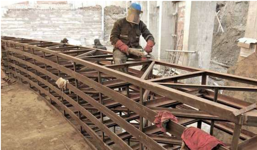
Figura 90. Limpieza de la grasa de tuberías con arena
