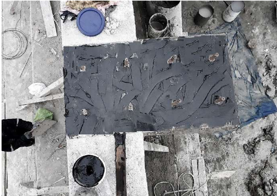
Figura 98. Nivelación de planchas de apoyo y pernos de anclaje, sobre columnas de concretos armado y aplicación grasa grafitada.
