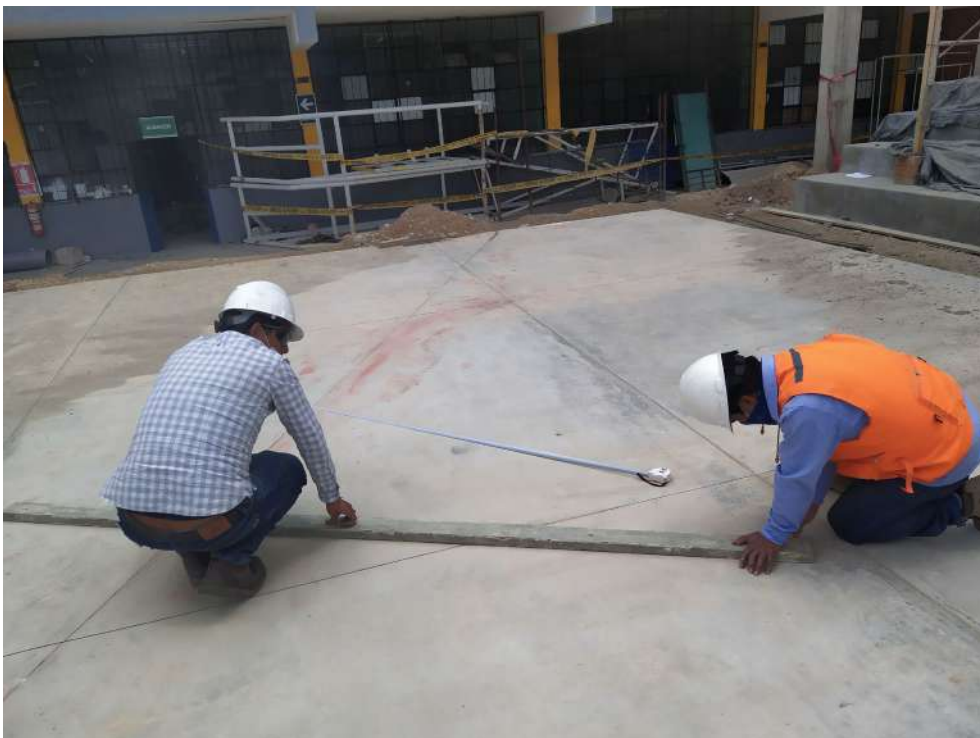
Figura 50. Trazado de tijeral metálico típico
