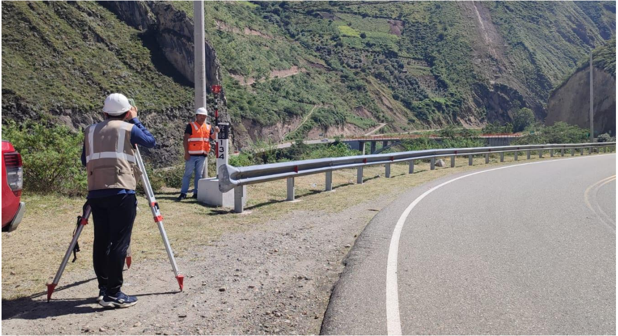
Fotografía 7: Final del levantamiento topográfico en El Puente El Tingo.
