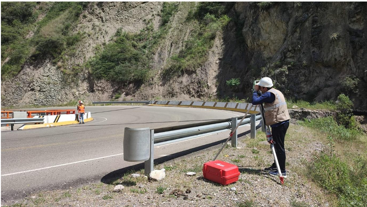
Fotografía 14: Toma de puntos topográficos.
