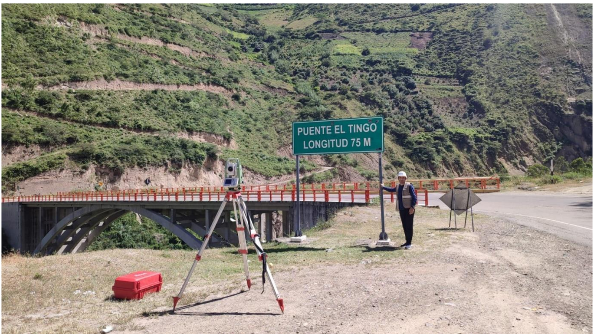
Fotografía 6: Final del levantamiento topográfico en El Puente El Tingo.
