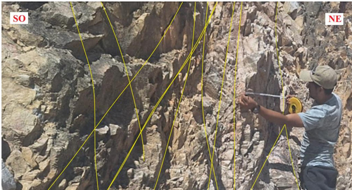
Figura 21: Fracturas medidas en la estación Geomecánica Cruz Blanca EG- 02CB, con coordenadas Este: 777267.58, Norte: 9203254.46, Cota 2798 m.s.n.m
