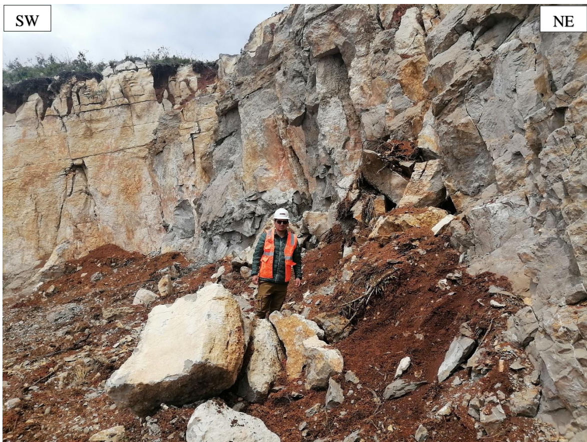
Figura 3.16. Caídas de rocas de dimensiones: 0.60 m. a 1.10 m. en función del plano de estratificación, por buzarse a favor del tajo de explotación.
