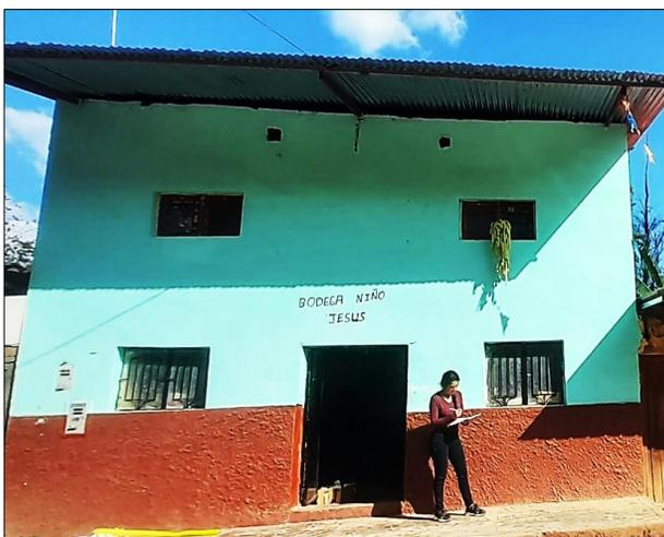
**Vivienda de dos niveles con cubierta de calamina y soportes de madera**
