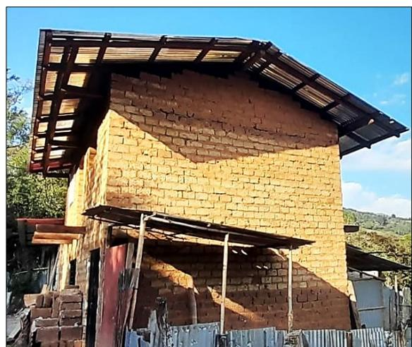
**Falta de tarrajeo de muro y expuesto a intemperización**
