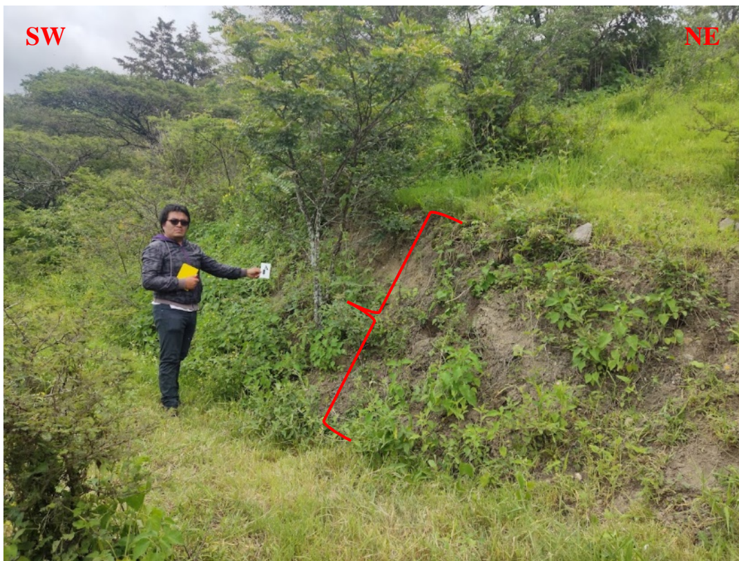
Foto 11. A) Escarpe en la cresta del deslizamiento de aproximadamente 2 metros.
