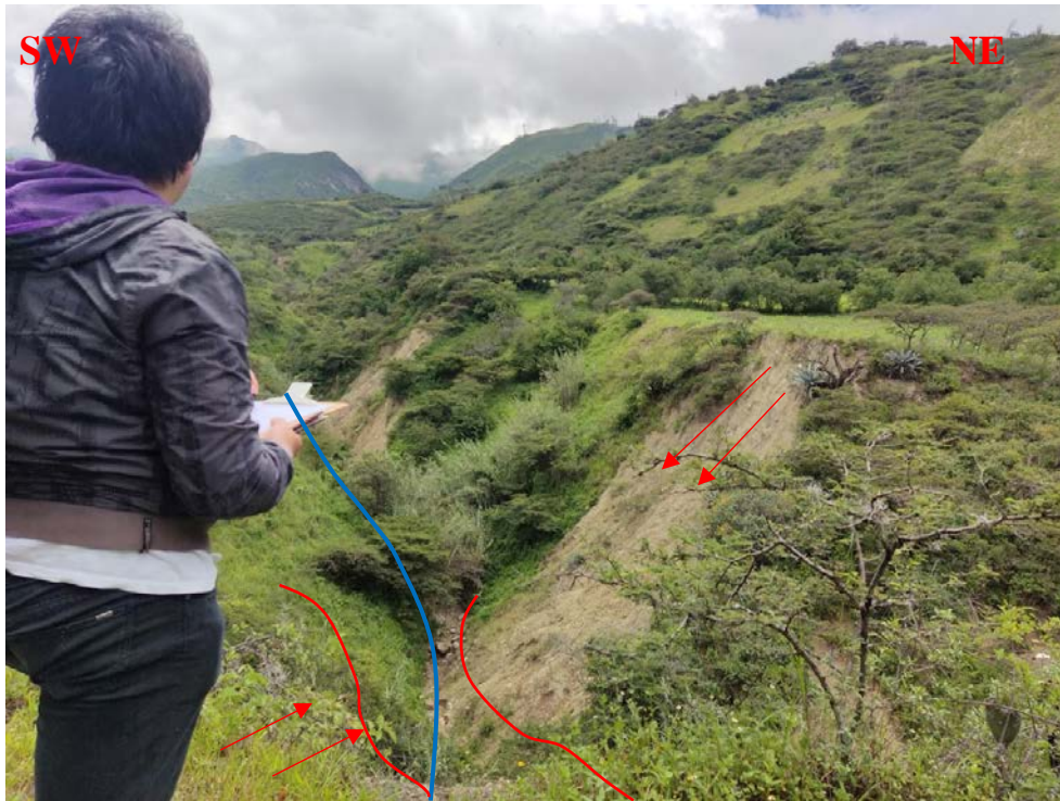
Anexo N° 3. Flujo de agua (Azul), socavamiento (rojo), Socavamiento ocasionado por el aumento de la corriente de agua en la quebrada, provocando la destrucción del camino de herradura y poniendo en riesgo a los pobladores.
