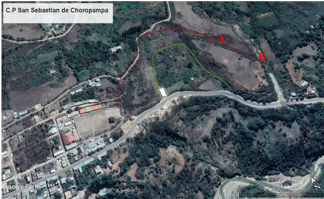
Figura 19. Imagen satelital, en donde muestra un deslizamiento rotacional a la entrada del centro poblado.
