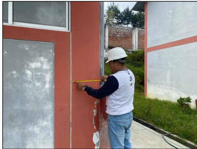
Figura 27. Presencia de fisuras
