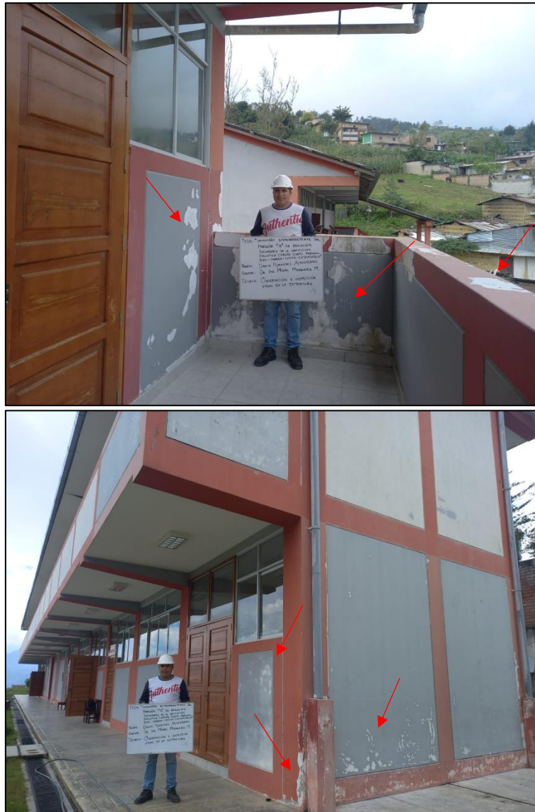
Figura 29. Falta de mantenimiento en las juntas
