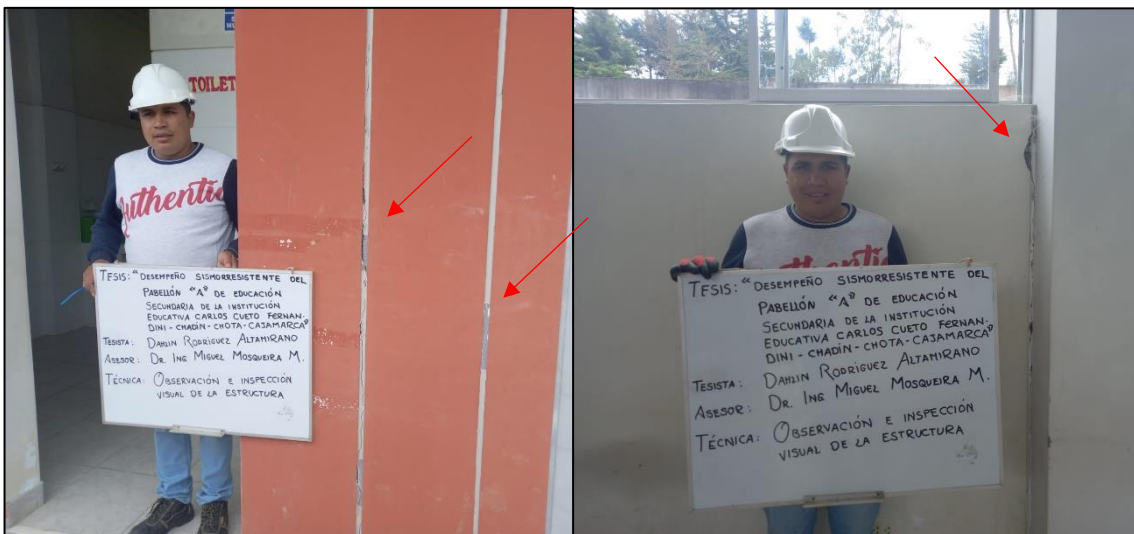
Figura 29. Falta de mantenimiento en las juntas
