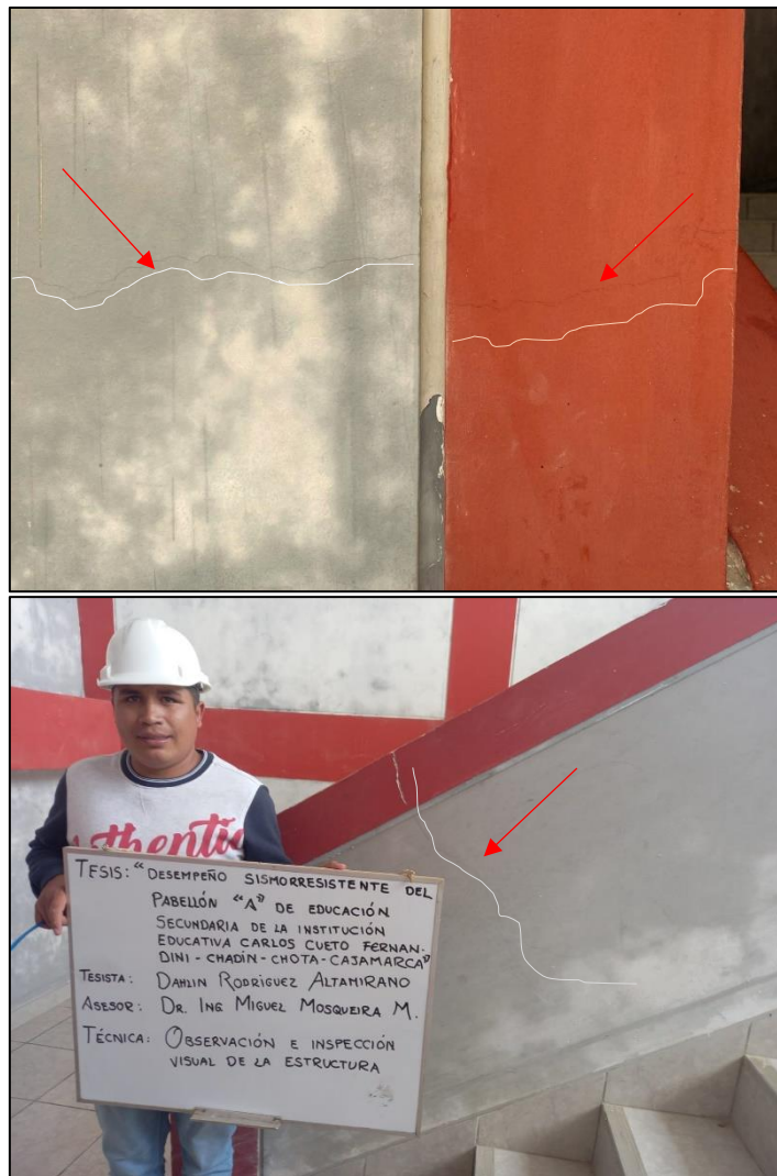
Figura 27. Presencia de fisuras
