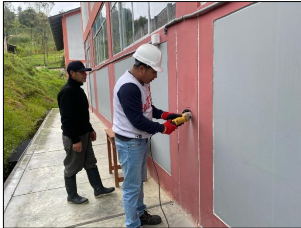
Figura 21. Ensayo de esclerometría en la columna.
