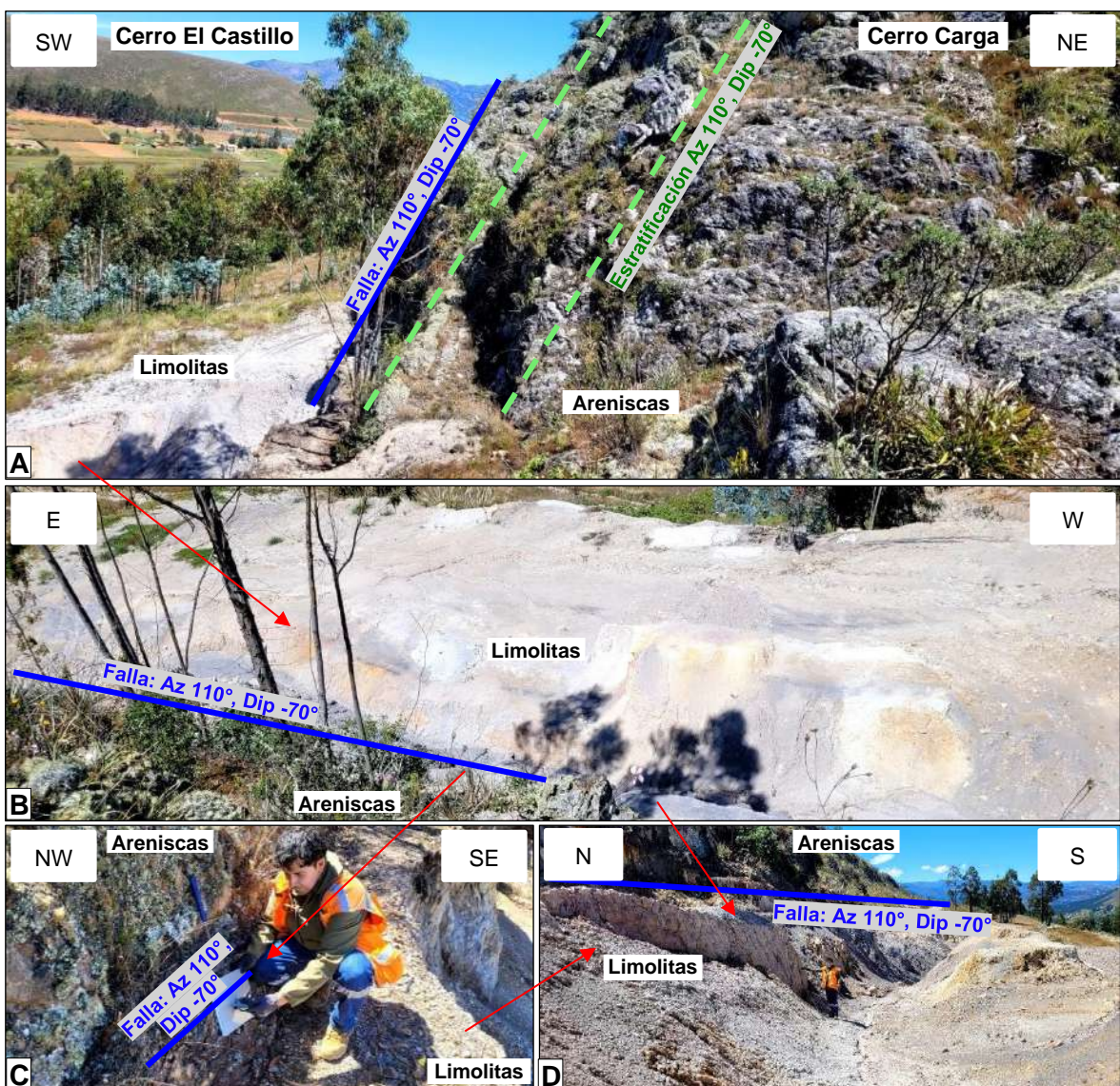
Foto 57. En (A) se observa en el Cerro Carga estratificación y falla contacto paralela entre areniscas y limolitas con Az 110° y Dip -70° pertenecientes a la Formación Farrat (Ki-f), en (B), (C) y (D) se puede apreciar mayor detalle del contacto entre las areniscas y limolitas de la Formación Farrat (Ki-f).
