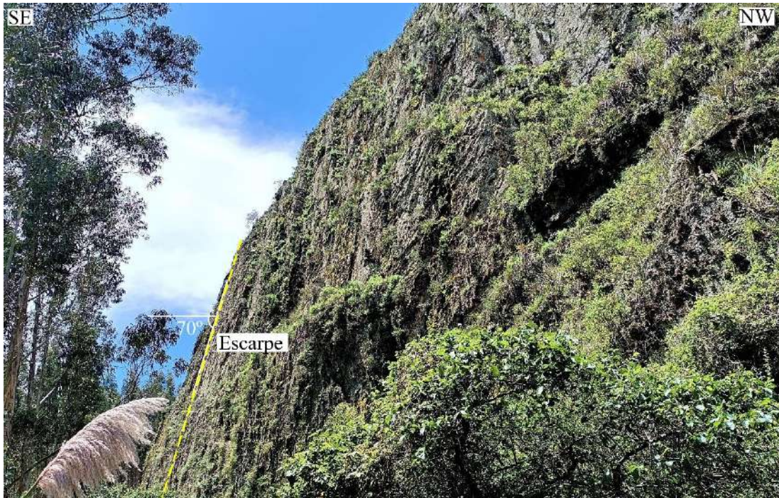
Fotografía 14. Escarpe en la margen derecha de la Quebrada Las Vizcachas. N: 9213759, E: 773808 cota:2871
