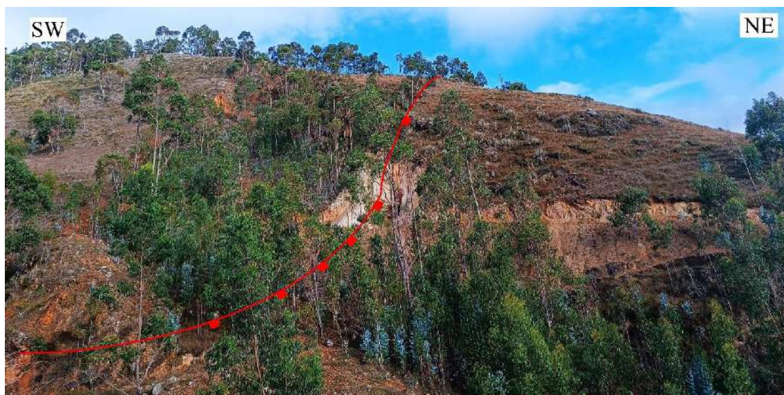
Fotografía 75. Vista panorámica de la falla F-24, N: 9212378, E: 772427, Cota:2933 m.s.n.m.
