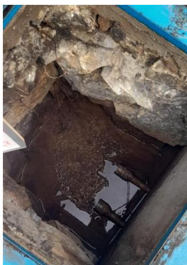
Figura 19: Vista de la zona de afloramiento de la captación N.º 2
