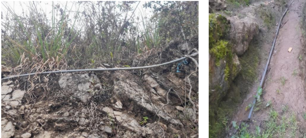
Figura 45: Vista de la captación en el Sistema N.º 1
