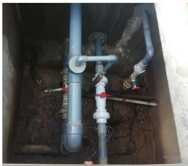
Figura 46: Caja de válvulas del reservorio del Sistema N.º 1
