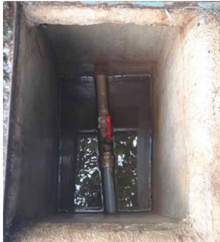
Figura 28: Vista de la cámara seca de la captación, Sistema N.º 2
