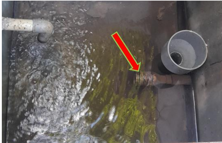
Figura 36: Vista de la canastilla de la cámara húmeda de la captación N.º 1
