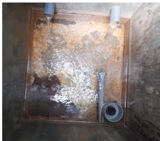
Figura 27: Vista de la cámara húmeda de la captación, Sistema N.º 2
