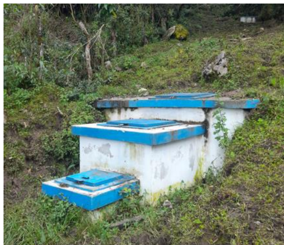
Figura 18: Vista panorámica de la captación N.º 2
