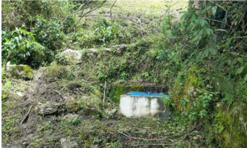
Figura 16: Vista panorámica de la captación N.º 1
