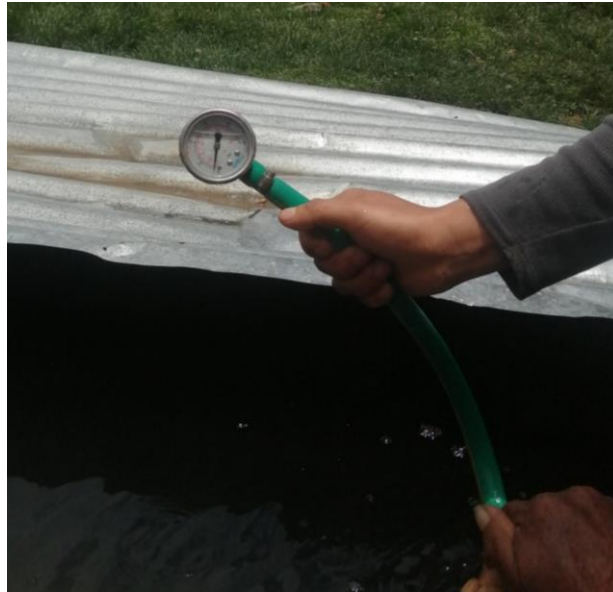
Figura 54: Desperdicio de agua en conexión domiciliaria del Sistema N.º 2
