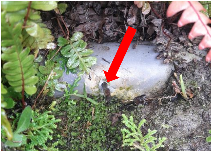
Figura 52: Tubería perforada en la red de distribución del Sistema N.º 2
