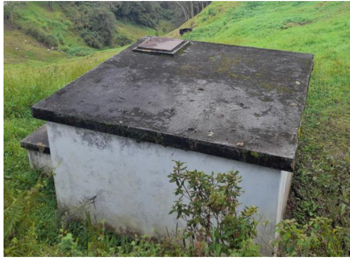
Figura 30: Caja de válvulas en el reservorio del Sistema N.º 2
