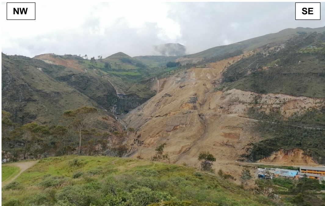
Figura 3.14. Vista frontal del deslizamiento con longitud de 500 m. y 200 m de ancho, delimitados por las quebradas: El Chorro y El Cauce.
