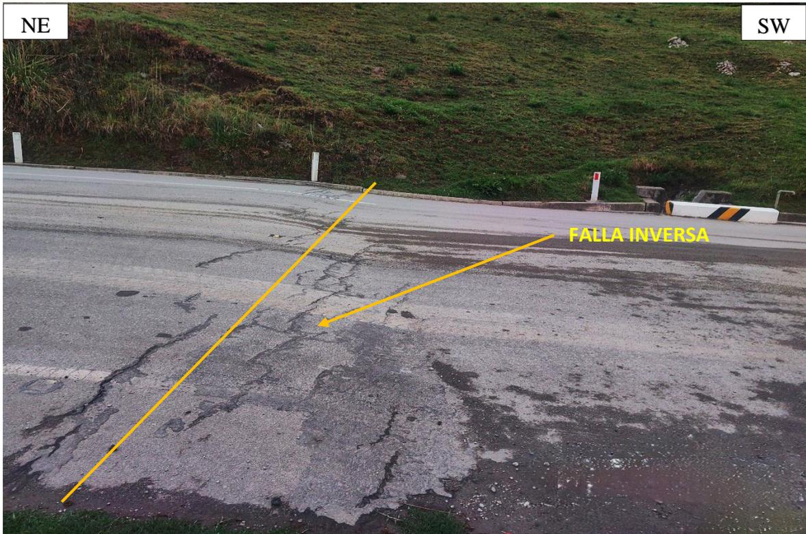
Figura 3.21. Falla geología inversa regional de orientación Az/Bz:  $N155^{\circ}/36^{\circ}SW$  ubicada en la carretera Hualgayoc – Bambamarca. Coordenadas:  $N9^{\circ}255,181$ ,  $E767,589$  y  $H3,105$ .
