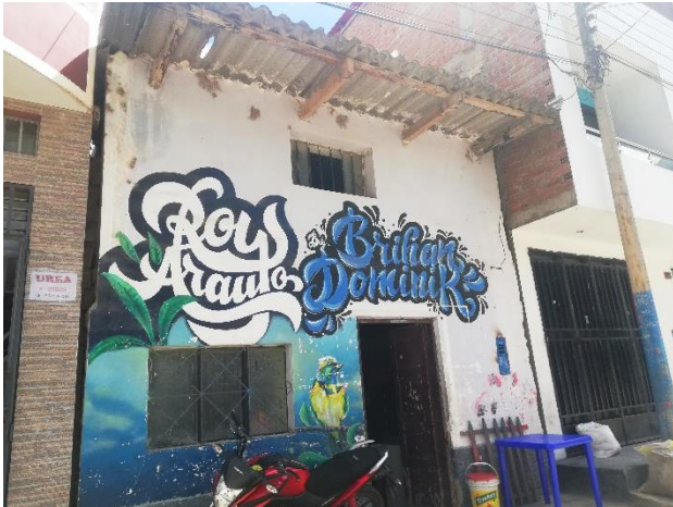
Presencia de junta sísmica
