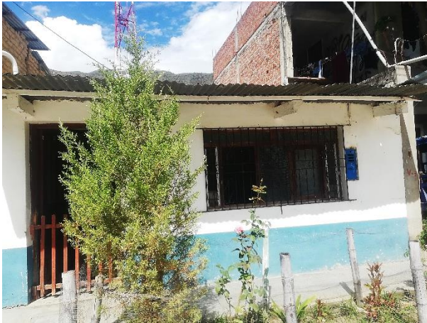
Fachada de la vivienda evaluada
