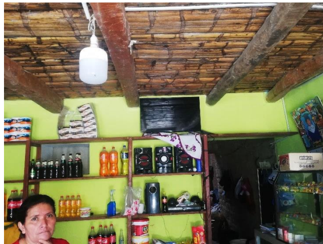
Entrepiso de cañabrava con vigas de madera en regular estado.
