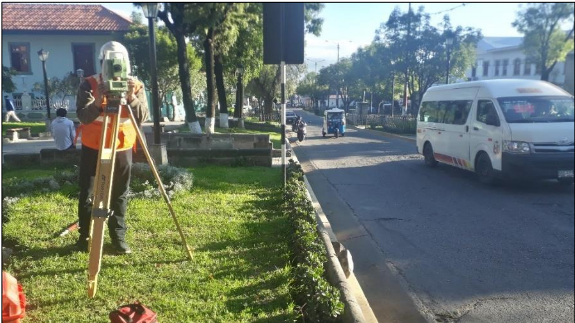
Figura 9. Uso de estación total en la vía de estudio
