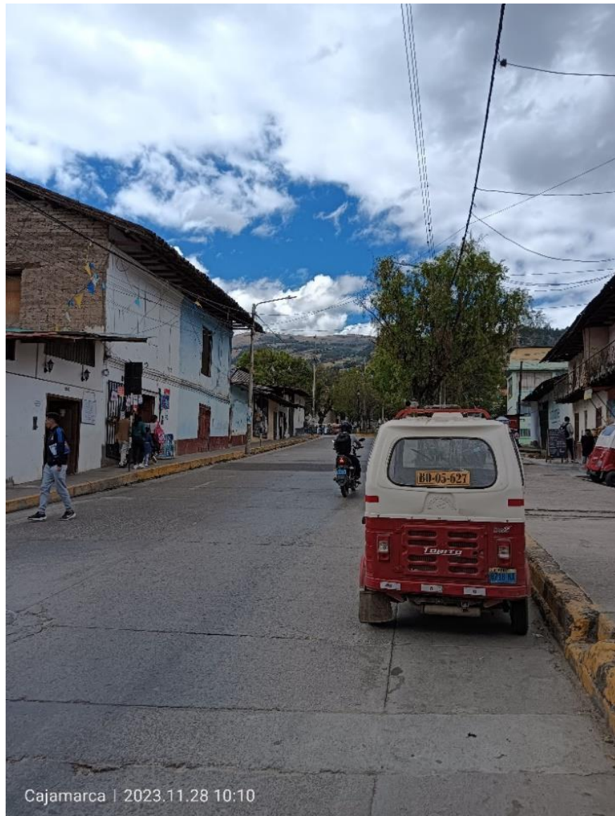
Figura 5. Parte del ancho de carril se usa como estacionamiento en la Av. El Maestro entre el Jr. Amazonas y Jr. El Inca
