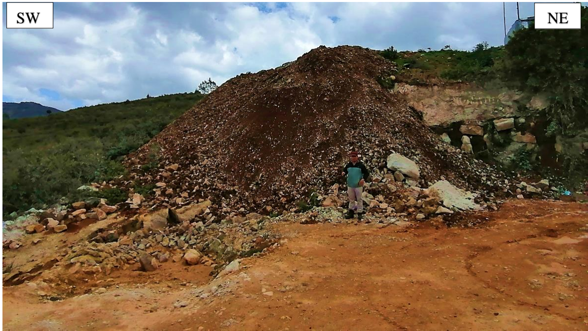
Figura 3.8. Depósito Antrópico, compuesto por fragmentación: Gruesa a fina, obtenida del área de explotación y beneficio, acumulando 4 m 3 /semana en la desmontera, no presentando parámetros geotécnicos de compactación y depositación.
