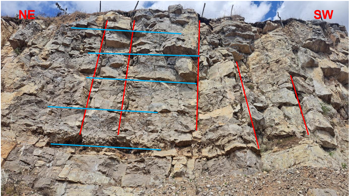
Foto 8. Familia de discontinuidades en la estación geomecánica 06
