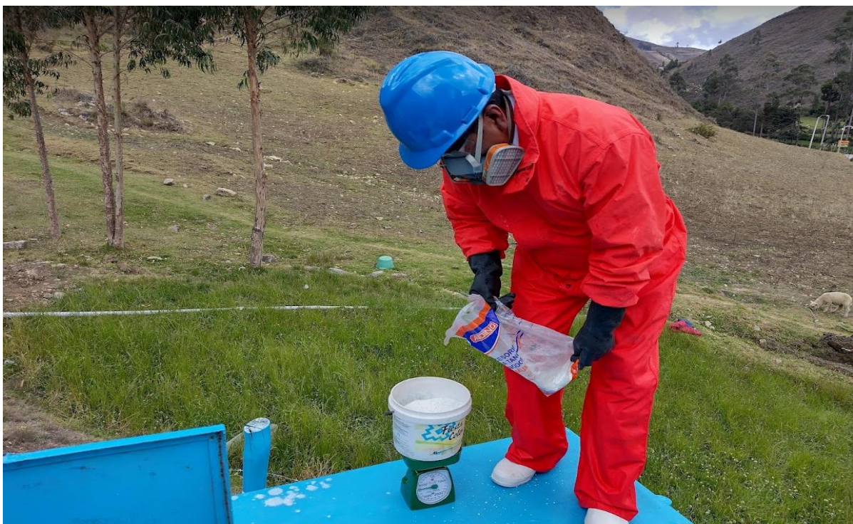
Figura 26 Cloración del sistema Juancho Puquio.
