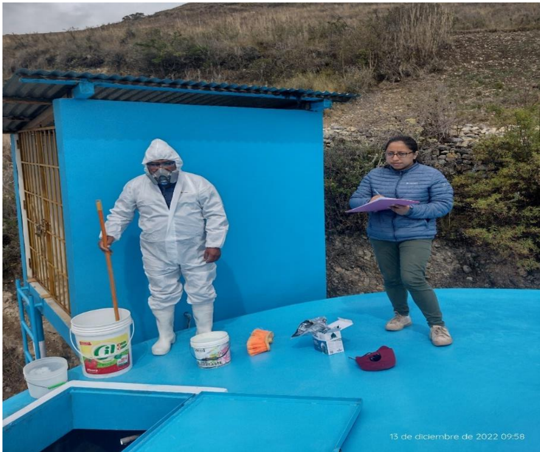
Figura 27 Cloración del sistema El Naranjillo.
