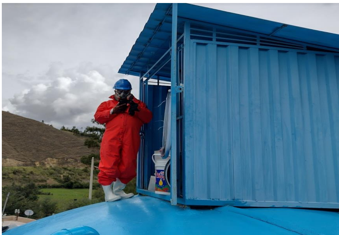
Figura 28 Operario con EPP completo para realizar la cloración del sistema.
