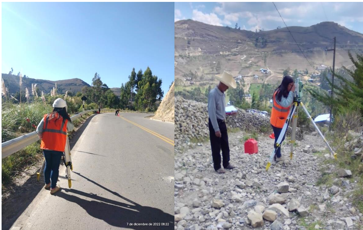
Figura 38 : Levantamiento topográfico del sistema de agua potable.
