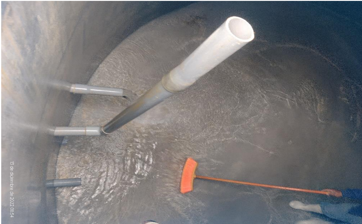
Figura 25 Limpieza del reservorio El Naranjillo.
