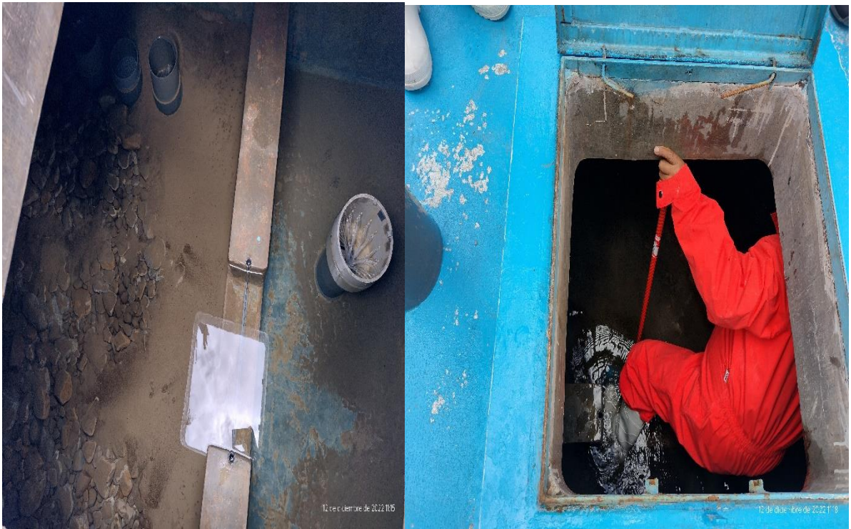
Figura 23 Limpieza de la captación Juancho Puquio.
