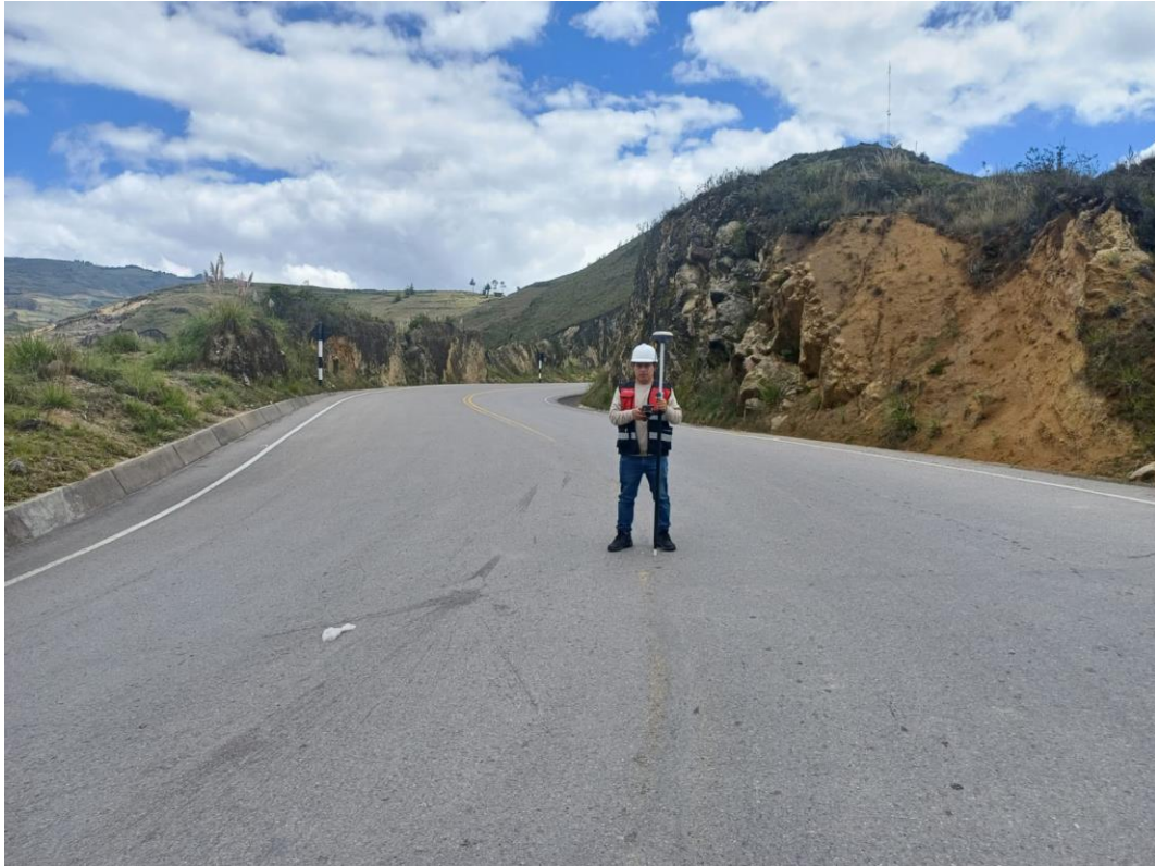
Fotografía N° 5: Levantamiento Topográfico _ Toma de datos Curva N°20 (km-01+960)
