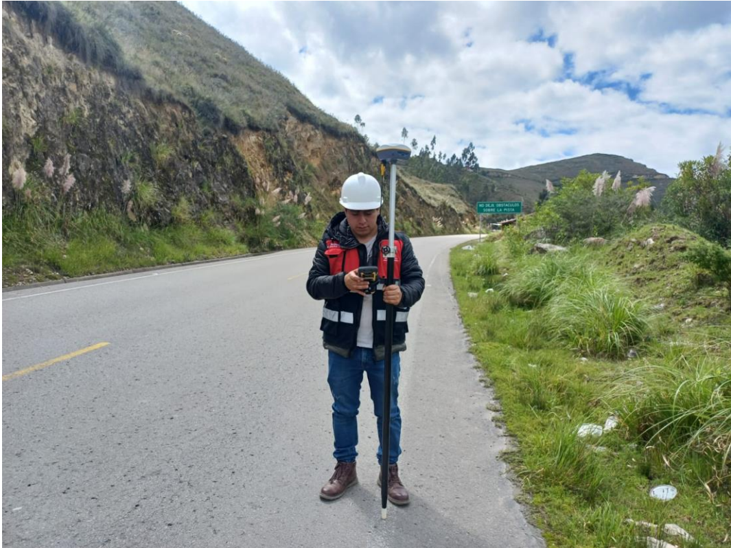
Fotografía N° 3: Levantamiento Topográfico – Toma de datos (km-00+200)
