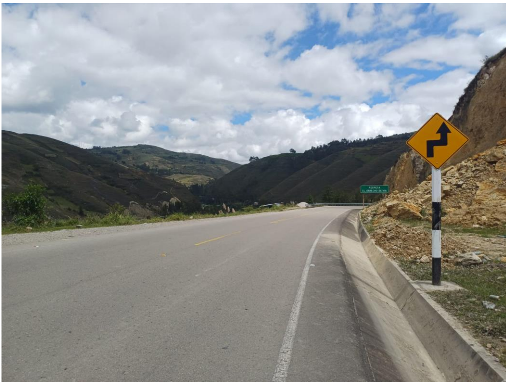
Fotografía N° 22: Señal Vertical Preventiva (Km- 02+640)
