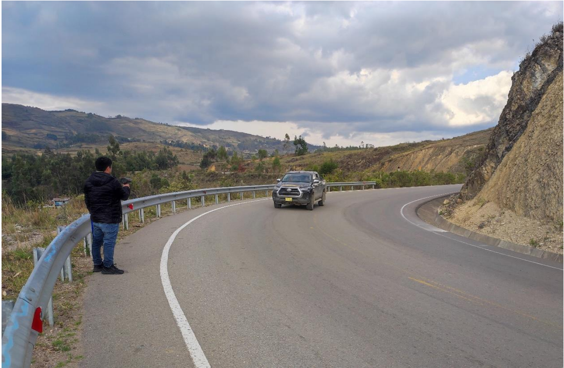
Fotografía N° 15: Medición de Velocidad de Operación, Curva N°17 (Km- 02+685)
