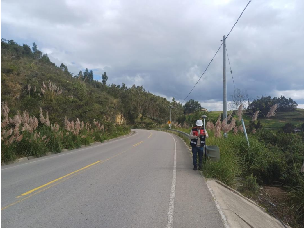
Fotografía N° 9: Levantamiento topográfico – Toma de datos en Guardavías
