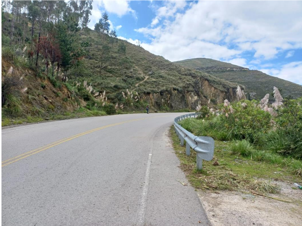
Fotografía N° 23: Dispositivos de seguridad vial – Guardavías (Km- 01+260)
