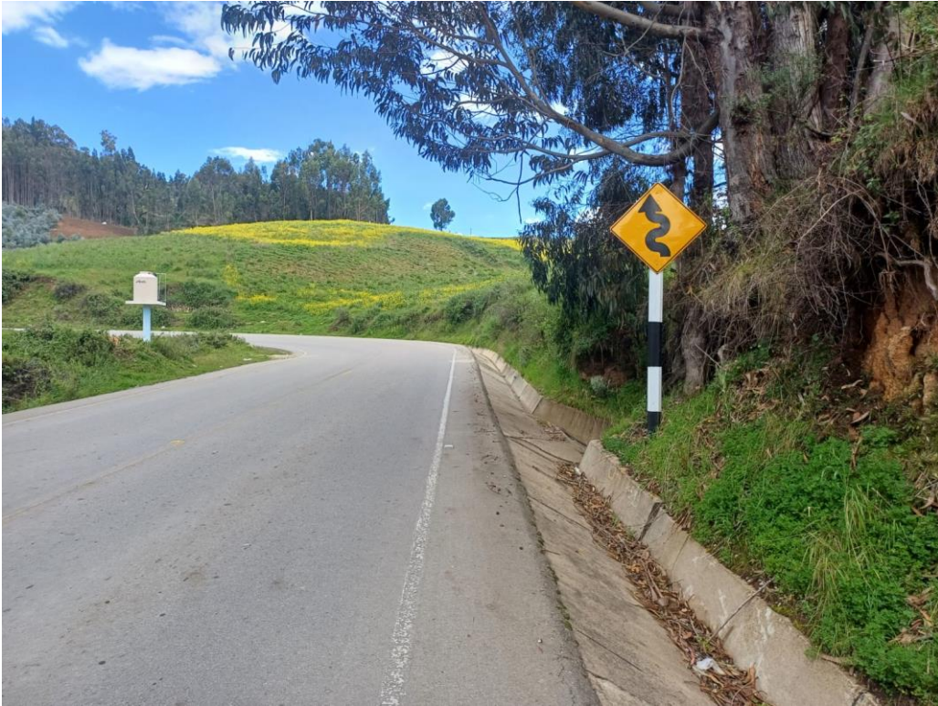
Fotografía N° 21: Señal Vertical Preventiva (Km- 05+580)
