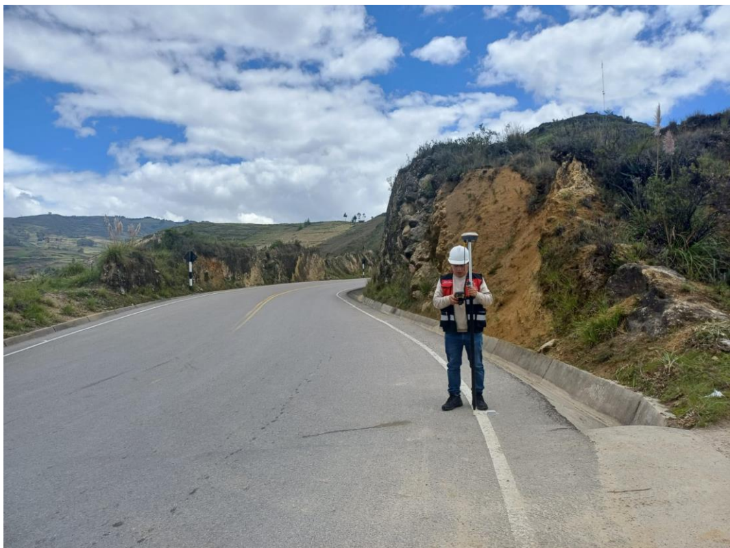
Fotografía N° 4: Levantamiento Topográfico – Toma de datos Curva N°18 (km- 01+820)
