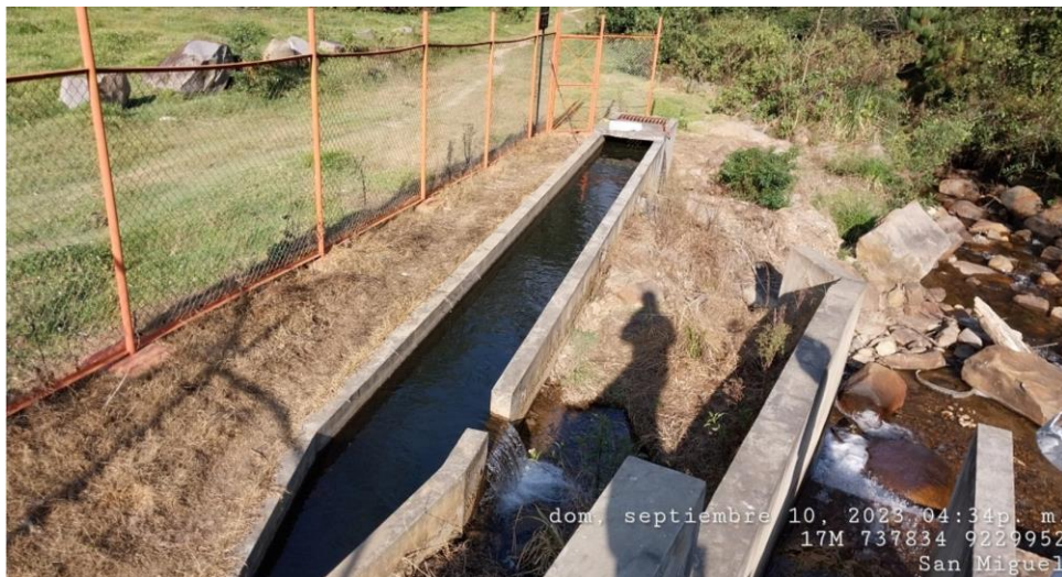
Figura 44: Desarenador del SAP San Miguel
