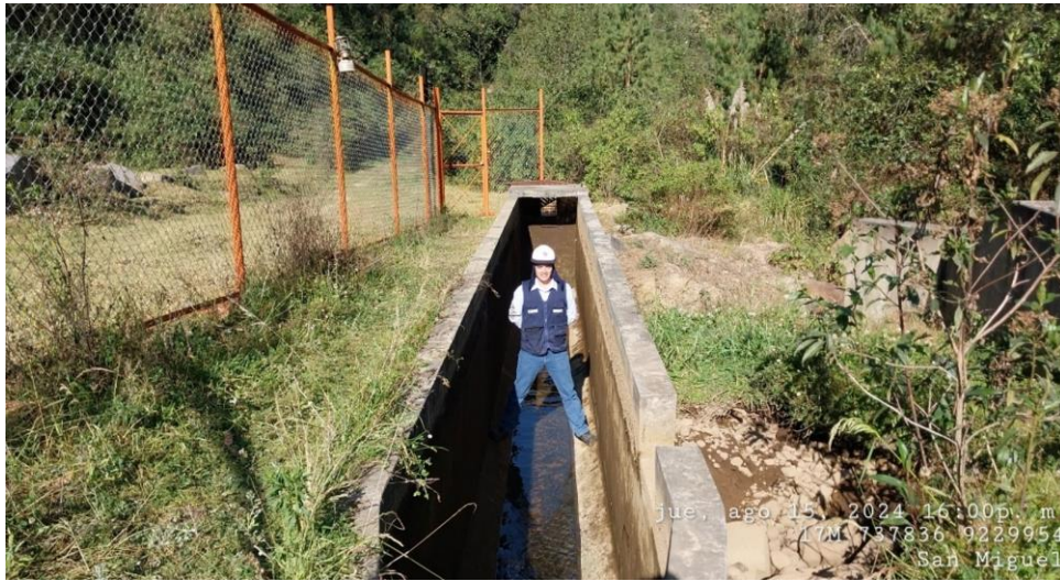
Figura 56: Desarenador del SAP San Miguel
