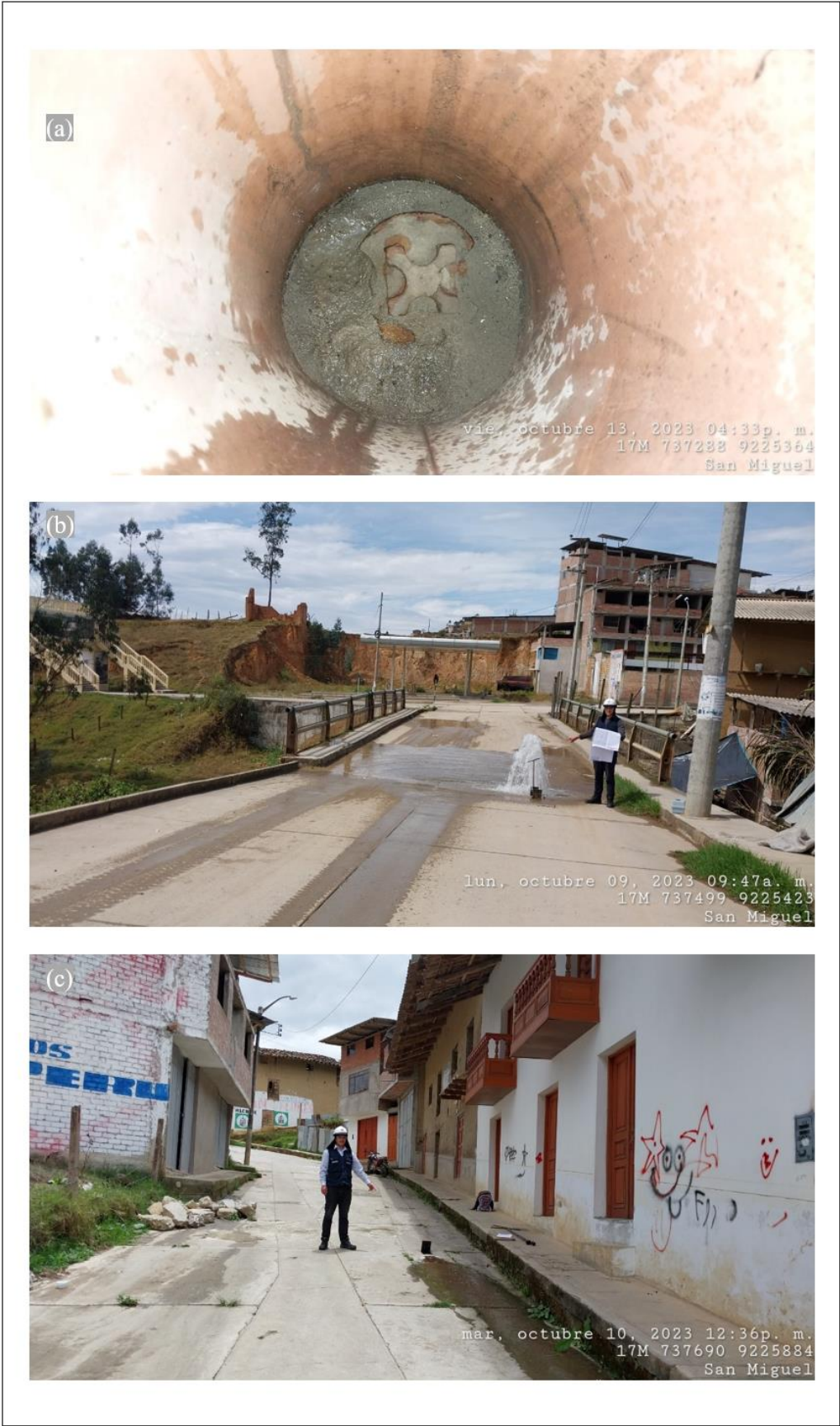
Figura 106: Válvulas de aislamiento y de purga de la red de distribución
