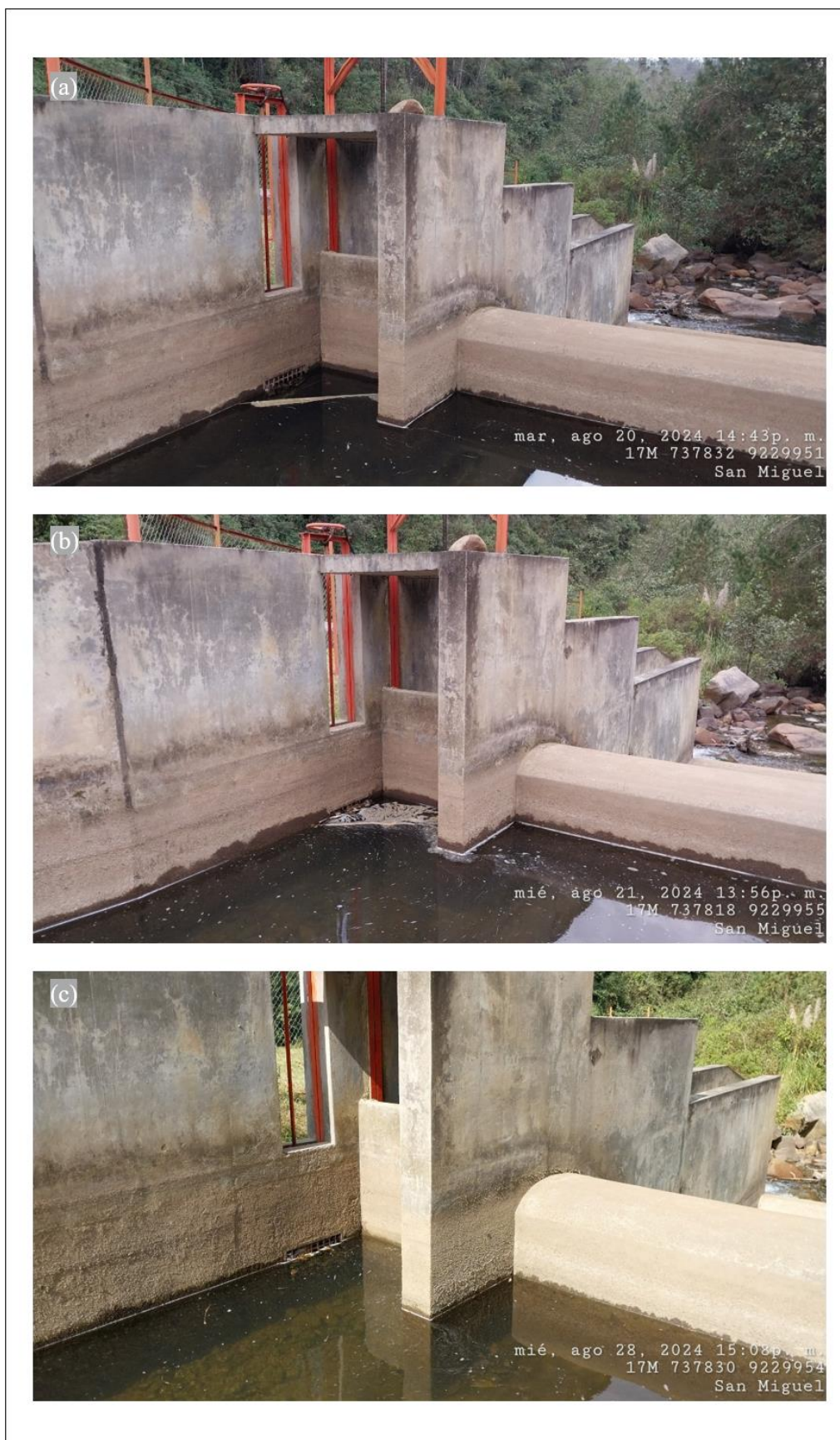
Figura 115: Profundidad de agua en el barraje, bocatoma del SAP San Miguel
