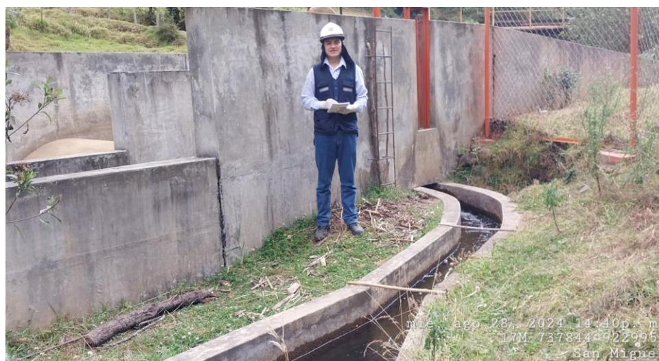
Figura 53: Aforo del caudal de ingreso en la ventana de captación del SAP San Miguel
