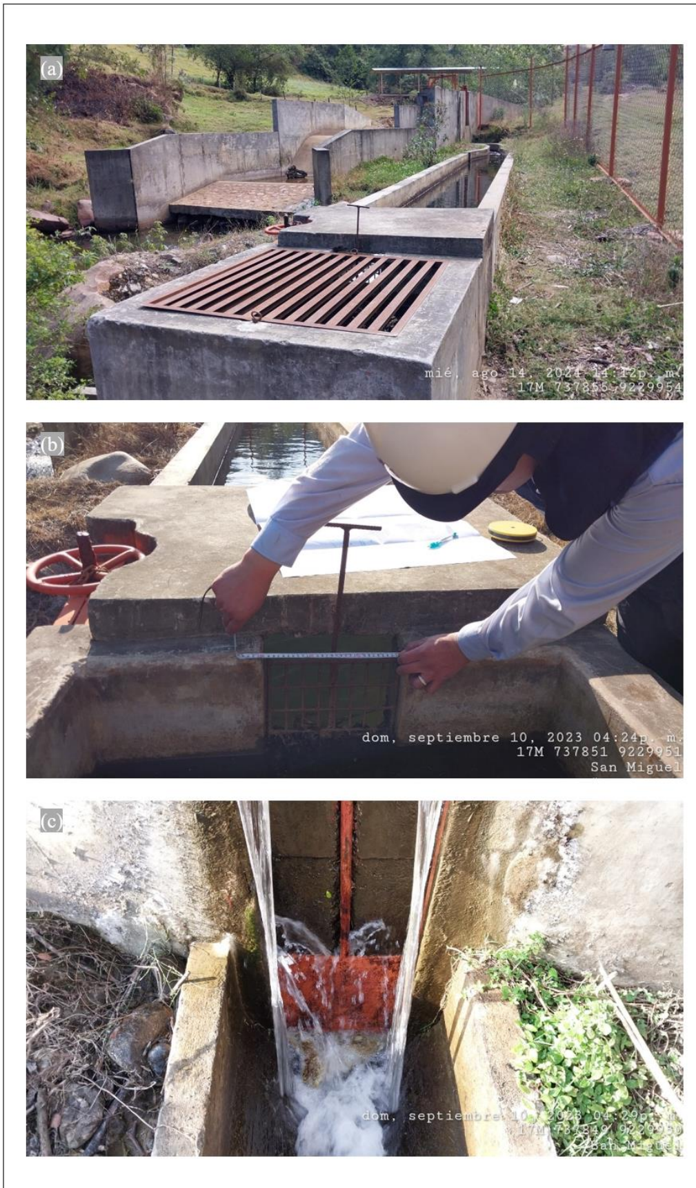
Figura 101: Desarenador del SAP San Miguel
