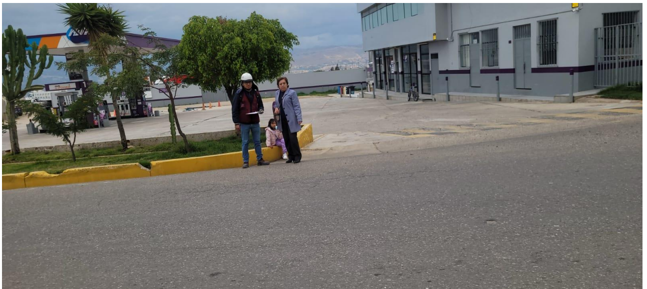
Fotografía 17 Fisura longitudinal. M46
