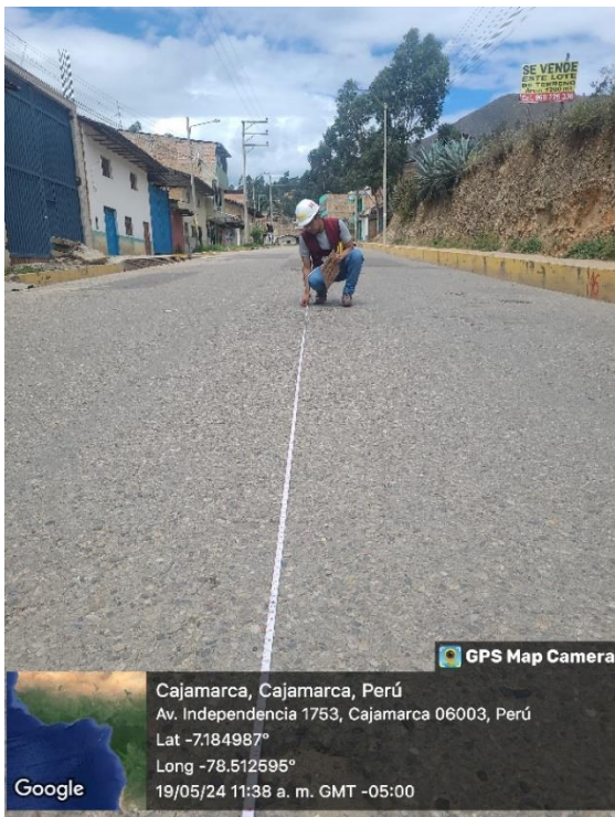
Fotografía 8 Pulimiento de agregados. M16
