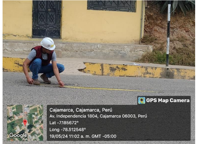
Fotografía 13 Fisuras longitudinales. M18
