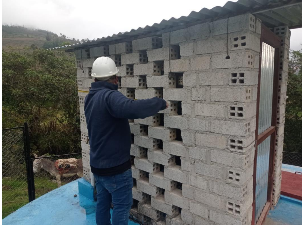
Figura 59. Toma de medidas de la caseta de cloración del reservorio de Santa Rosa.
