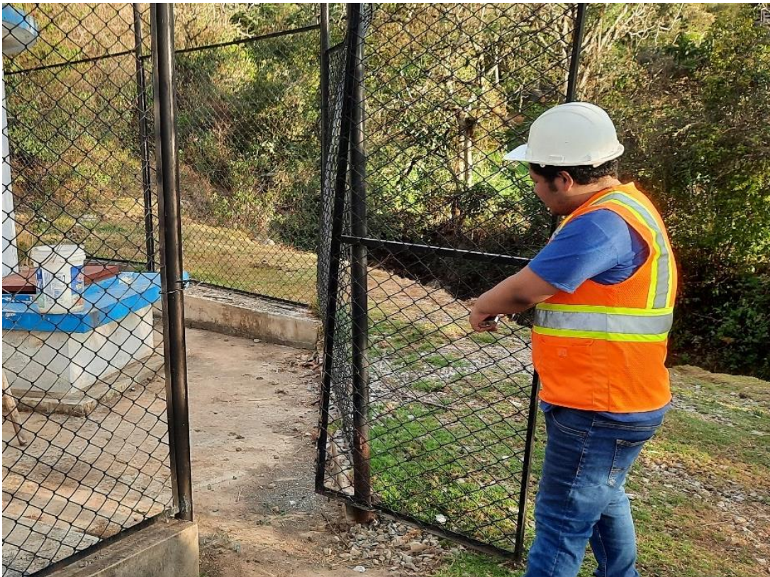
Figura 23. Vista de la puerta de acceso del reservorio, mostrando oxidación y desajuste en la parte inferior, con falta de adherencia adecuada
