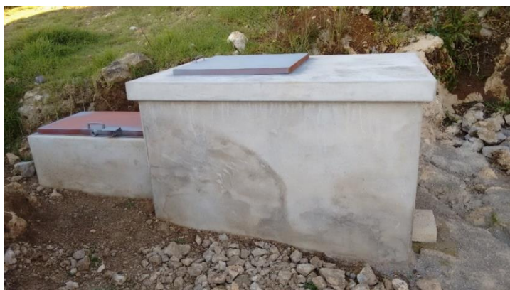
Figura 25. Vista del estado actual de la CRP -T7 2, mostrando condiciones estructurales y de regular mantenimiento
