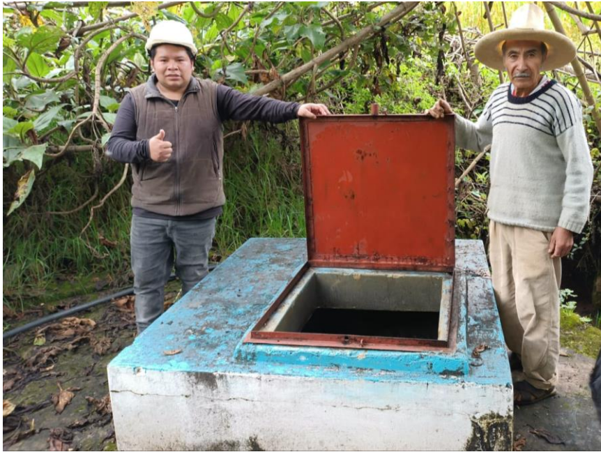
Figura 18. Vista frontal de la captación en Santa Rosa durante la inspección técnica, junto al operario del sistema de agua potable. Coordenadas UTM: Zona 17M, 817791.00 mE, 9238933.00 mN
