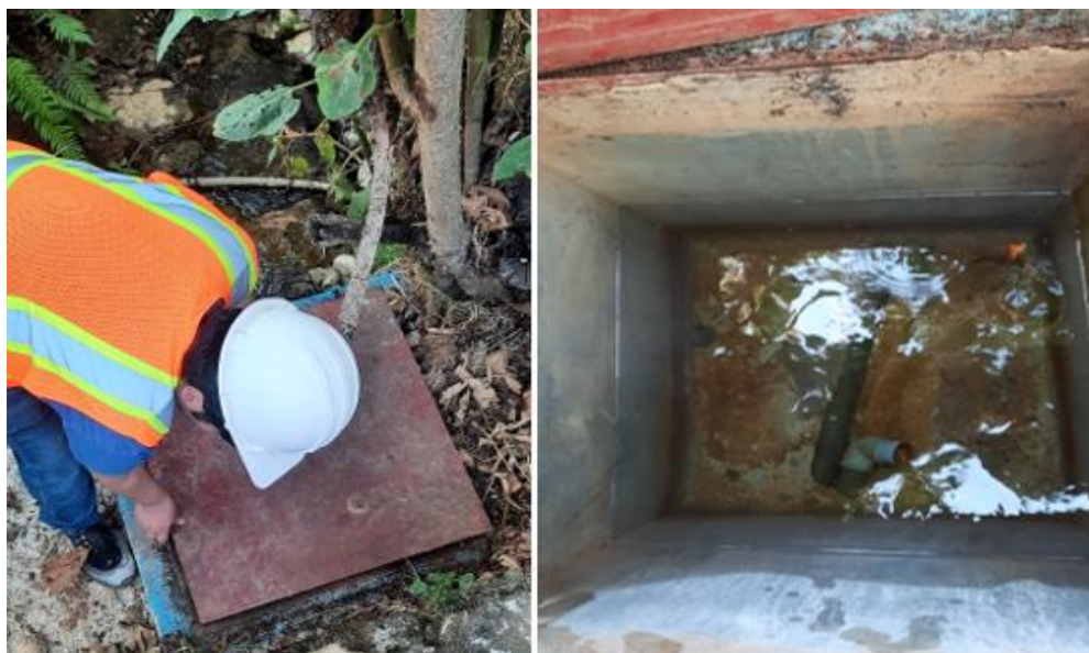
Figura 20. Revisión técnica de la cámara de válvulas en la captación de Santa Rosa: vistas externa e interna, con la tapa sanitaria desplazada en el lado derecho
