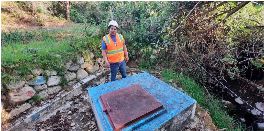
Figura 53. Vista panorámica de la captación en la evaluación hidráulica de este componente. Coordenadas UTM: Zona 17M, 817791.00 mE, 9238933.00 mN
