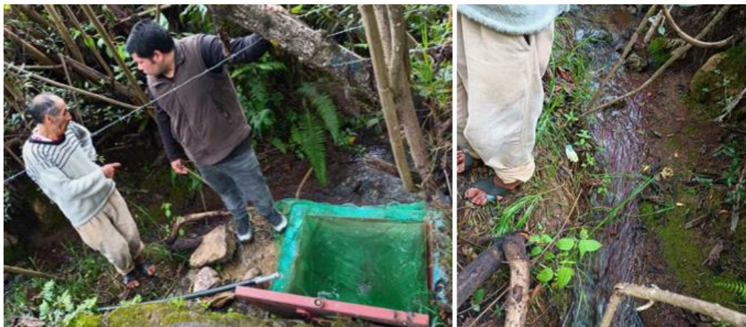
Figura 17. Inspección visual de la captación y sus alrededores para identificar signos de erosión en las márgenes de la quebrada
