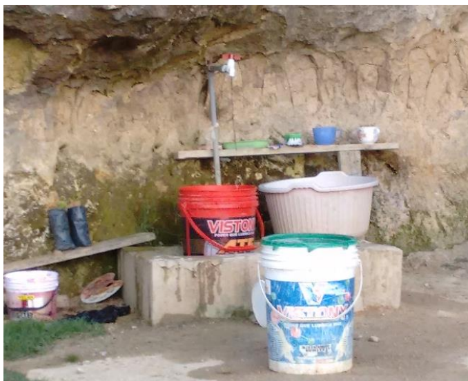
Figura 27. Conexión domiciliaria artesanal en Santa Rosa, mostrando técnicas rústicas de instalación en el sistema de agua potable
