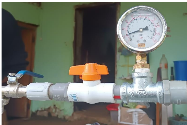
Figura 74. Verificación del funcionamiento correcto del manómetro y registro de datos en la Vivienda muestral
