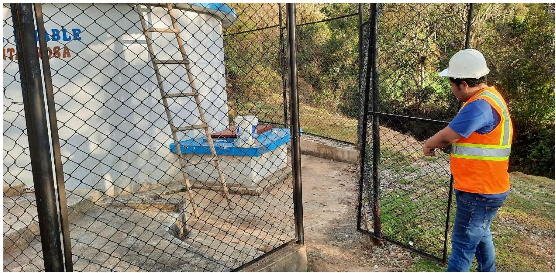
Figura 56. Inspección visual del Cerco Perimétrico del Reservorio de Santa Rosa
