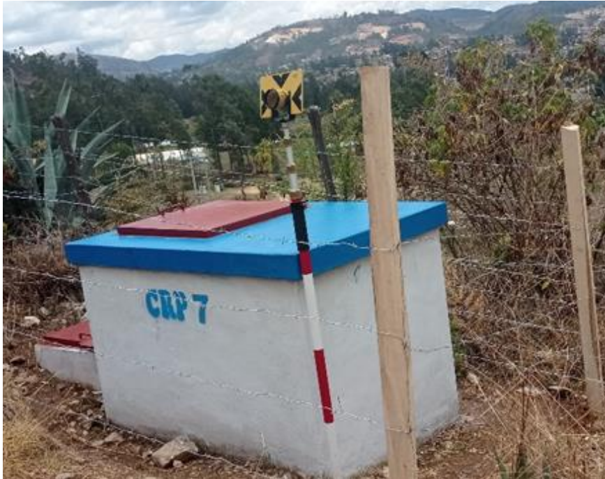
Figura 45. Toma de puntos topográficos de la Cámara rompe presión -T7 de Santa Rosa.
