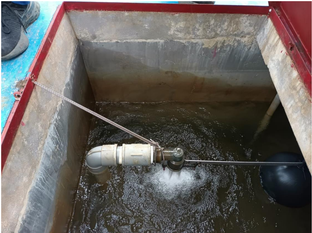
Figura 62. Vista interna de la CRP-T7 del sistema de agua potable. Coordenadas UTM: Zona 17M, 817,330.94 mE, 9,239,321.02mN
