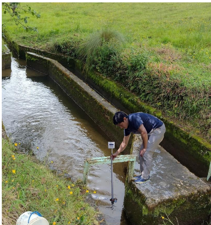
Figura N° 81: Aforo de velocidades con correntómetro FM-100V5 en la sección de entrada del desarenador de la MCH.
