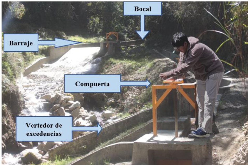
Figura N° 24: Bocatoma de barrage fijo en la quebrada Ramírez, con sus componentes hidráulicos y mecánicos.
