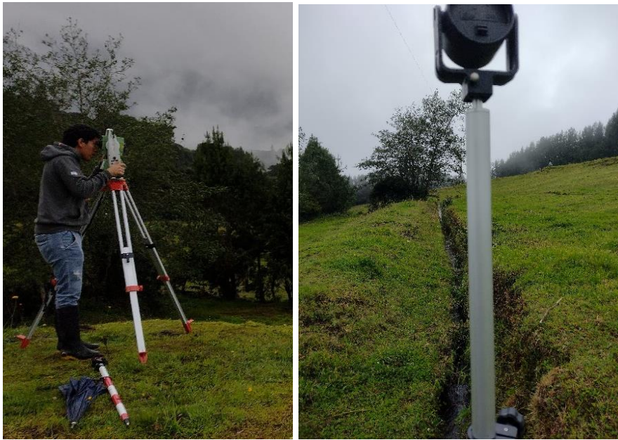
Figura N° 30: Levantamiento topográfico con estación Leyca TS06 en la zona del canal de conducción y desarenador.
