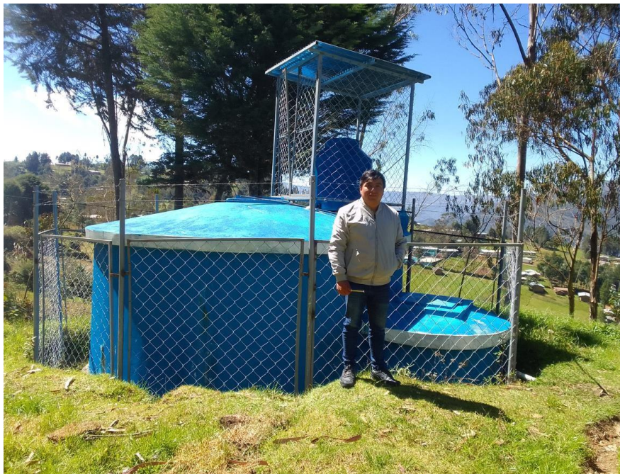
Figura 15: Reservorio de concreto
