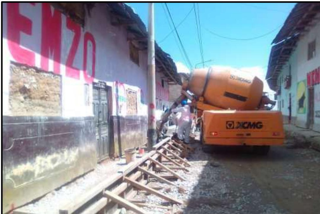
**Figura 37:** Vereda – concreto  $f'c=175 \text{ kg/cm}^2$ ,  $e=0.10 \text{ m}$  incl. Acabados y bruñado
