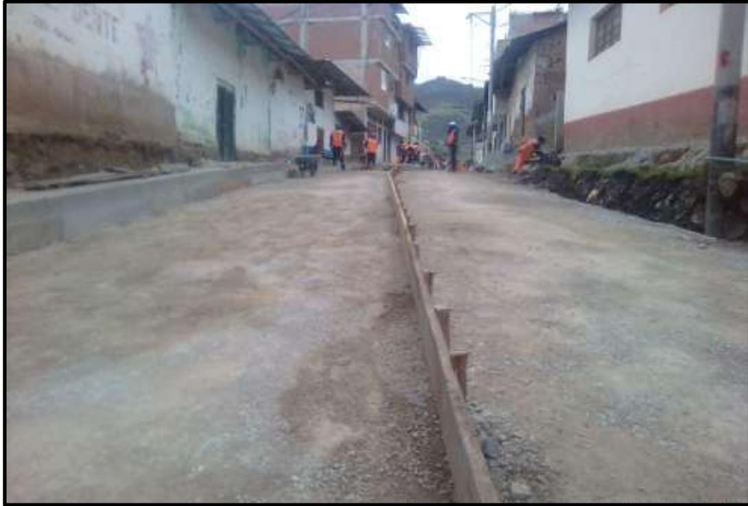
**Figura 32:** Actividad pavimentación de concreto  $f'c=175\text{kg/cm}^2$ ,  $e=0.20\text{m}$
