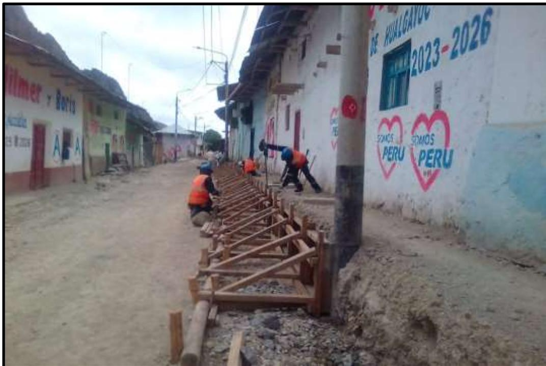
**Figura 35:** Maestrando observando la actividad de encofrado de vereda
