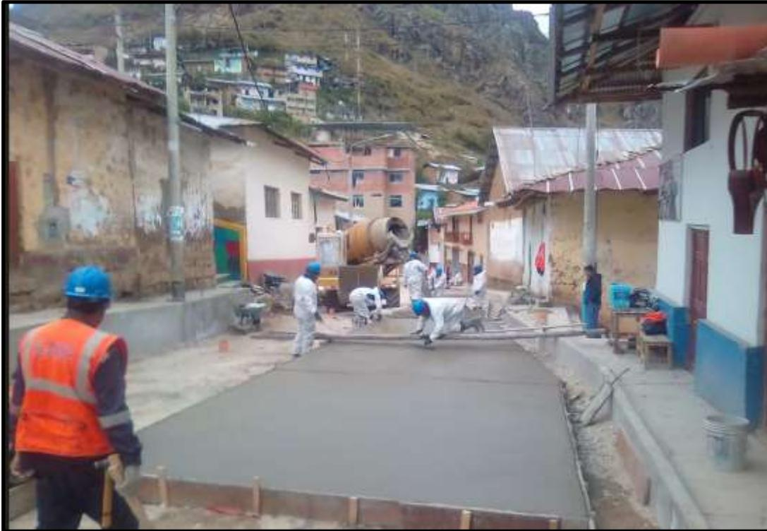
**Figura 34:** Se observa la actividad de vereda- encofrado
