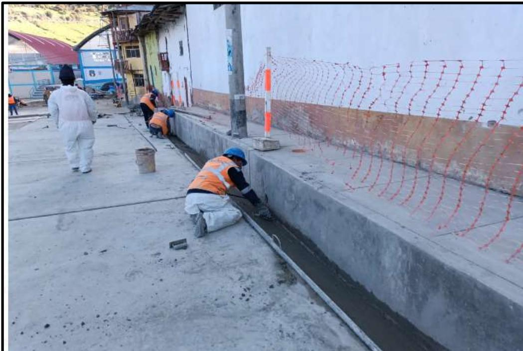
**Figura 39:** Se observa personal operario realizando trabajo de acabados en cunetas de concreto  $f'c=175 \text{ kg/cm}^2$
