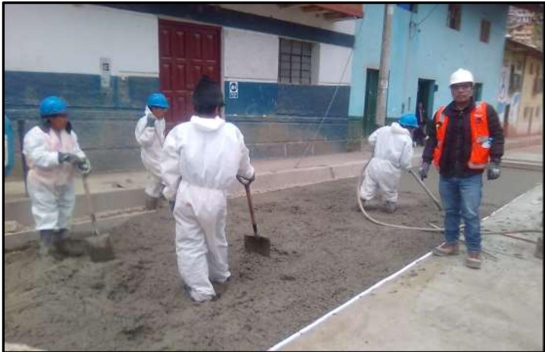
**Figura 33:** Se observa actividad vaciado de concreto  $f'c=210\text{kg/cm}^2$ , con carmix 3.5 m<sup>3</sup> en pavimento rígido.
