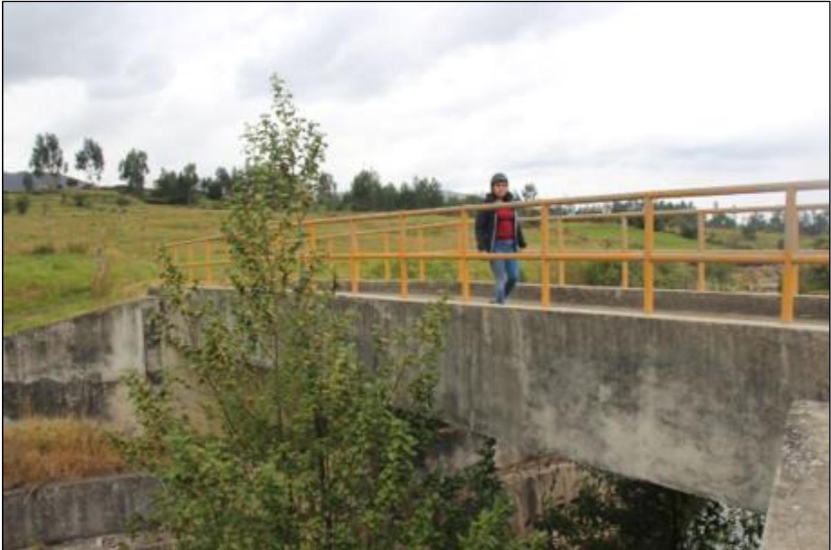
Figura 20: Ubicación de infraestructura de un puente en el tramo en estudio.
