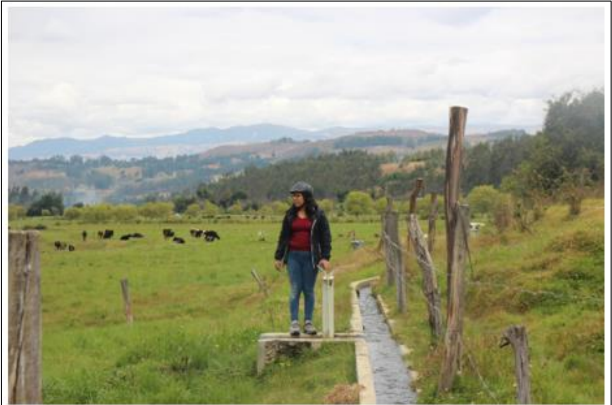
Figura 18: Canales de irrigación que serían afectados.
