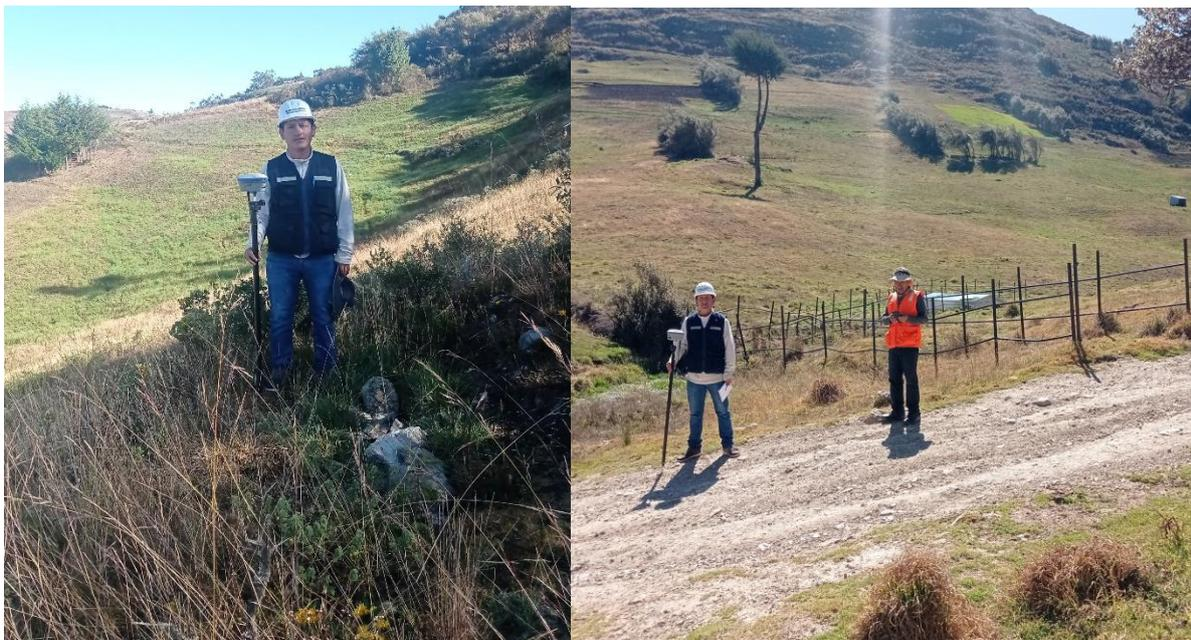
Nota: La fotografía muestra el levantamiento topográfico con GPS DIFERENCIAL CHCNAV i90 en toda la red de conducción.
