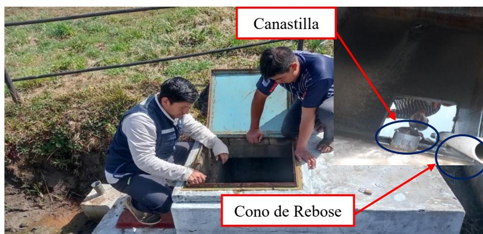
La captación está ubicada en una planicie cerca de un humedal, actualmente tiene un mantenimiento relativamente periódico con un cerco perimétrico de tubos de metal, muro de contención de roca a los costados de la estructura y con muy poca maleza. La cámara seca presenta algunas filtraciones actualmente encontrando agua en las válvulas.
