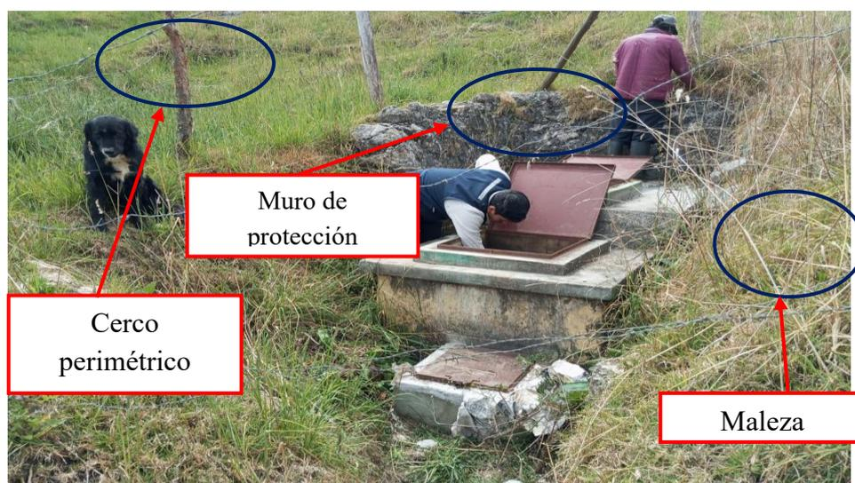
La captación está ubicada en un terreno con pendiente inclinada, actualmente no tiene un mantenimiento periódico. La cámara seca presenta tapa de inspección no pintada y en mal estado, la válvula de compuerta si está en buen estado para controlar el flujo de agua.
