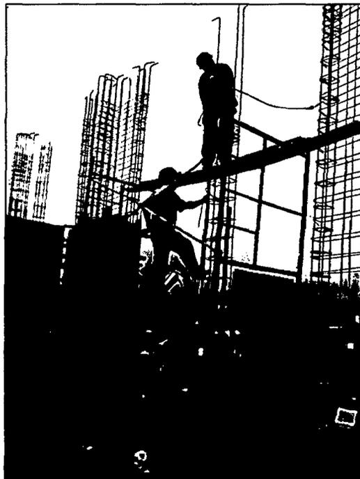
Figura 2.3 Armado de columnas y placas del último nivel
