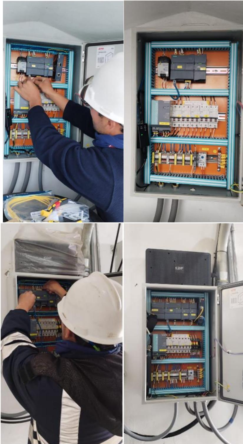
*Fig. 52: Instalación de controlador lógico programable*
