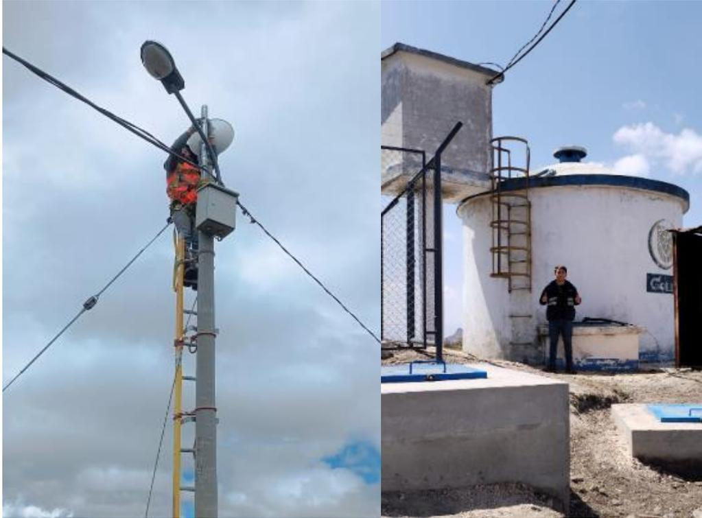
*Fig. 24. Montaje de receptor en poste del reservorio*
