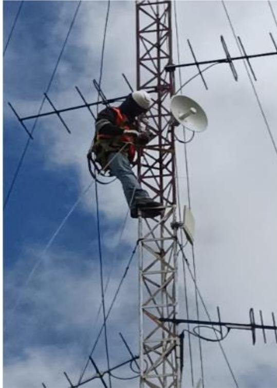
*Fig. 19: Fijación del equipo ePMP™ Force 300-25*
