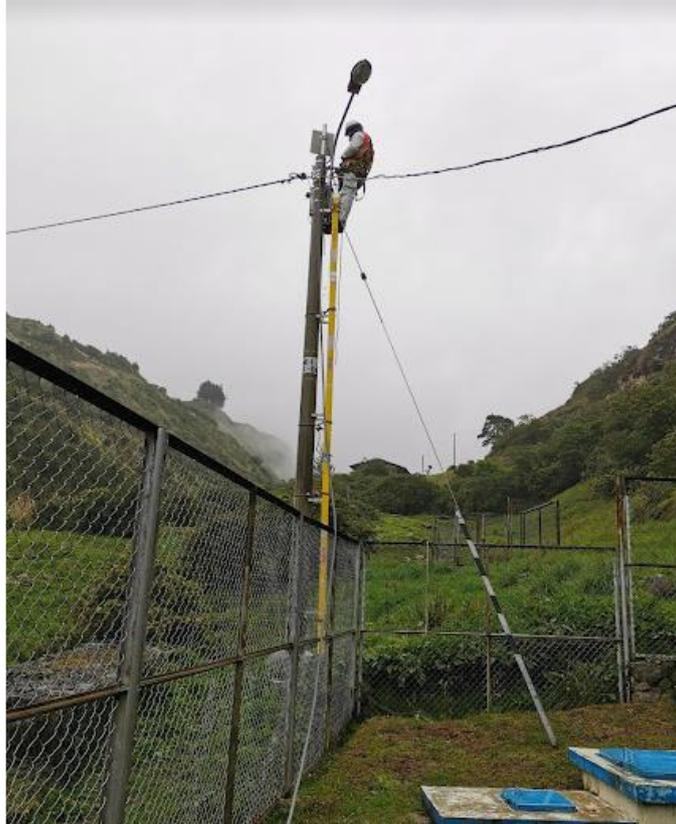
*Fig. 21: Montaje de receptor en poste de estación N°1.*
