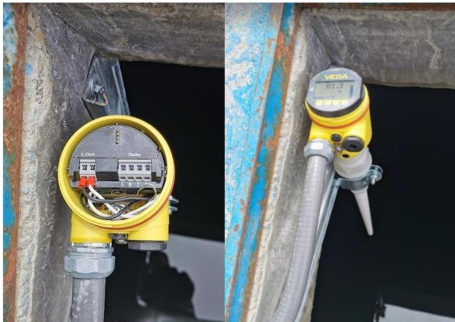
Fig. 54: Instalación de sensor ultrasónico en reservorio principal.
