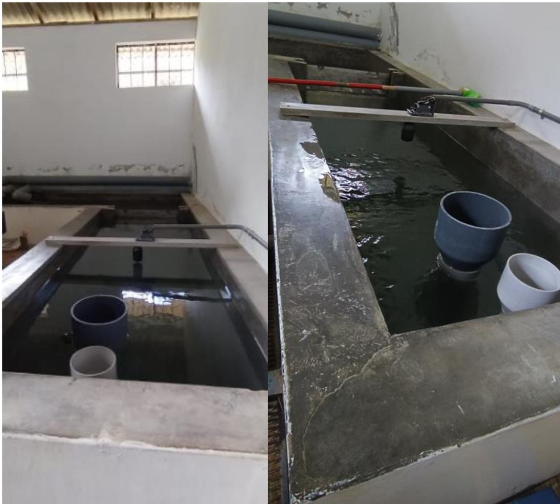
*Fig. 50: Instalación de sensor en estación 1.*
