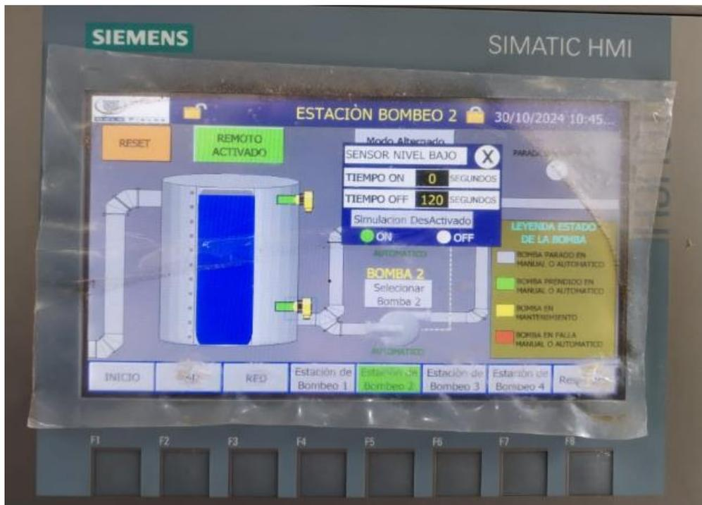
Fig. 61: Configuración de temporizador.
