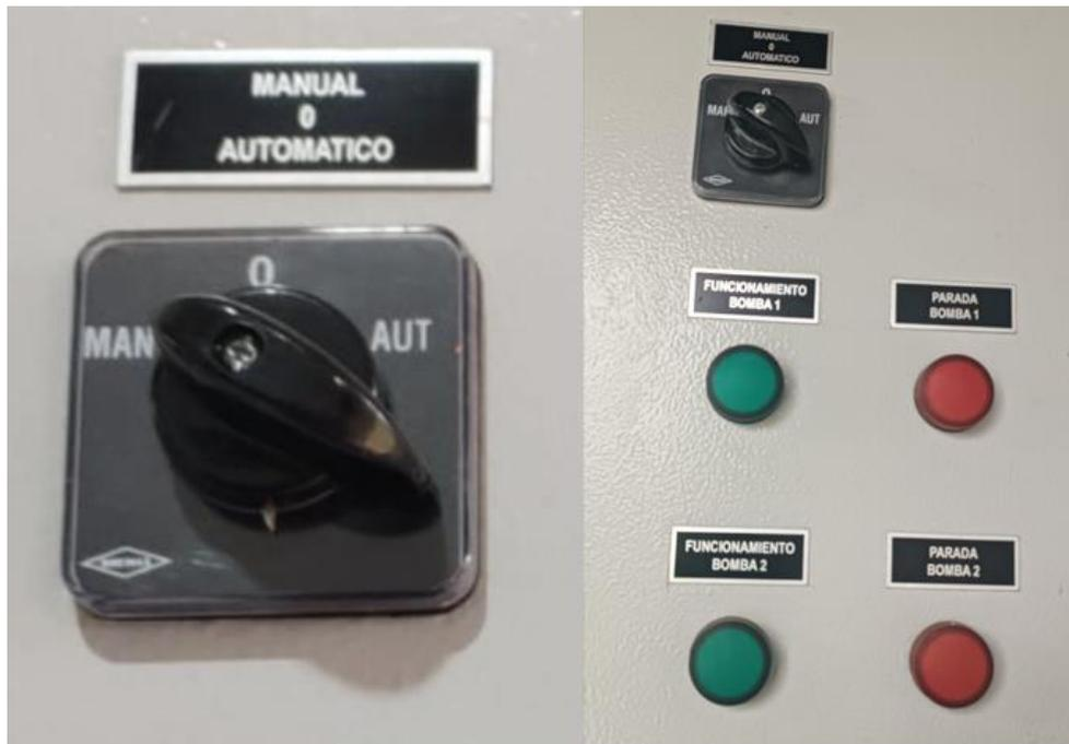
Fig. 56: Instalación de selector en tablero.
