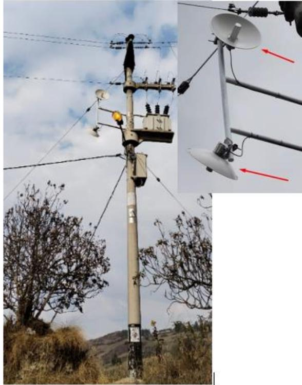
*Fig. 22: Montaje de antenas repetidoras*
