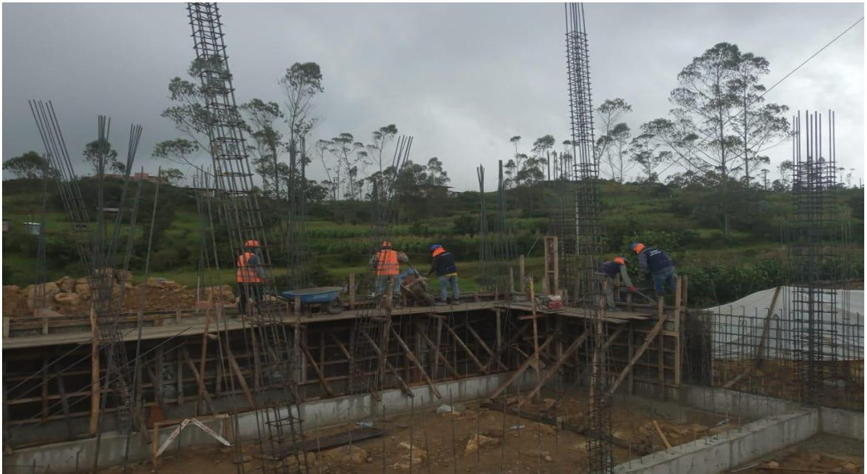
Foto 16: Vaciado de concreto en sobrecimiento armado.
