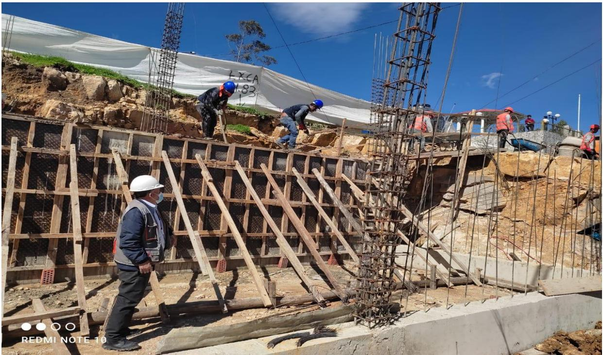
Foto 12: Vaciado de concreto en muro reforzado.
