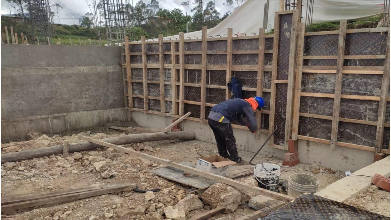
Foto 11: Encofrado de muro reforzado.
