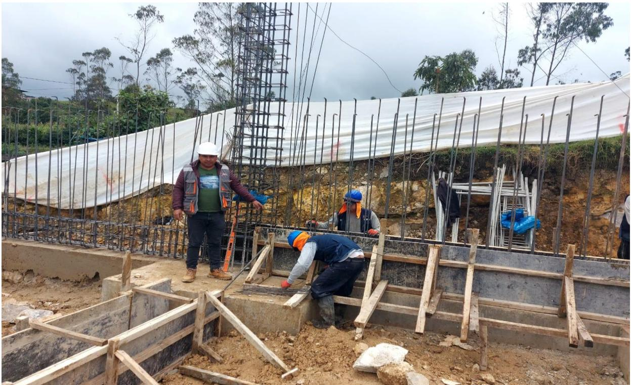
Foto 08: Encofrado de vigas de cimentación.
