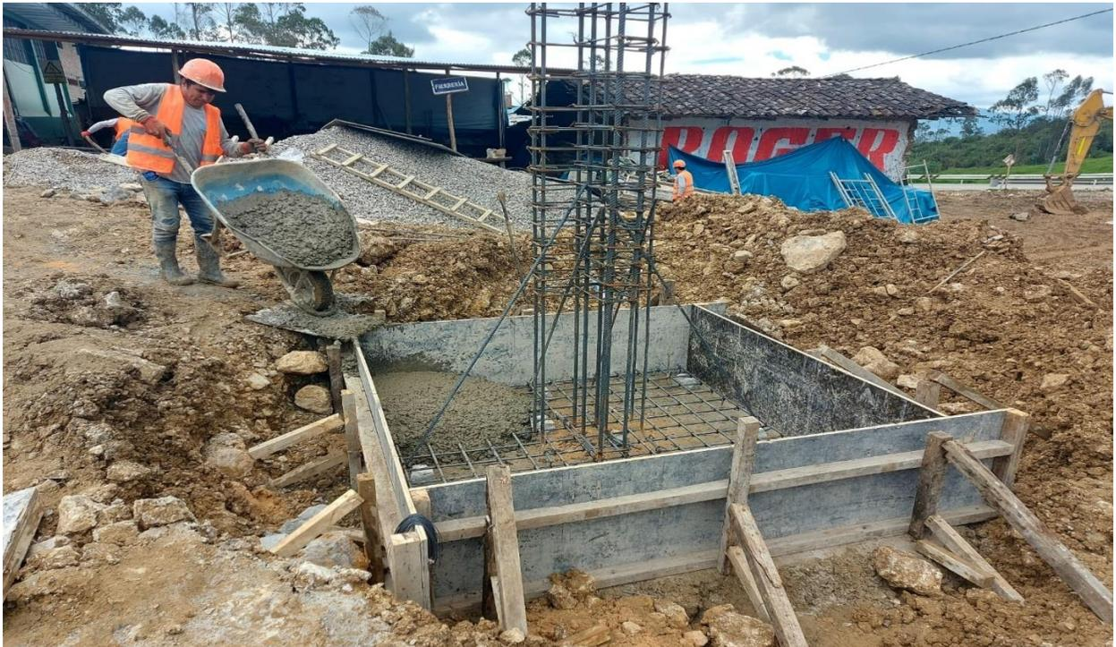
Foto 04: Vaciado de concreto en zapatas.
