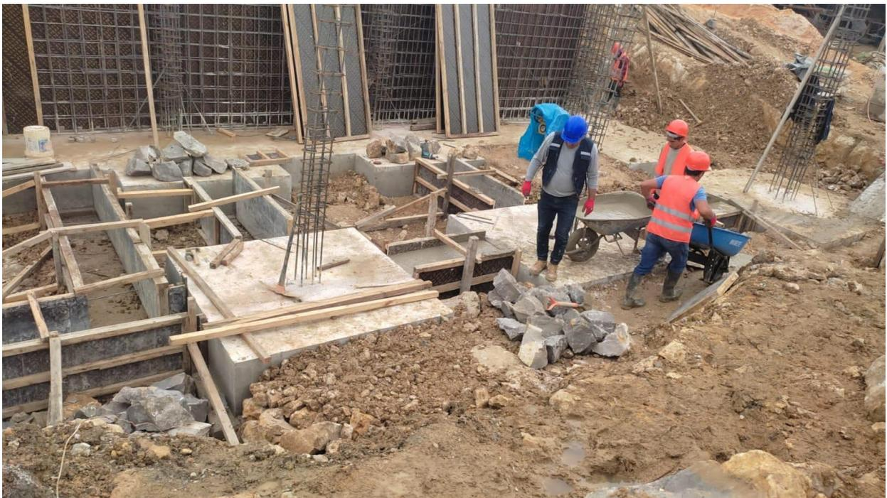
Foto 06: Vaciado de concreto en cimientos corridos.
