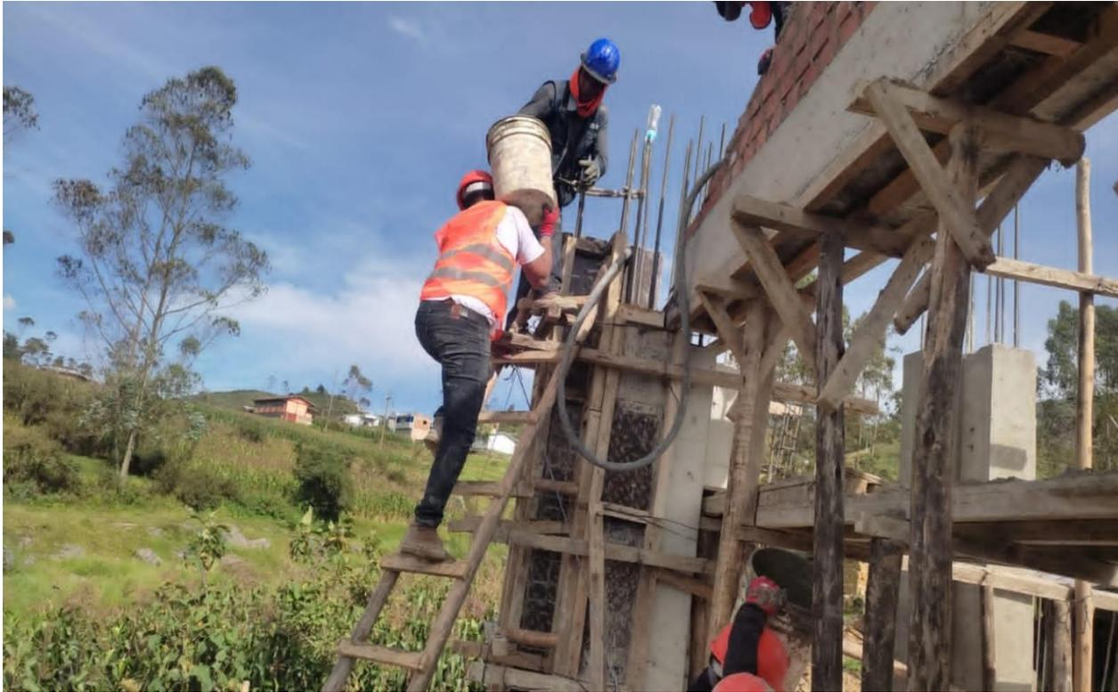
Foto 14: Vaciado de concreto en columnas.
