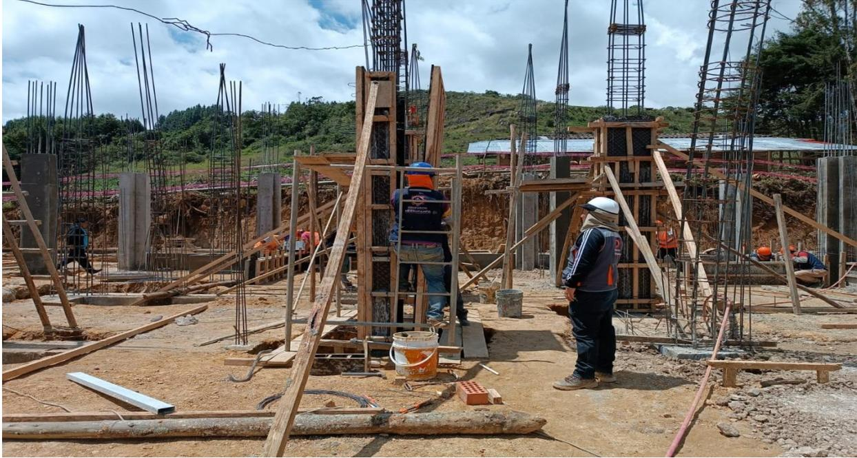
Foto 13: Encofrado de columnas.
