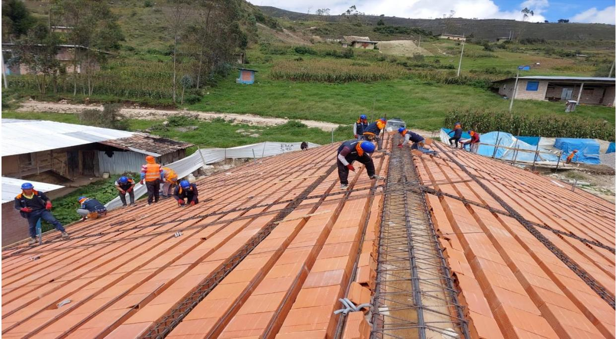
Foto 21: Acero en losa aligerada.
