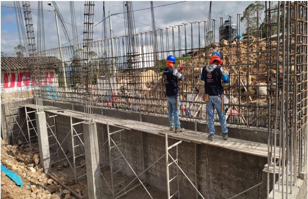
Foto 10: Acero en muro reforzado.
