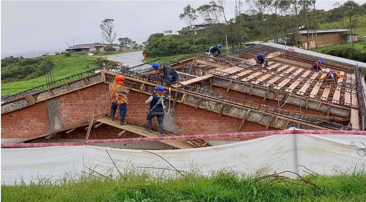
Foto 17: Encofrado de vigas.
