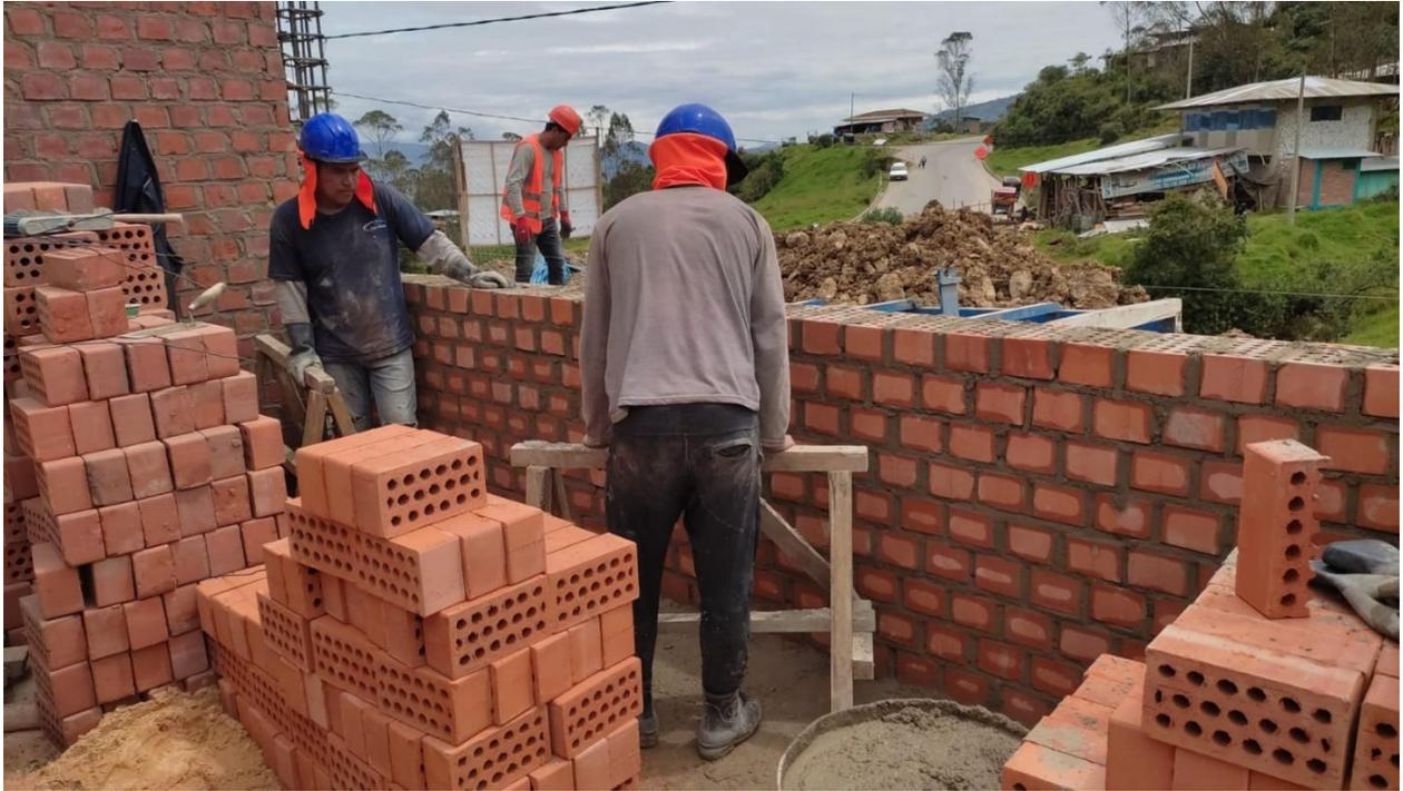
Foto 23: Asentado de muro de ladrillo KK tipo IV de cabeza.
