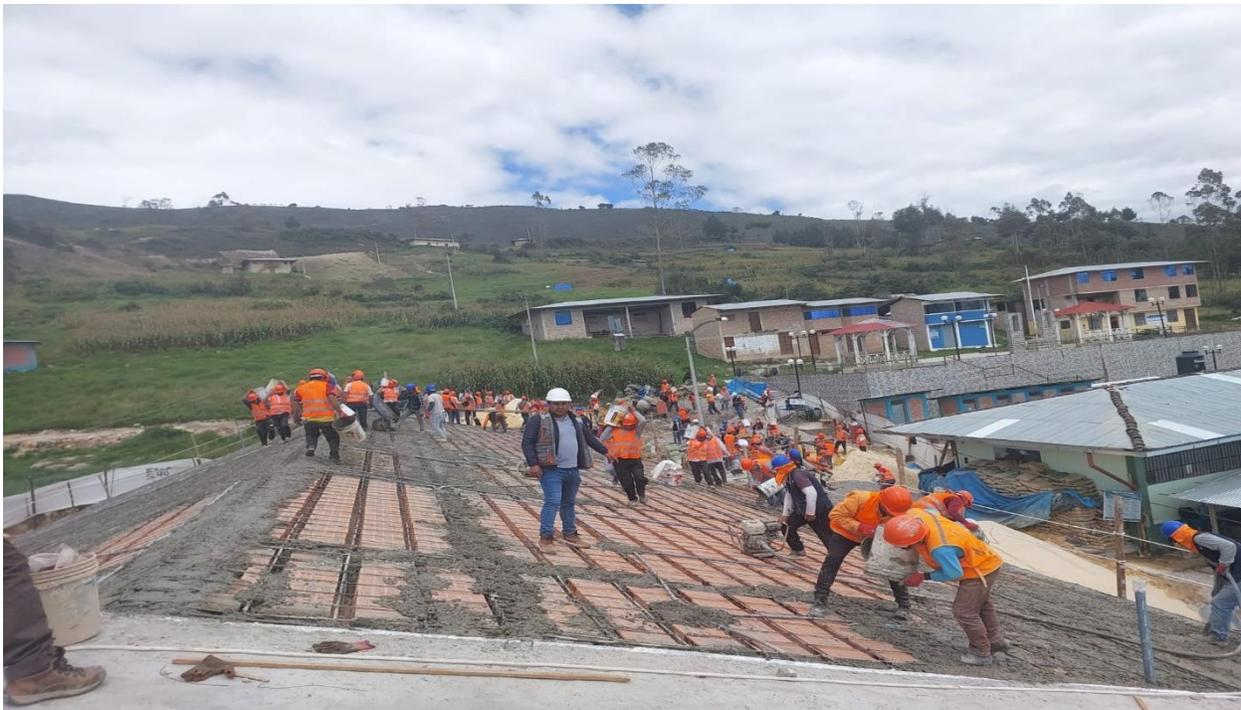
Foto 22: Vaciado de concreto en losa aligerada.
