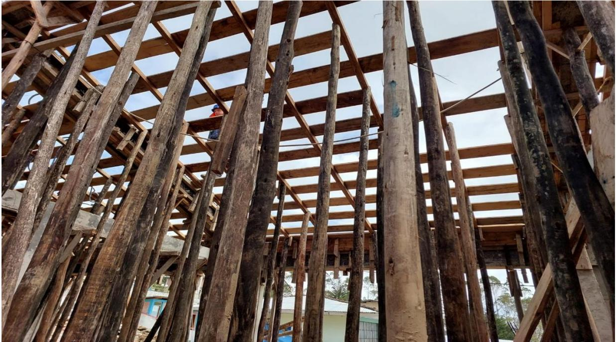
Foto 19: Encofrado de losa aligerada.
