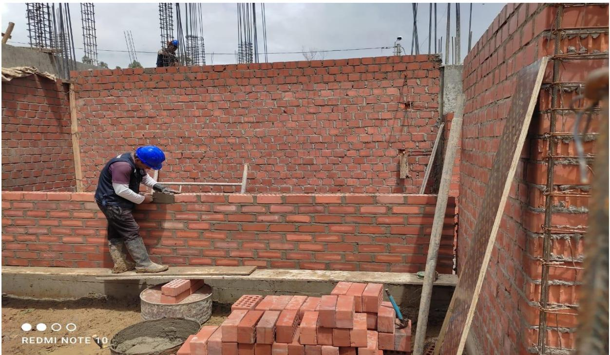
Foto 24: Asentado de muro de ladrillo KK tipo IV de soga.
