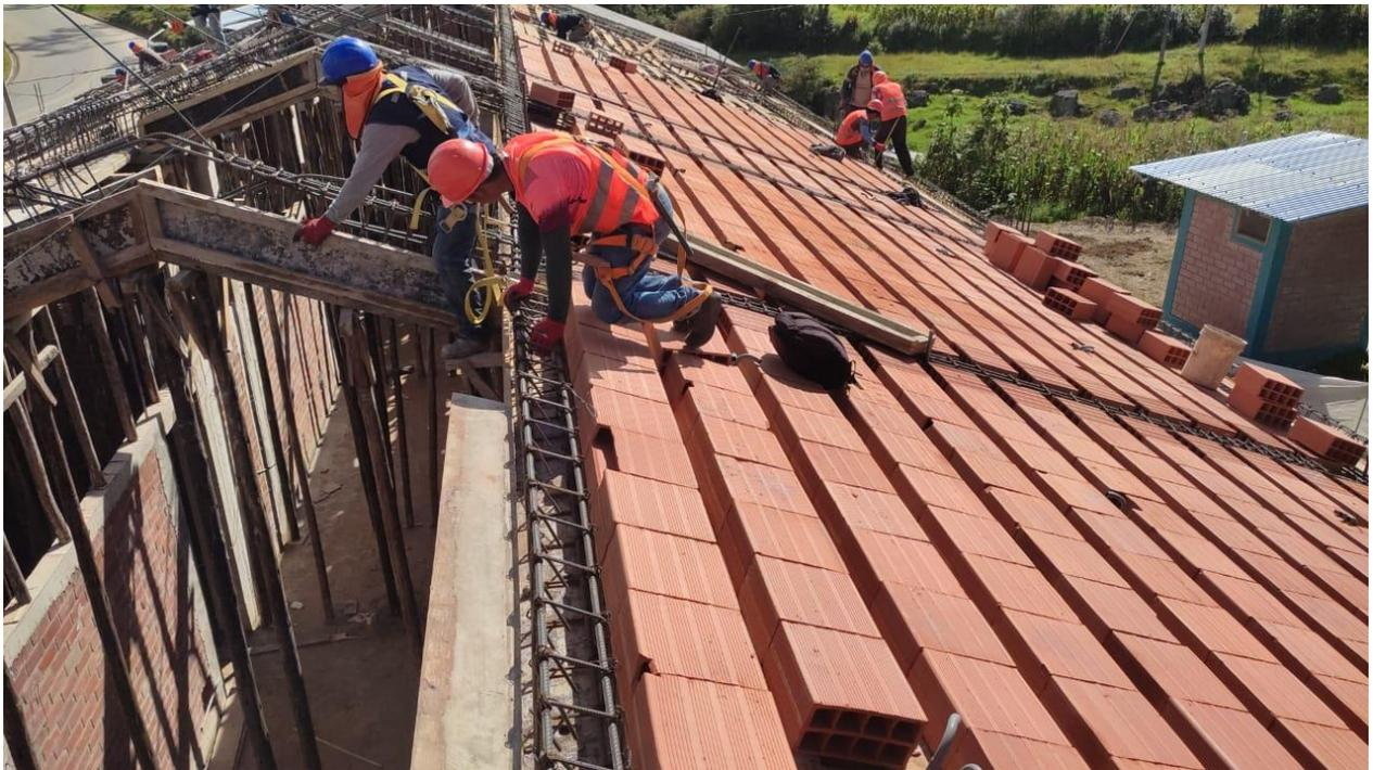
Foto 20: colocación de ladrillo en losa aligerada.
