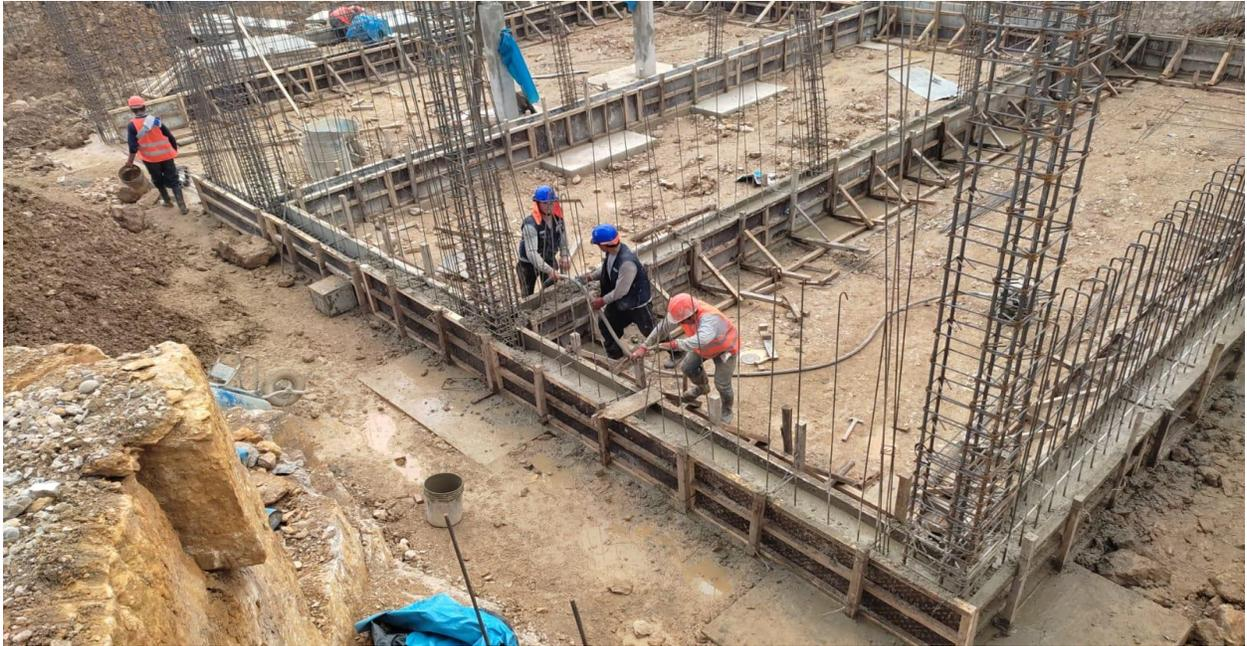
Foto 09: Vaciado de concreto en vigas de cimentación.
