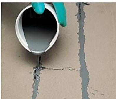
Reparación de grieta en recrido cementoso con Eporip
