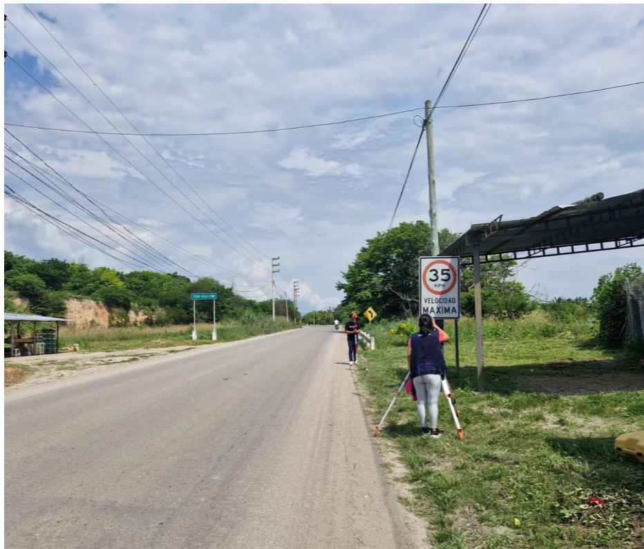
Fotografía N° 4: Toma de puntos de la berma.
