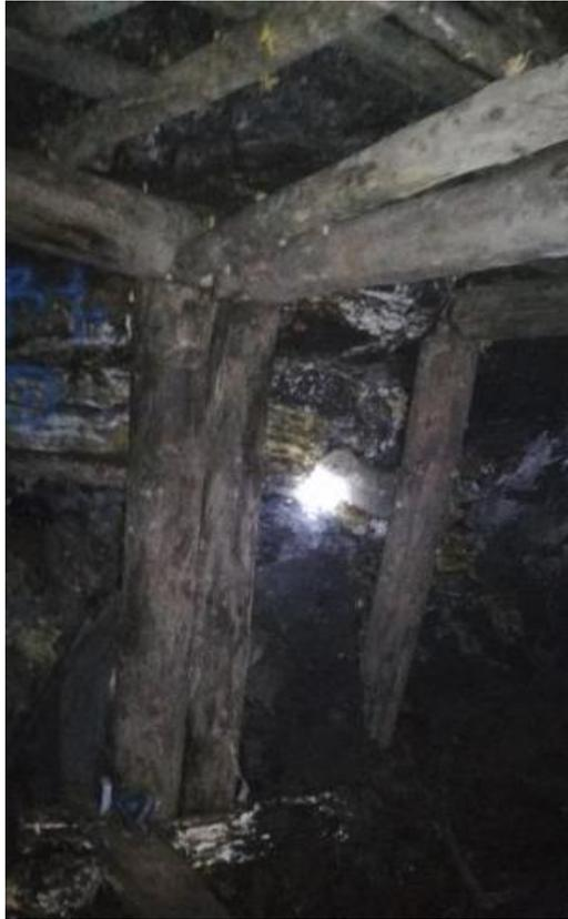
Foto 5. Cuadros en descomposición generando una condición insegura.
