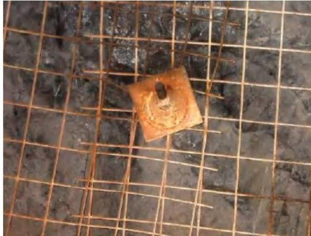
Figura 14. Malla electrosoldada.
