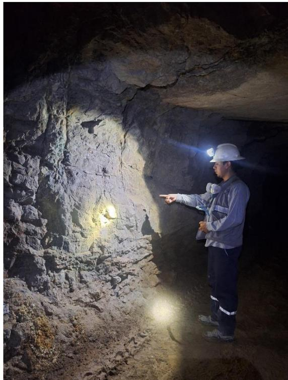
Foto 2. Zona crítica muy fracturada en la sección subterránea.
