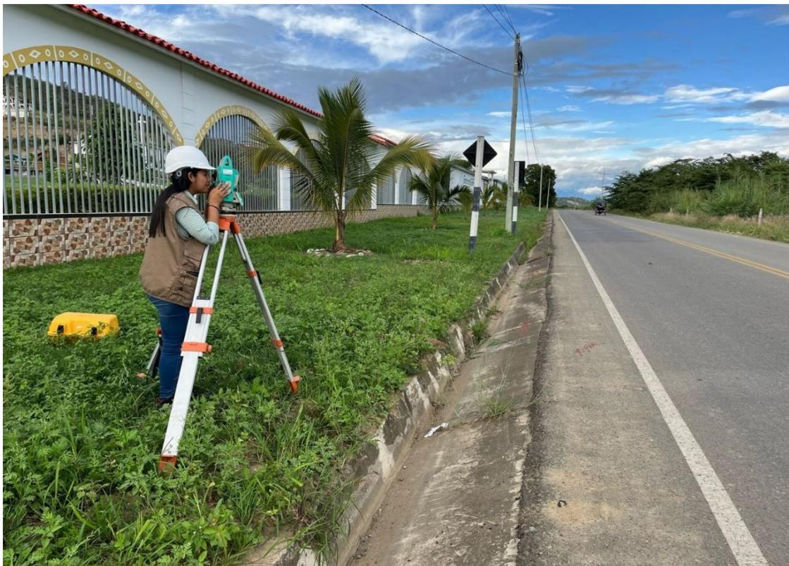
**Figura N°22.** Toma de puntos en curva del tramo.
