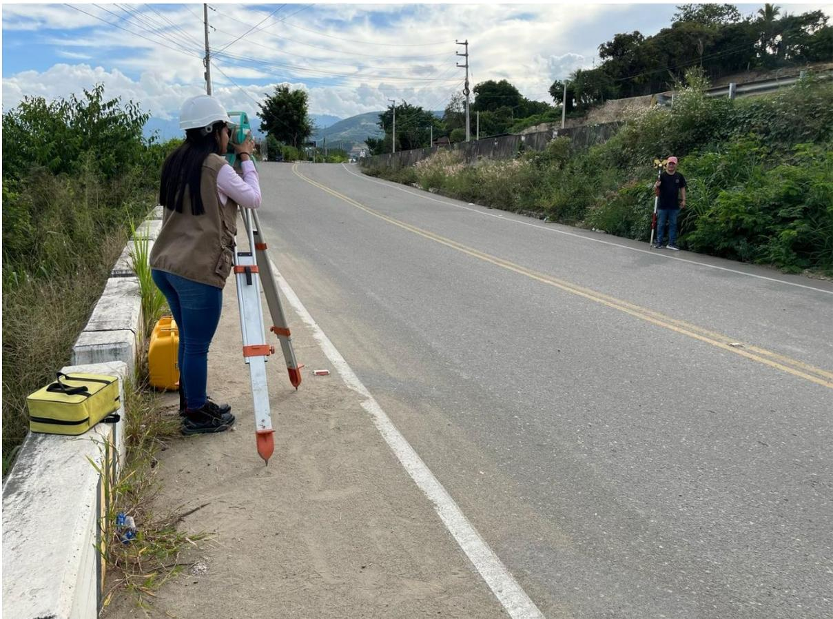
**Figura N°24.** *Medición de pendiente con estación total.*
