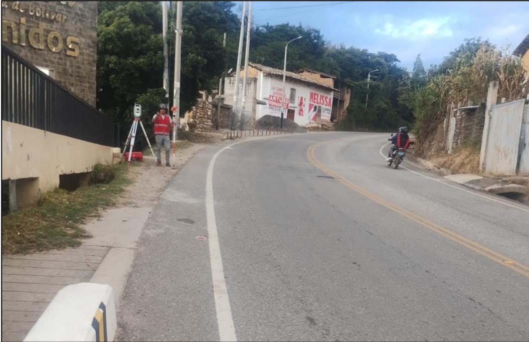
Fotografía 2: Punto Negro N°01, medición de la velocidad de operación.
