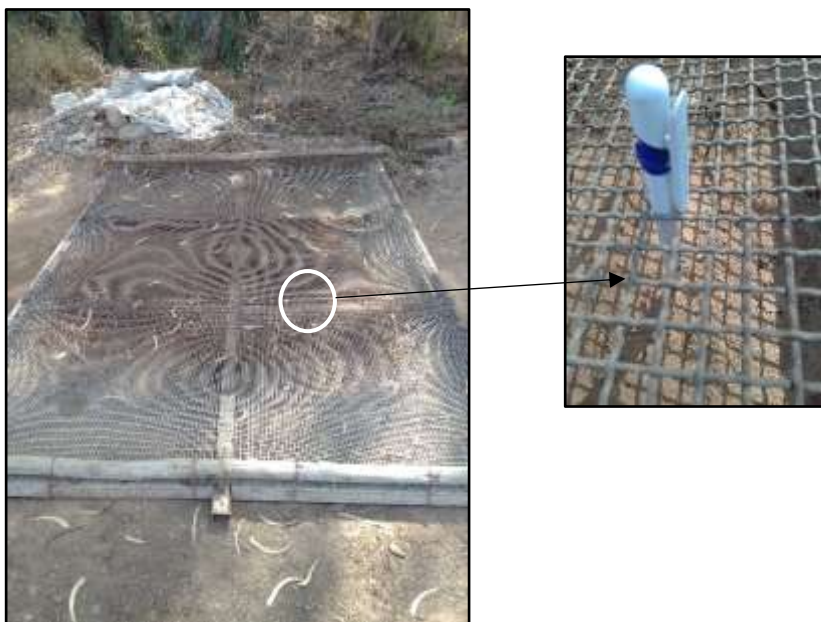
Figura 20. Malla electrosoldada de 5/8"
