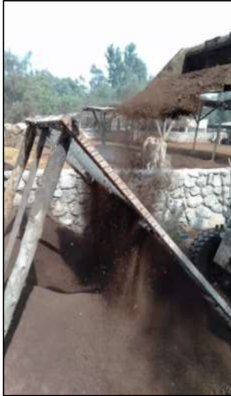
Figura 30. Zarandeo de la mezcla en malla electrosoldada de 5/8"
