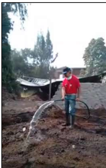
Figura 16. Humedecimiento uniforme de la mezcla
