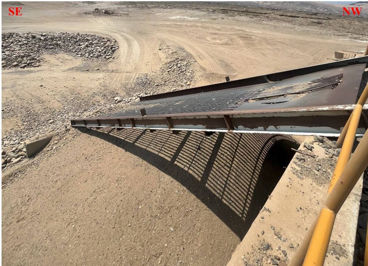
Foto 12: Zarandeo separador de arena de la grava.
