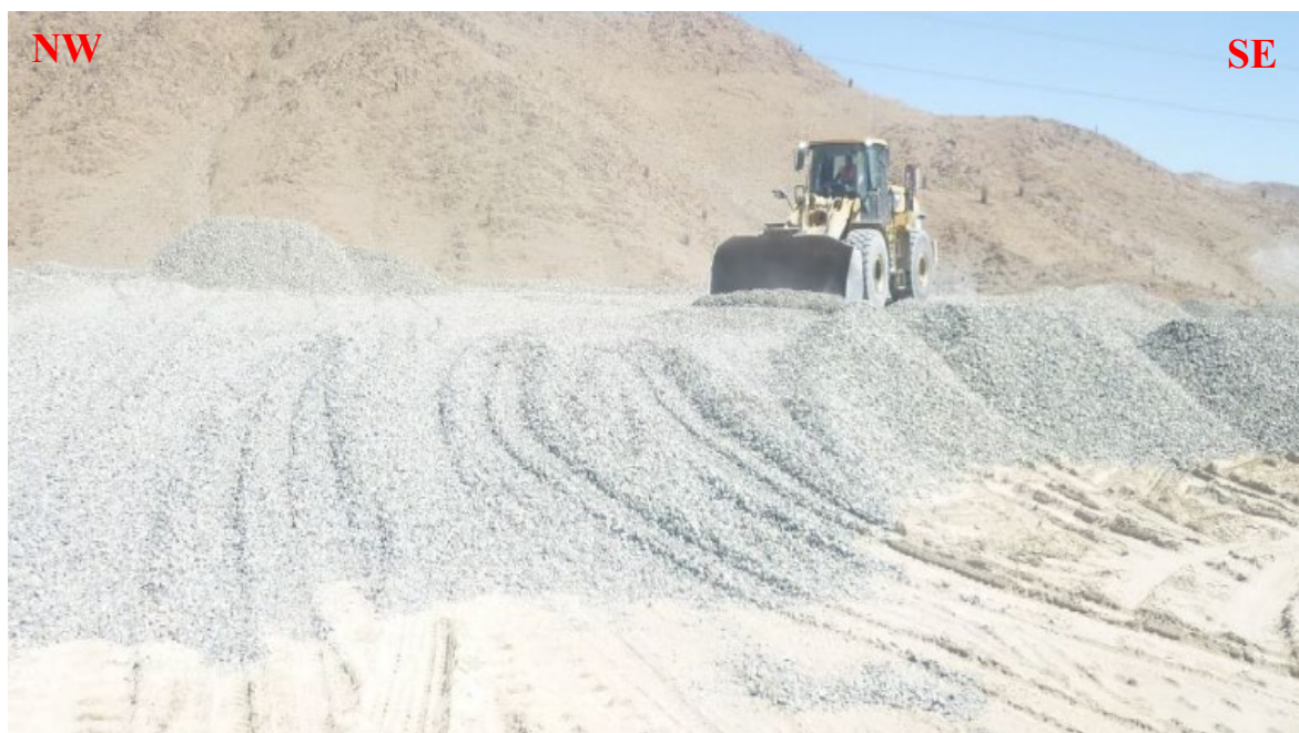
Foto 14: Acopio de material procesado y listo para distribución.
