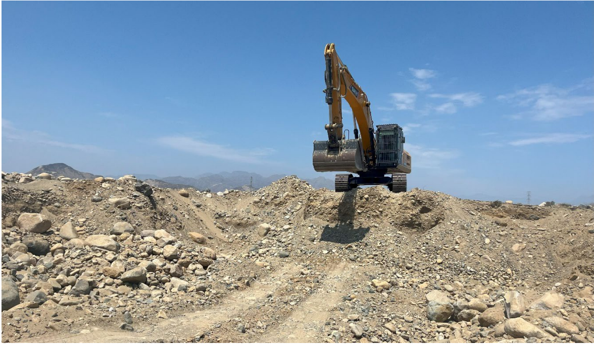
Figura 05: Excavación directa en canteras con excavadora.
