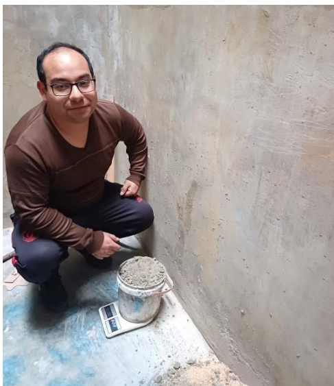
Figura 21. Pesaje 01 de Desperdicio de Mortero - Vivienda 03
