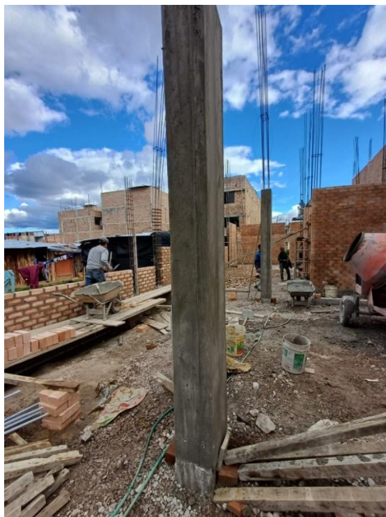
Figura 13. Columna y Muro de Ladrillo – Vivienda 02
