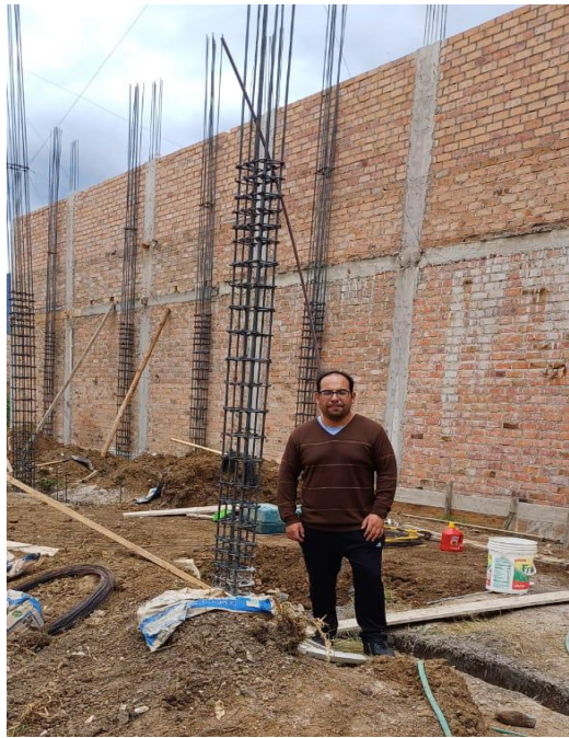
Figura 9. Armado de Columnas – Vivienda 01
