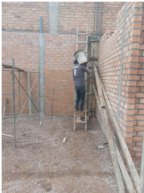
Figura 11. Vaciado de Columnas – Vivienda 01
