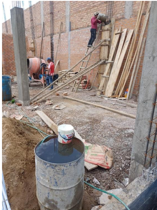
Figura 10. Vaciado de Columna – Vivienda 01
