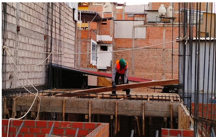
Figura N° 84 Encofrado de losa aligerada
