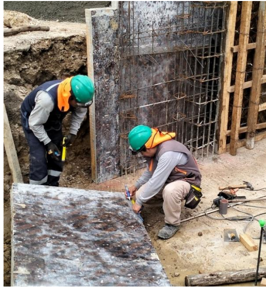
Figura N° 64 Mediciones en partida de encofrado
