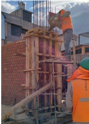
Figura N° 71 Control de calidad en concreto
