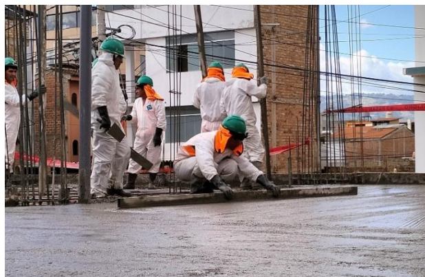
Figura N° 87 Concreto en losa aligerada
