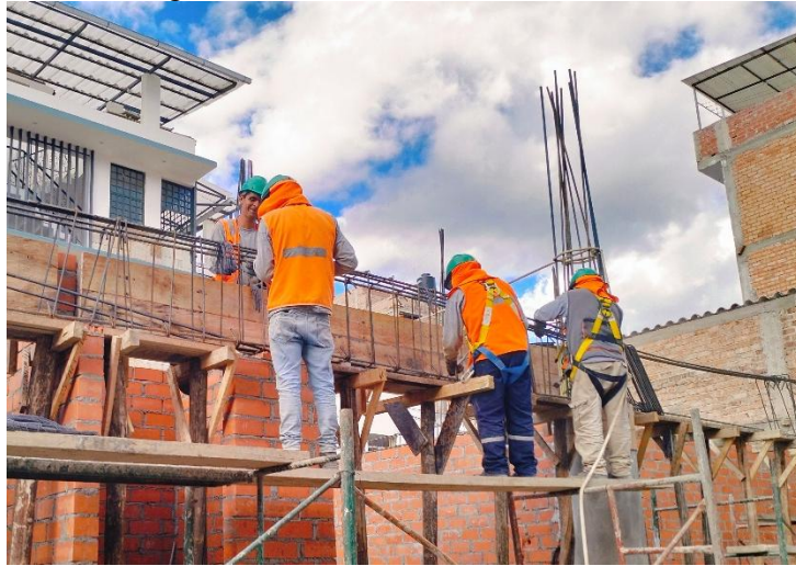
Figura N° 82 Acero en vigas
