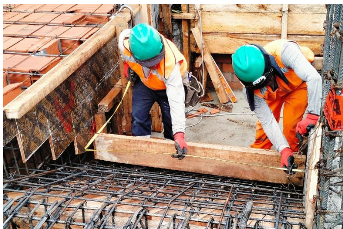
Figura N° 87 Concreto en losa aligerada
