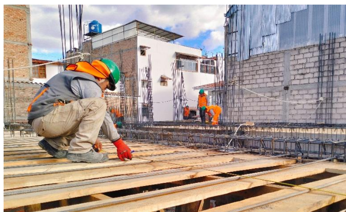
Figura N° 84 Encofrado de losa aligerada
