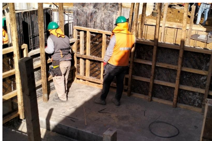
Figura N° 66 Encofrado de cisterna
