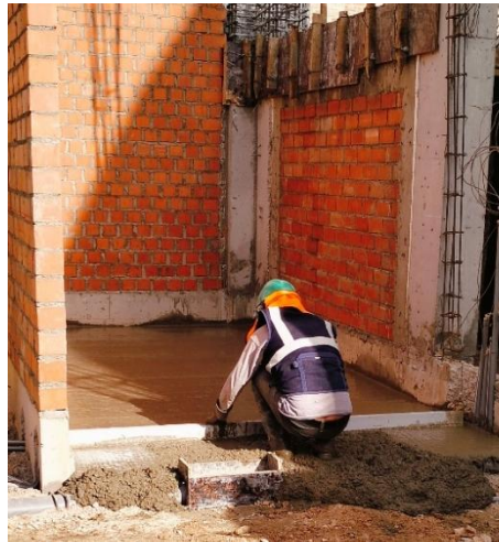
Figura N° 80 Encofrado de vigas
