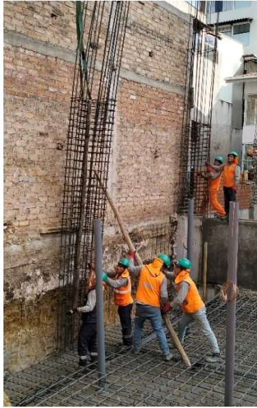
Figura N° 60 Acero en vigas de cimentación
