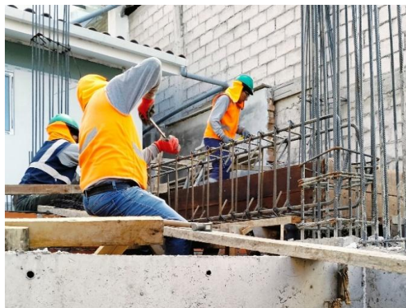
Figura N° 81 Acero en vigas
