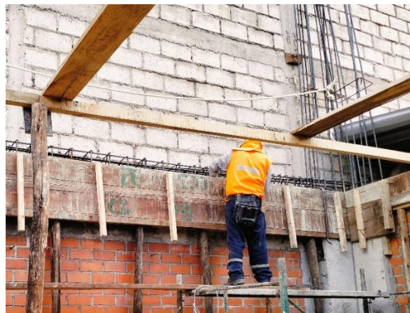
Figura N° 81 Acero en vigas
