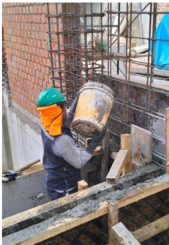
Figura N° 61 Concreto en sobrecimiento armado
