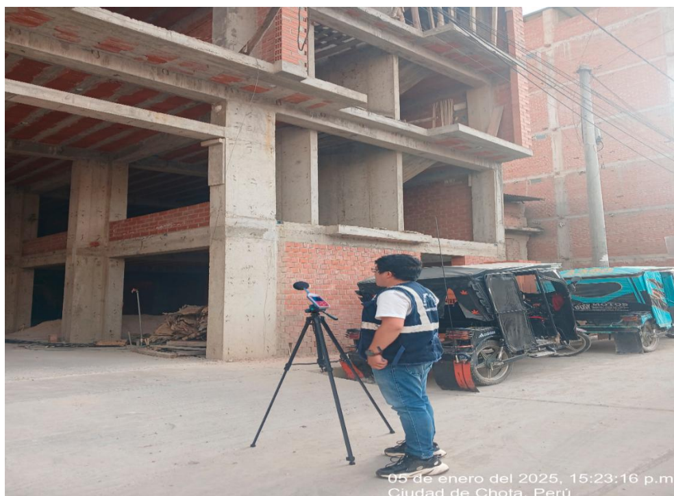
Figura 19. Medición de aislamiento acústico en edificación de la ciudad de Chota ubicada en la calle Adriano Novoa Cdra. 2
