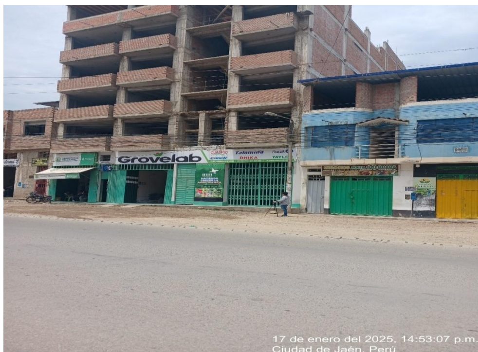
Figura 29. Medición de aislamiento acústico en edificación de la ciudad de Jaén ubicada en la Av. Pakamuros Cdra. 3.
