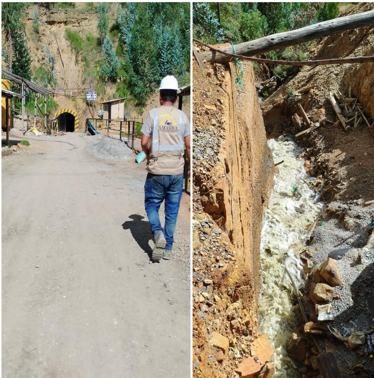
**Foto 9.** Unidad minera Algamarca y el efluente de descarga que van a parar en el río Saucicucho
