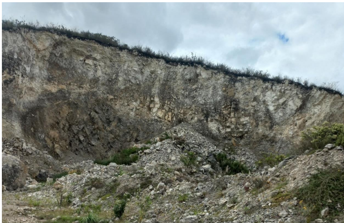
Figura 10: Cantera Las huangas-Bambamarca.
