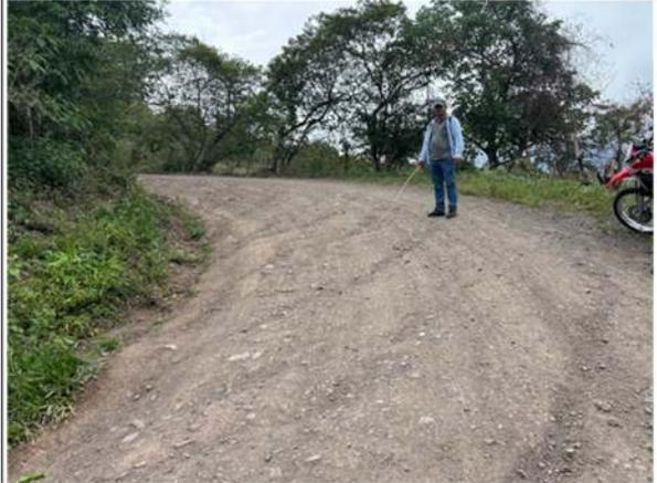
Foto 32: Erosión en plataforma en plataforma - KM 7+410
