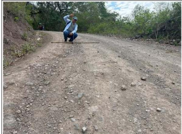
Foto 10: Erosión en plataforma - KM 1+650
