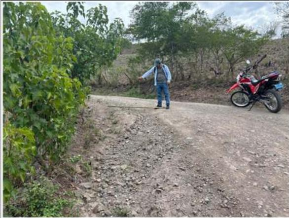
Foto 13: Erosión en plataforma - KM 2+390
