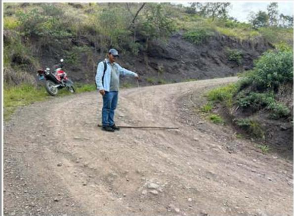
Foto 34: Erosión en plataforma en plataforma - KM 7+920
