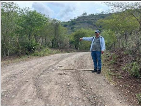
Foto 17: Erosión en plataforma - KM 3+310
