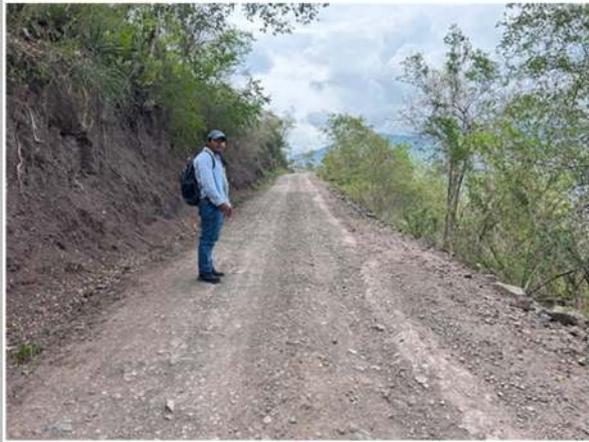
Foto 19: Erosión en plataforma - KM 3+540
