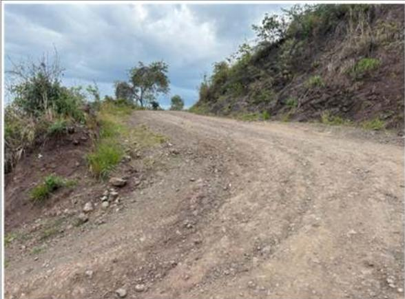
Foto 35: Erosión en plataforma en plataforma - KM 8+090
