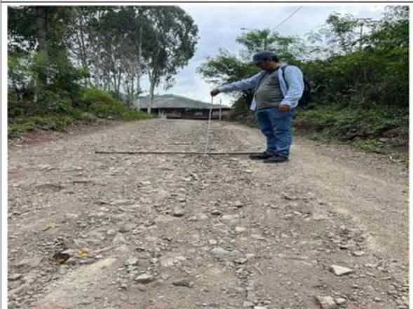
Foto 29: Erosión en plataforma en plataforma - KM 6+200
