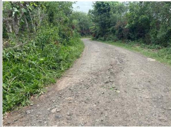
Foto 38: Erosión en plataforma en plataforma - KM 9+005
