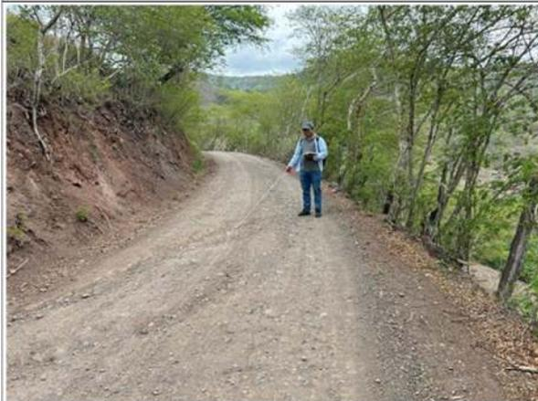
Foto 09: Erosión en plataforma - KM 1+380
