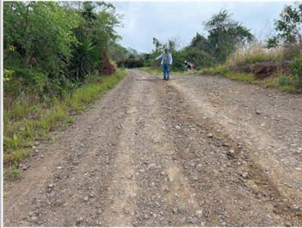
Foto 37: Erosión en plataforma en plataforma - KM 8+790
