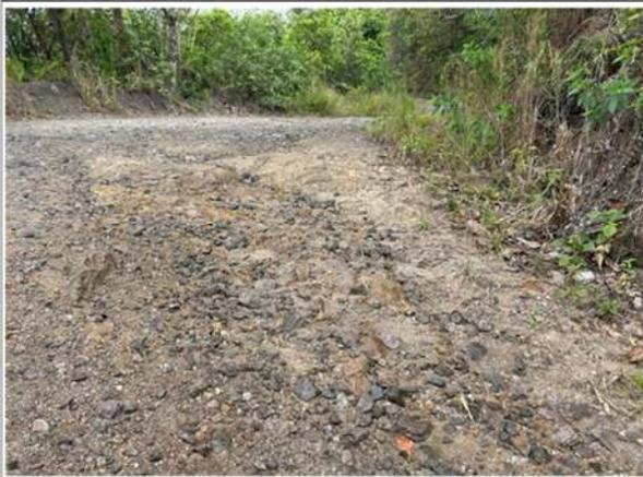
Foto 41: Encalaminado en plataforma en plataforma - KM 9+220
