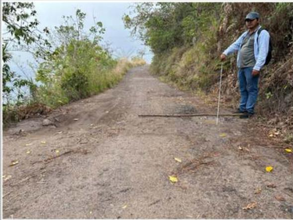
Foto 39: Baches en plataforma en plataforma - KM 9+040
