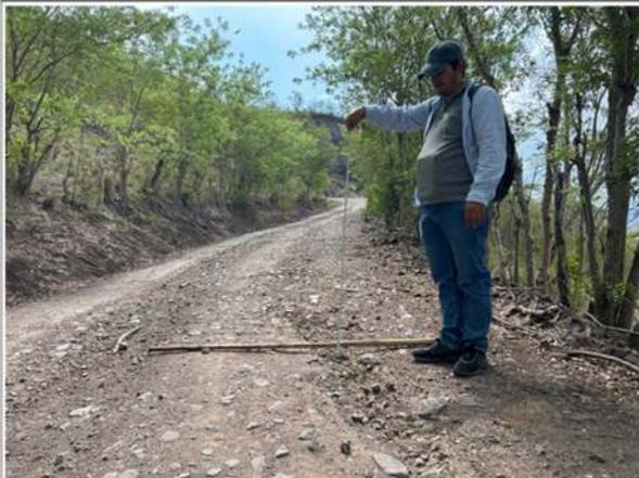
Foto 21: Erosión en plataforma - KM 4+070
