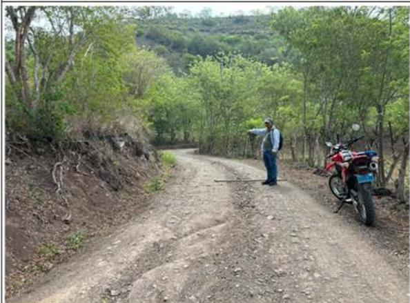
Foto 18: Erosión en plataforma - KM 3+430
