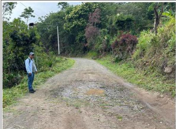
Foto 42: Baches en plataforma en plataforma - KM 9+382
