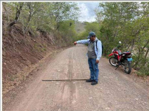
Foto 23: Deformación en plataforma - KM 5+090
