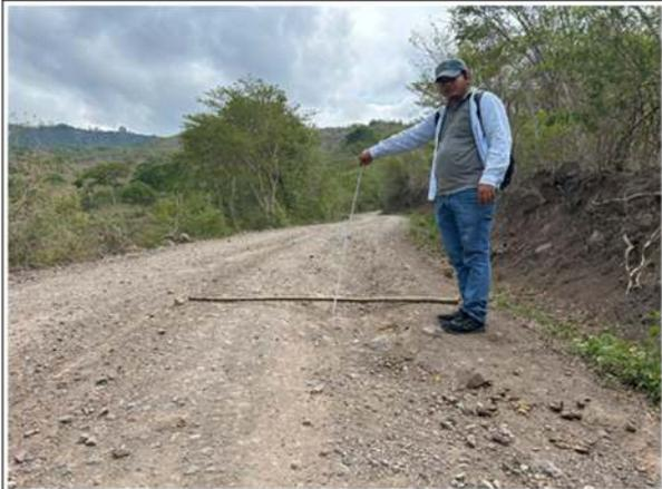
Foto 16: Erosión en plataforma - KM 3+230
