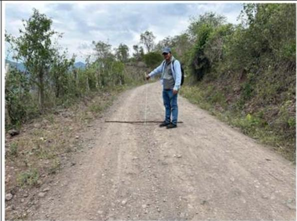
Foto 14: Erosión en plataforma - KM 2+550
