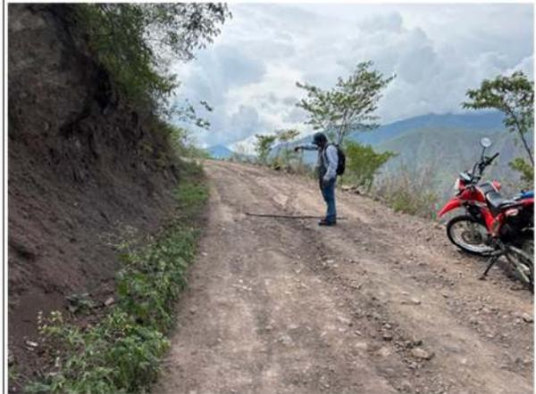
Foto 20: Erosión en plataforma - KM 3+900
