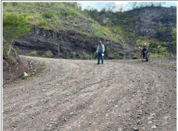
Foto 22: Erosión en plataforma - KM 4+420
