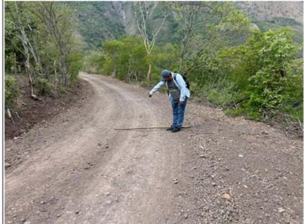
Foto 08: Deformación en plataforma - KM 1+150
