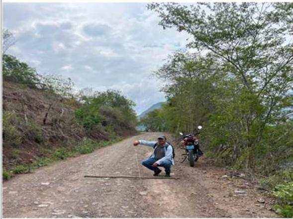
Foto 07: Erosión en plataforma de afirmado - KM 0+910
