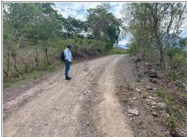
Foto 12: Erosión en plataforma - KM 1+970
