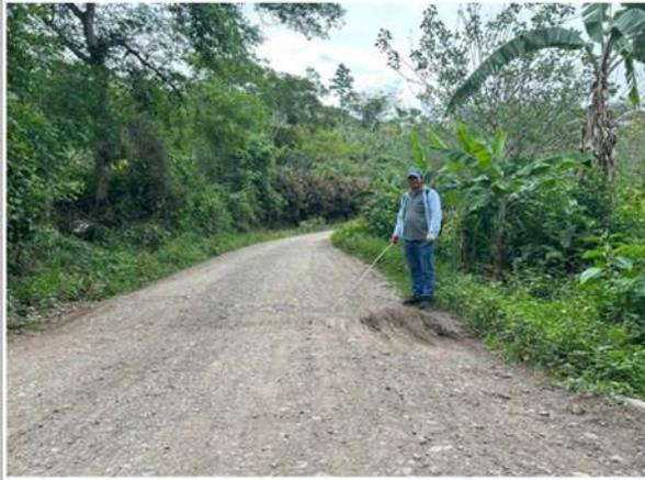
Foto 31: Baches en plataforma en plataforma - KM 6+700
