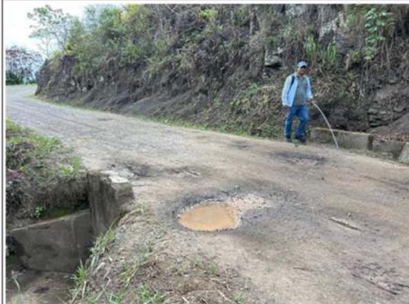
Foto 40: baches en plataforma en plataforma - KM 9+125 - Alcantarilla Ø36"
