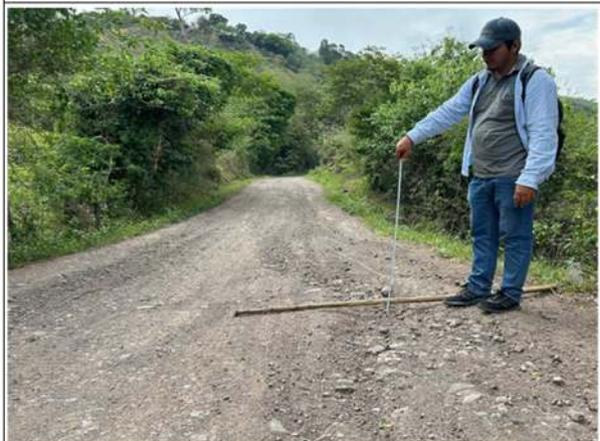
Foto 24: Erosión en plataforma - KM 5+350
