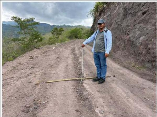
Foto 26: Erosión en plataforma - KM 5+430
