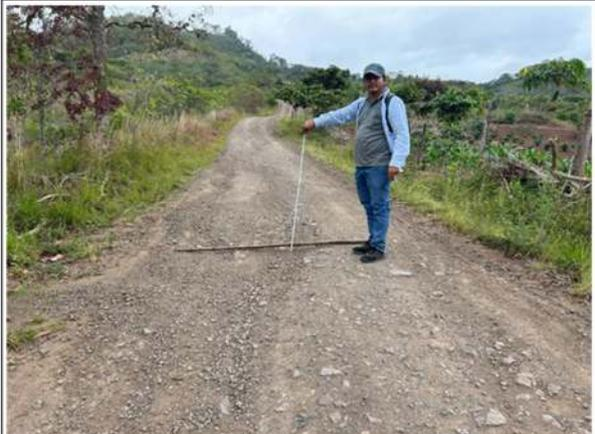
Foto 36: Erosión en plataforma en plataforma - KM 8+490
