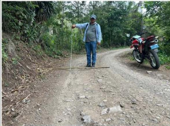
Foto 33: Erosión en plataforma en plataforma - KM 7+560
