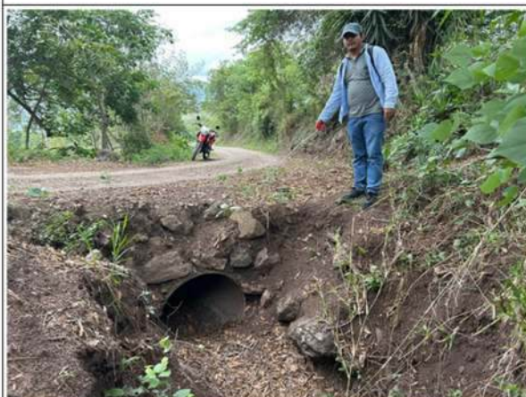
Foto 30: Alcantarilla Ø36" - KM 6+455
