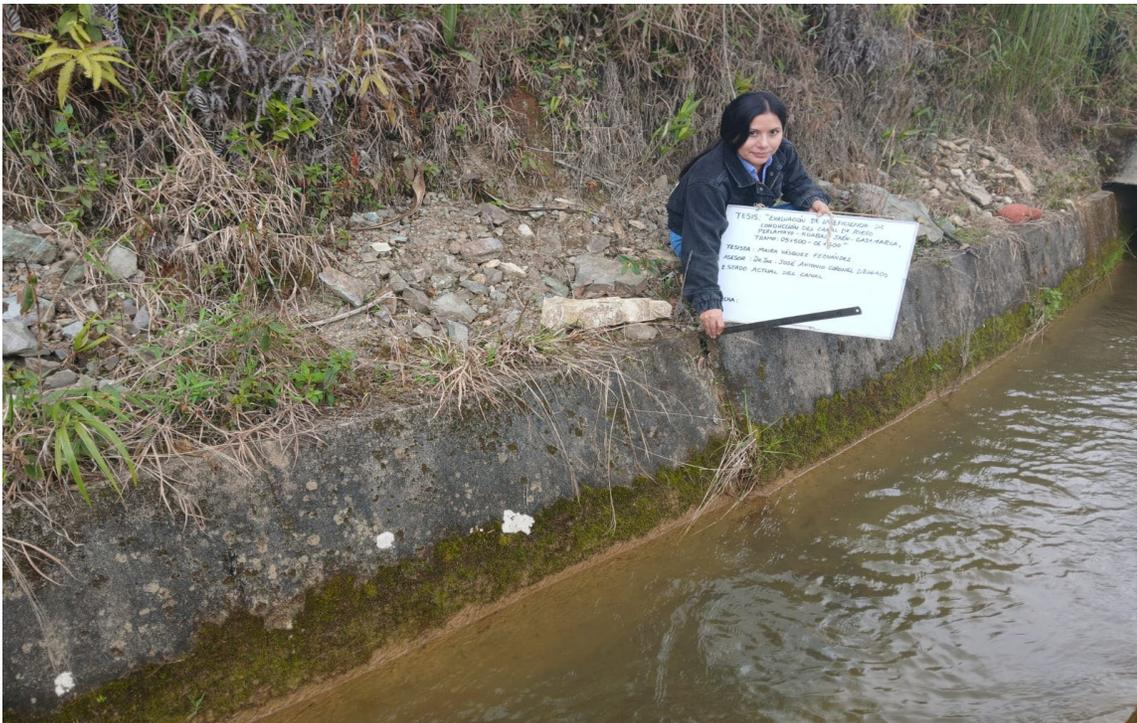
**Fotografía 35:** Juntas en mal estado en la estructura del canal ubicado en el tramo de estudio, 05+500 – 06+500.
