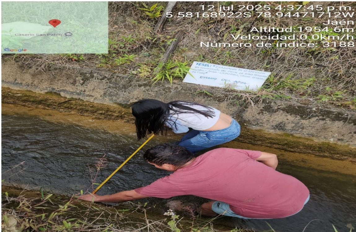
**Fotografía 18: Medición de la pared del canal Perlamayo.**
