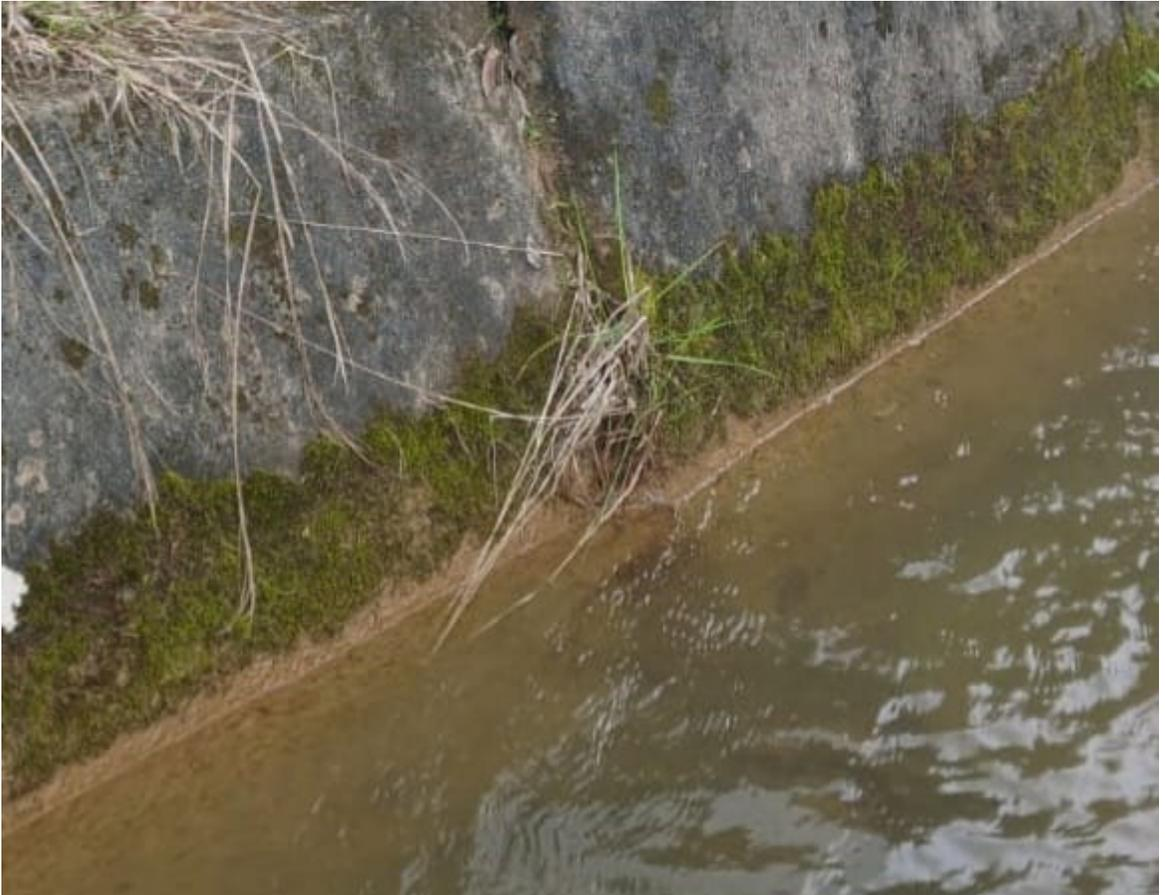
**Fotografía 41:** *Junta del canal, con leve desprendimiento de la pared.*
