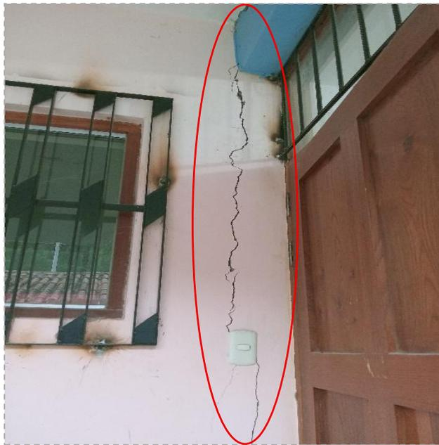
**Figura. 44:** Visualización de fisura en el muro del eje principal C y secundarios 3-4.
