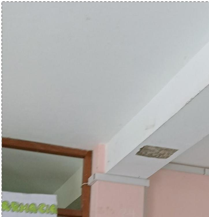
**Figura. 30:** Cumplimos con tarrajar las partes donde se realizaron el ensayo.
