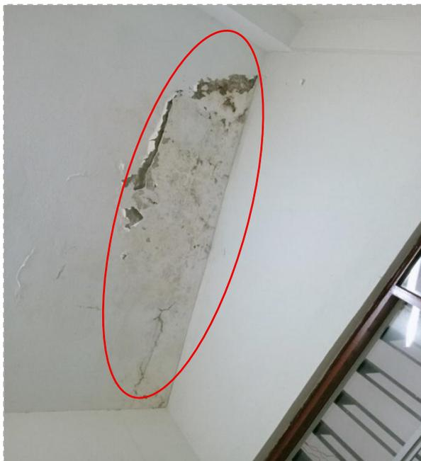
**Figura. 39:** Inspección de losa aligerada primer nivel, en el eje principal B-C (voladizo) y ejes secundarios 3 y 4.
