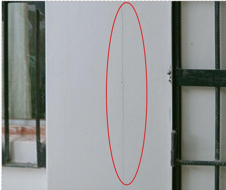
**Figura. 42:** Inspección en la falta de continuidad de columnas del primer y segundo nivel.
