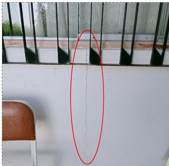
**Figura. 45:** Inspección de piso en la sala de espera, se observa una fisura por asentamiento.
