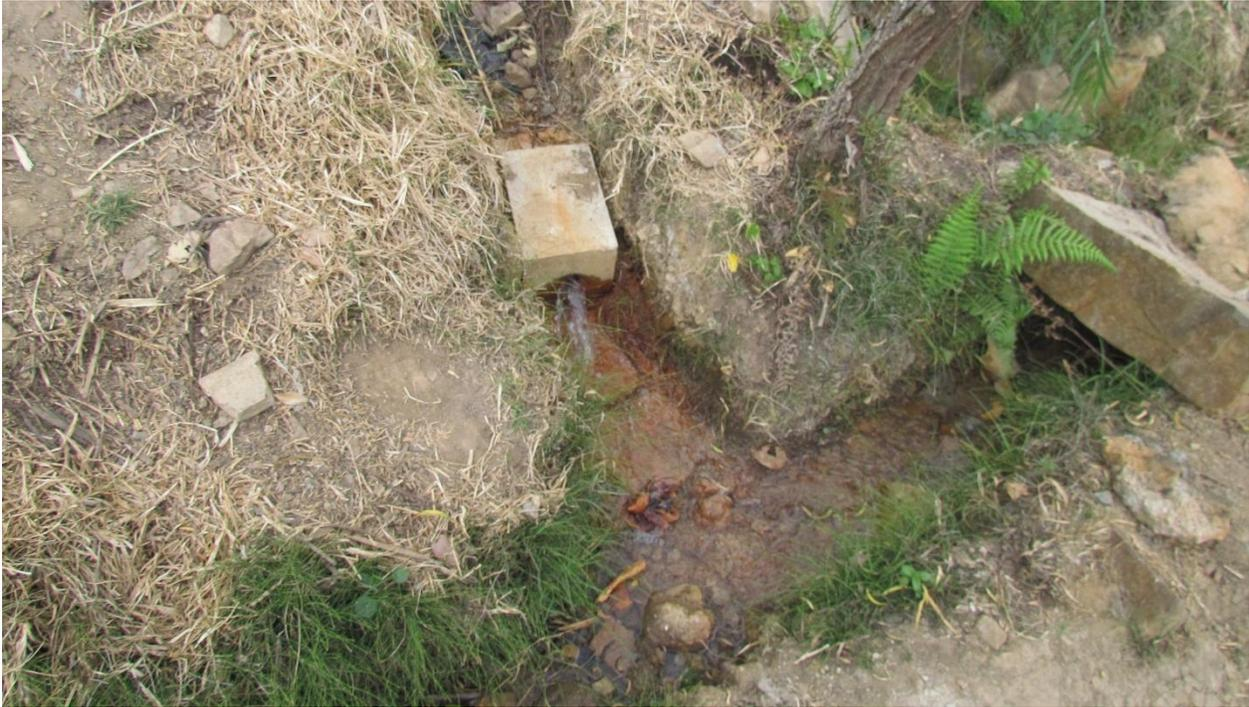
**Fotografía 6.** Dado de protección de tubería de rebose de Captación “ Pozo el Vega 01” hacia canal para uso de irrigación
