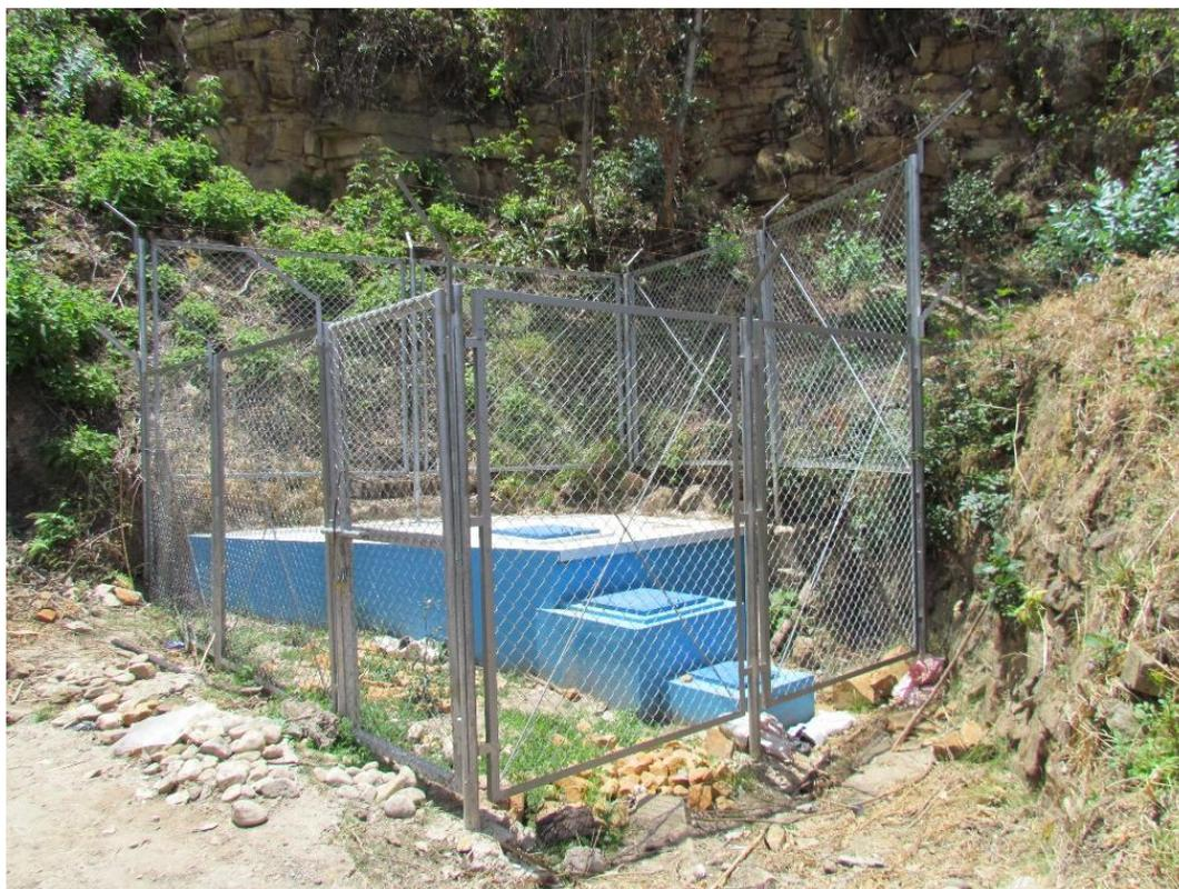
La zona de captación no cuenta con un eficiente material de filtro, de modo que la cámara húmeda contiene muchas partículas suspendidas a causa del deficiente material filtrante.
