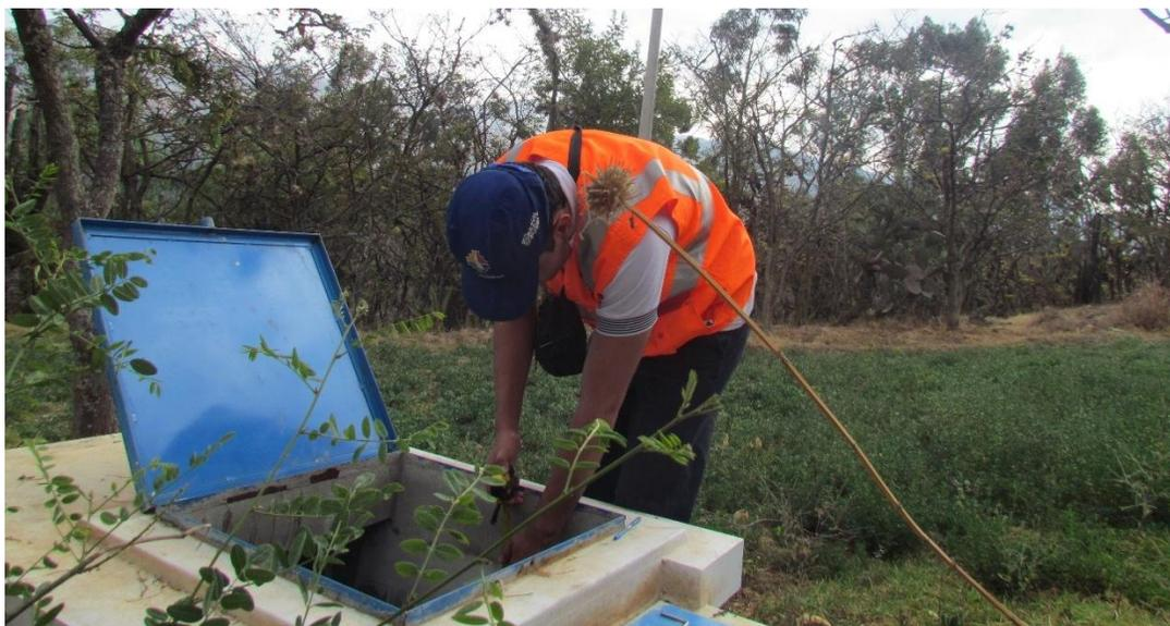
La cámara de válvulas tiene dimensiones de 0.50 m x 0.50 m x 0.75m, con una tubería de entrada de 3/4”.
