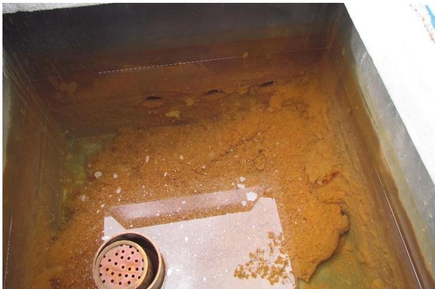
Se encontró la cámara de válvulas llena de agua, lo cual ocurre frecuentemente cuando el nivel en la cámara húmeda es elevado. Esto se debe a que el orificio de paso de la tubería de salida hacia la cámara de válvulas carece de una brida rompe aguas que impida este tipo de filtraciones.
