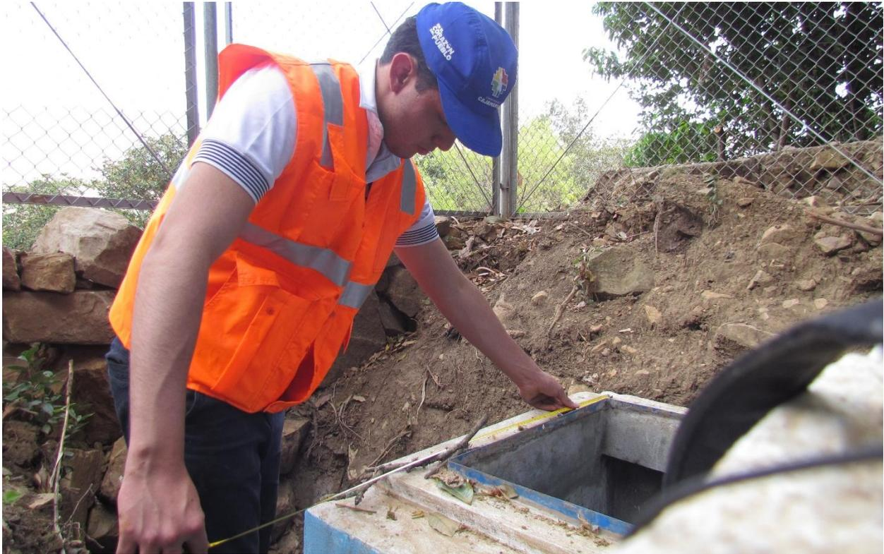
**Fotografía 2.** Midiendo los niveles de la captación para el aforo del manantial
