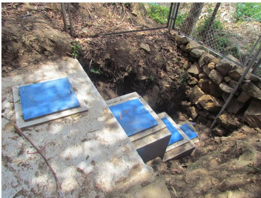
La infraestructura de la captación está construido a bajo el nivel del terreno natural a (1.95m ), conformado por una cámara de protección, una cámara húmeda, cámara de válvulas y un sistema de desarenador en gradas localizada en la salida de los orificios descargando agua de la cámara de protección.
