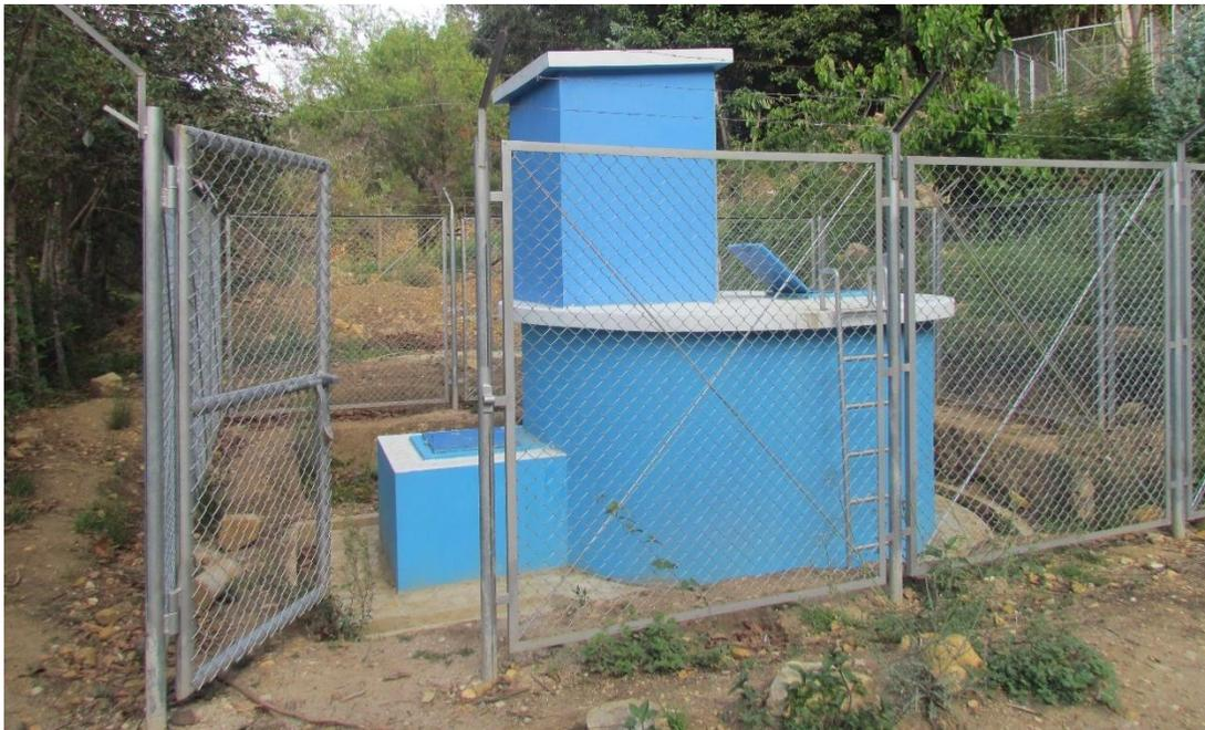
Su estructura no cuenta con ningún daño hasta el momento. Dispone de una escalera metálica que facilita el acceso a su interior para realizar tareas de limpieza y cloración periódicas, gestionadas por el área técnica municipal. También cuenta con una tapa metálica que se encuentra en un buen estado.
