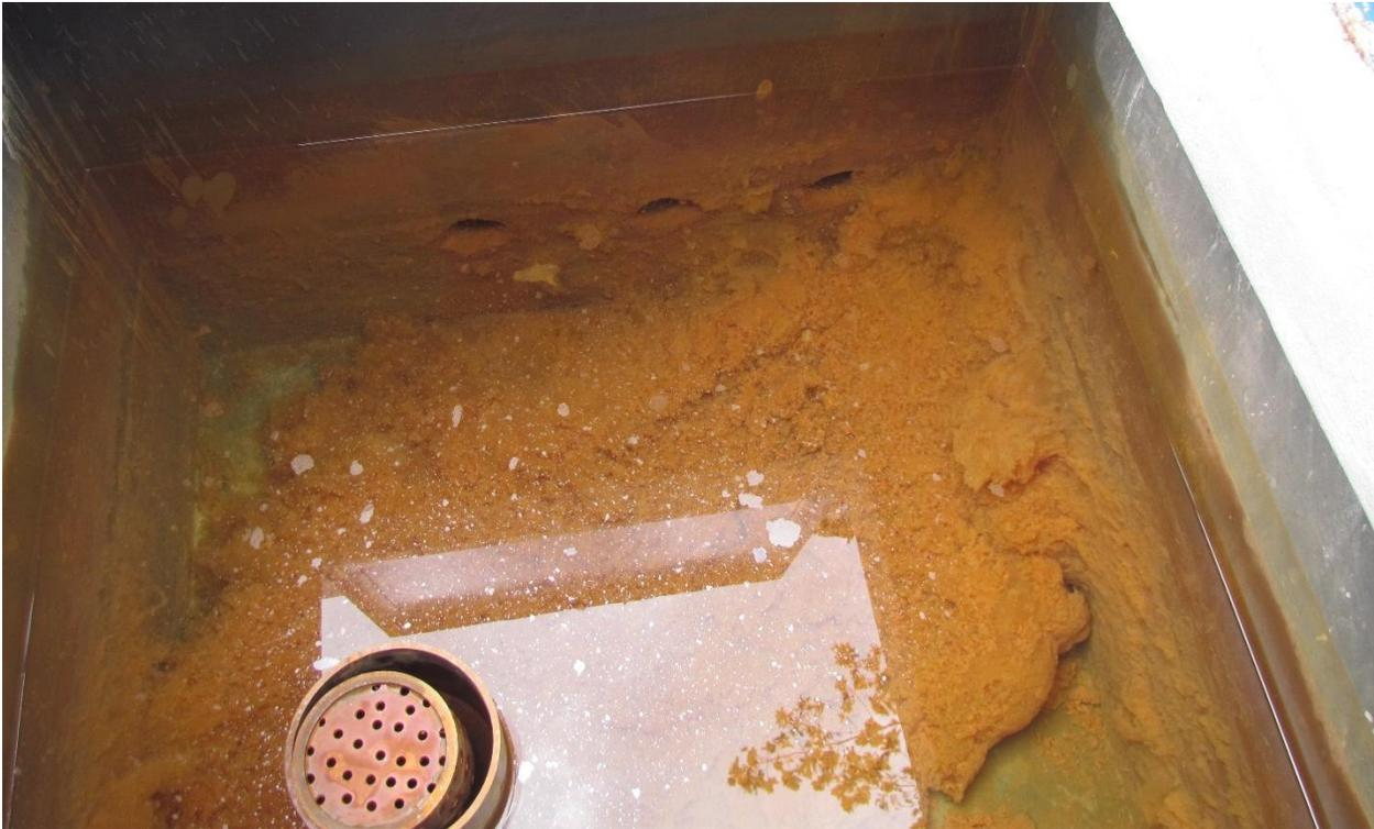
**Fotografía 5.** Dado de protección de tubería de rebose de Captación “ Pozo el Vega 02” hacia canal para uso de irrigación
