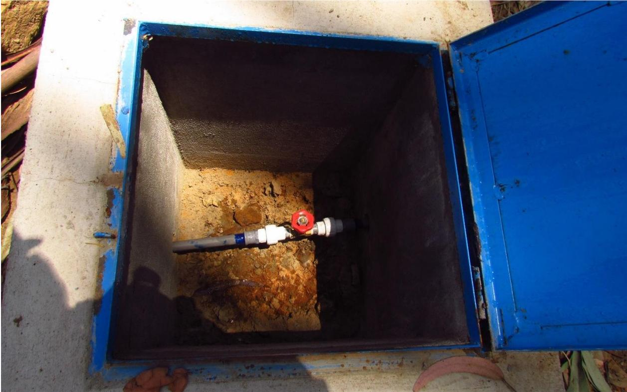
**Fotografía 27.** Dado de protección de tubería de Salida en la válvula de purga
