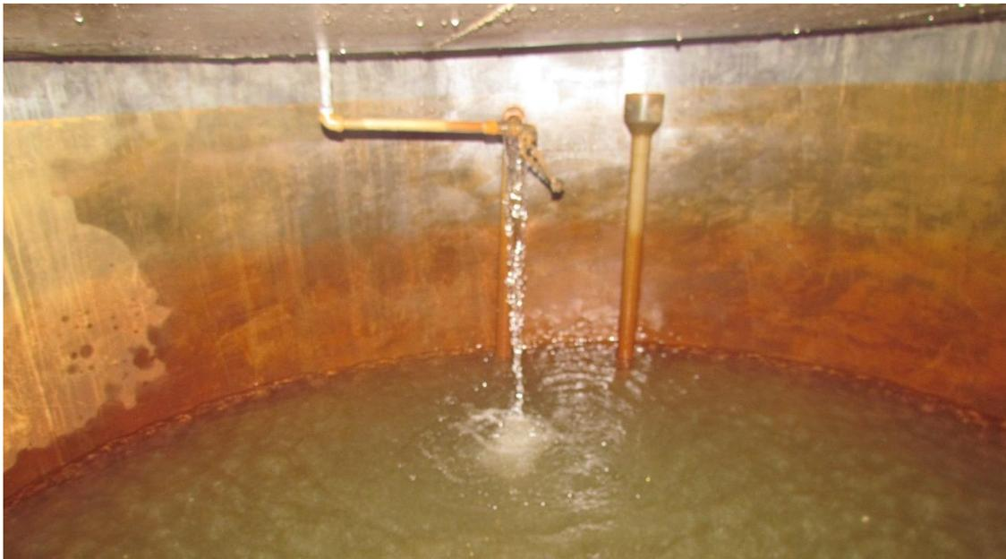
La caja de válvulas cuenta con una tubería rebose de PVC  $\phi$  2", una tubería de salida de Salida de PVC C10  $\phi$  1 1/2" y una tubería de entrada de PVC C10  $\phi$  2", todas estas tuberías cumplen con la NTP 399.002.
