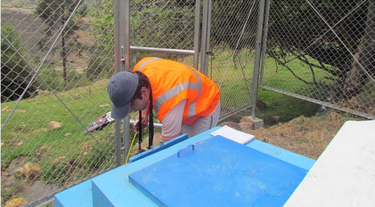
**Fotografía 17.** Dado de protección de salida de tubería de rebose y limpia en la Captación Retamamayo.
