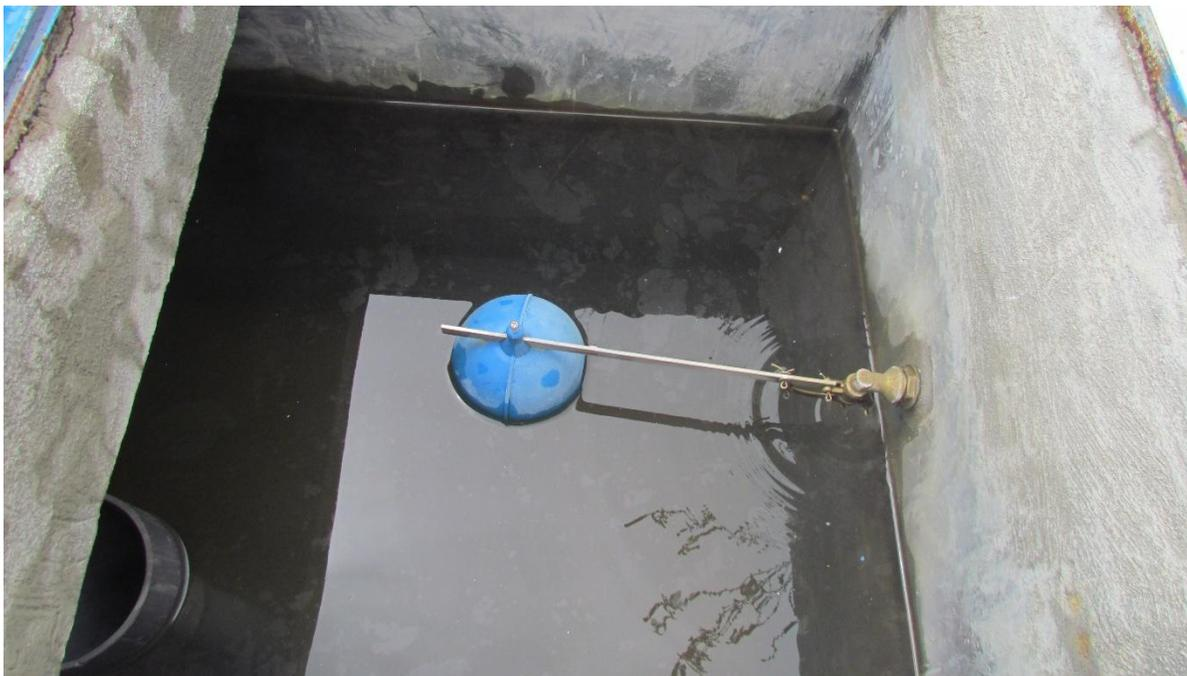
La cámara de válvulas tiene dimensiones de 0.50 m x 0.50 m x 0.75m, con una tubería de entrada de 3/4”.
