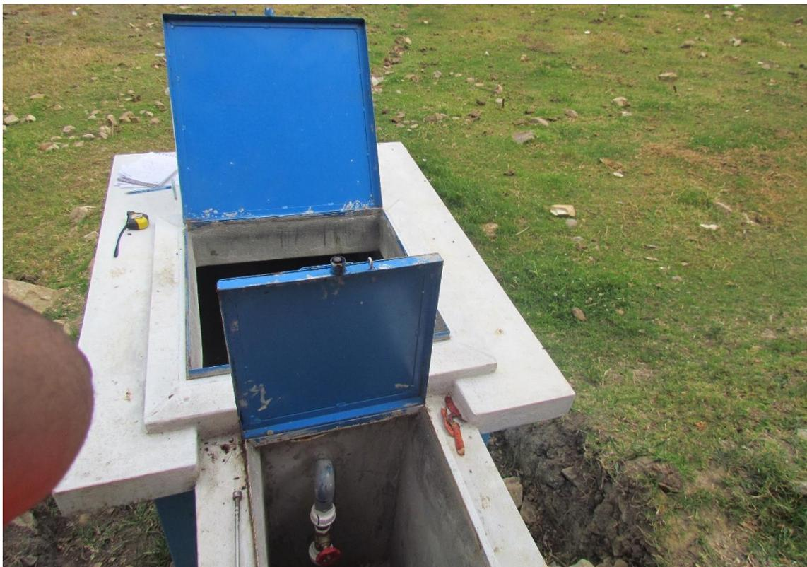
**Figura 72.** Funcionamiento de Cámara Rompe Presión (Cámara 3)
