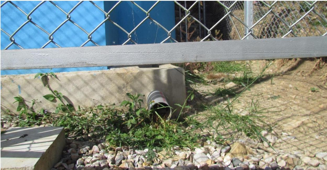
**Fotografía 19.** Dado de protección de salida de tubería de rebose y limpia del reservorio Retamamayo
