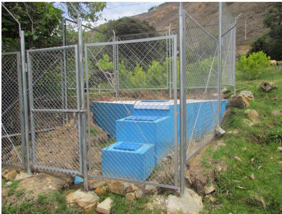
La infraestructura de la captación está construido a 1.05m bajo el nivel del terreno natural. La infraestructura de captación es de concreto armado, conformado por una cámara de protección de 4.1m x2.6m x 0.9m de altura, también se observó una Cámara húmeda de 0.66m x 0.66m x 0.85m de altura con una tubería de rebose con un diámetro de 2” que está operando con una canastilla de 3” a 1.5” a una altura de 0.29m.
