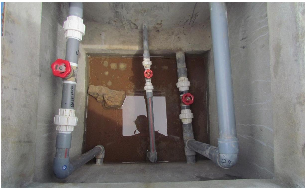
Se observó la presencia de agua dentro de la cámara de válvulas como en el reservorio Capellanía Chávez, lo que indica una posible filtración desde el reservorio. Esto incumple el principio de estanqueidad exigido por la Norma Técnica de Diseño del Ministerio de Vivienda, Construcción y Saneamiento. Además, en situaciones como esta, la cámara de válvulas debería contar con un sistema de drenaje para evacuar el agua acumulada en su interior.
