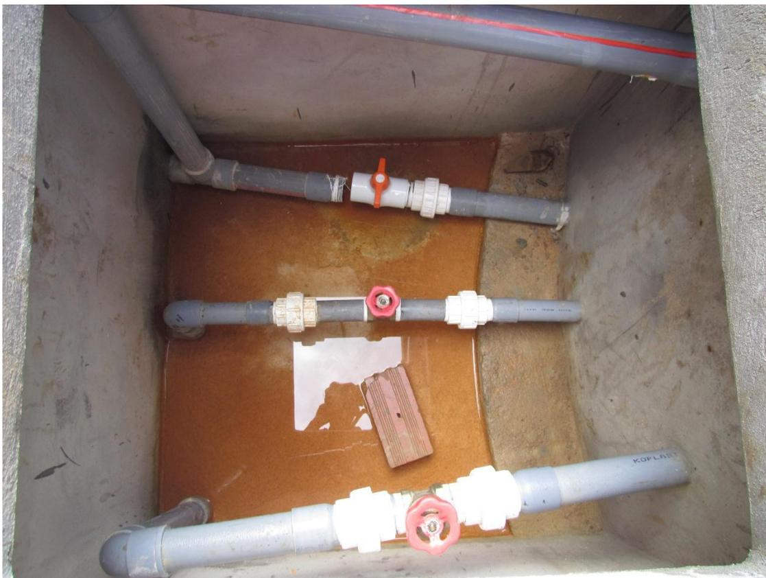
Se observó la presencia de agua dentro de la cámara de válvulas, lo que indica una posible filtración desde el reservorio. Esto incumple el principio de estanqueidad exigido por la Norma Técnica de Diseño del Ministerio de Vivienda, Construcción y Saneamiento. Además, en situaciones como esta, la cámara de válvulas debería contar con un sistema de drenaje para evacuar el agua acumulada en su interior.
