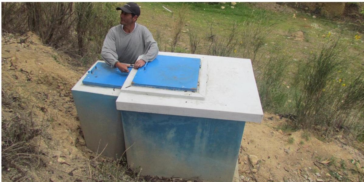
El funcionamiento de esta cámara rompe presión es funcional, la válvula a diferencia de la primera está bien equipada.
