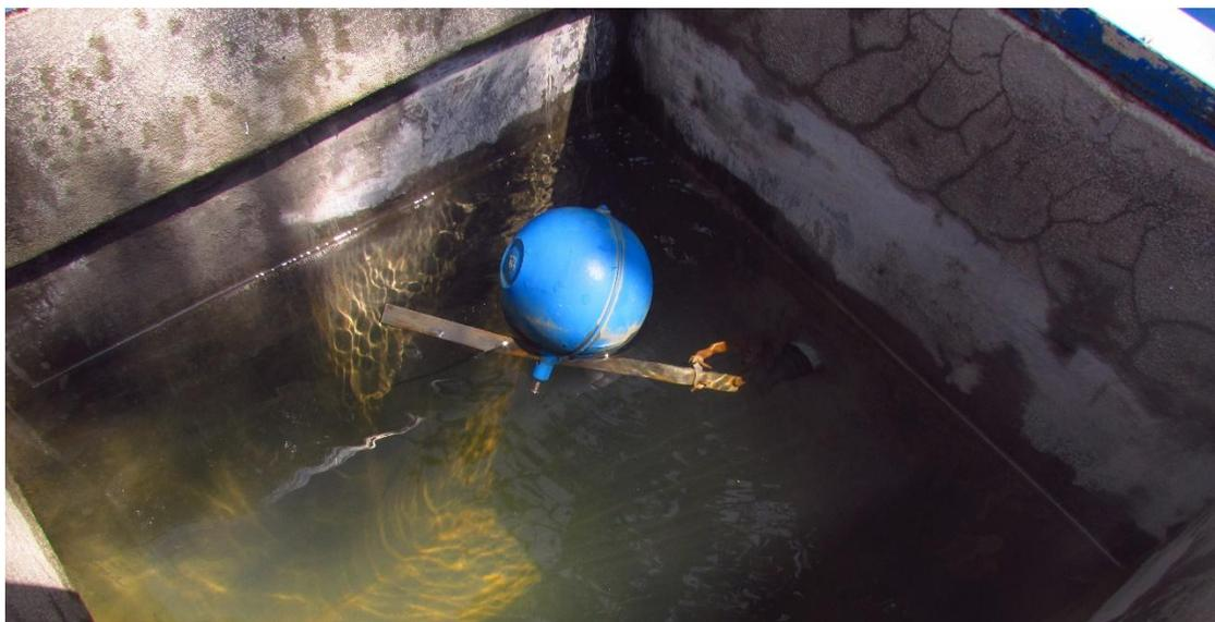
La cámara de válvulas tiene dimensiones de 0.50 m x 0.50 m x 0.75m, con una tubería de entrada de 3/4”.
