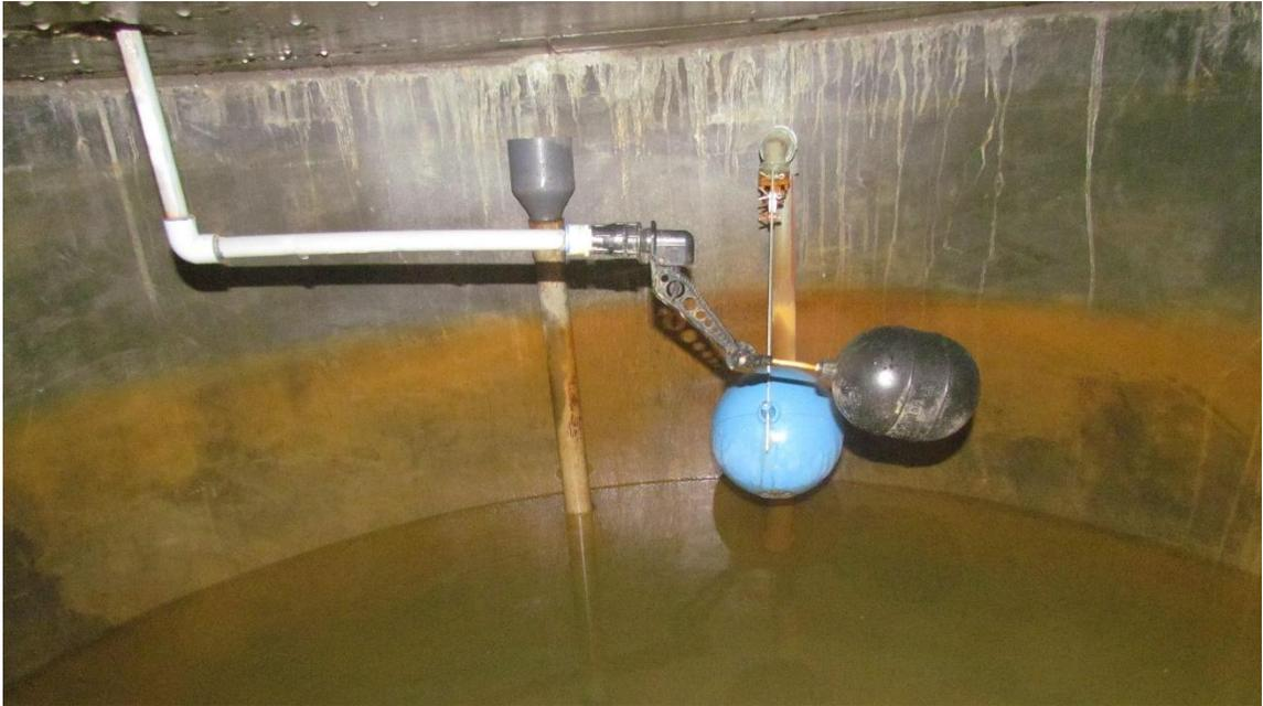
A diferencia del otro reservorio, este cuenta con dos válvulas flotadoras adecuadamente equipadas. La válvula de entrada está provista de una boya que bloquea el paso de agua al alcanzar el nivel máximo. Además, incluye otra válvula flotadora específica para el sistema de cloración por goteo.
