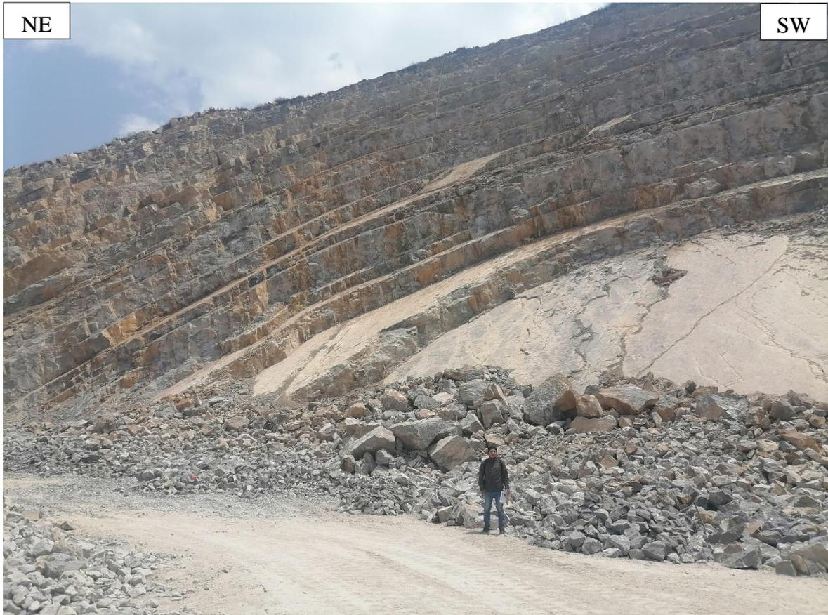
Figura 3.3. Afloramiento de caliza de la Formación Cajamarca, con buzamiento de estratos a favor del talud del tajo de explotación, siendo predominante las caídas de rocas por su alto buzamiento y pendiente de talud.
