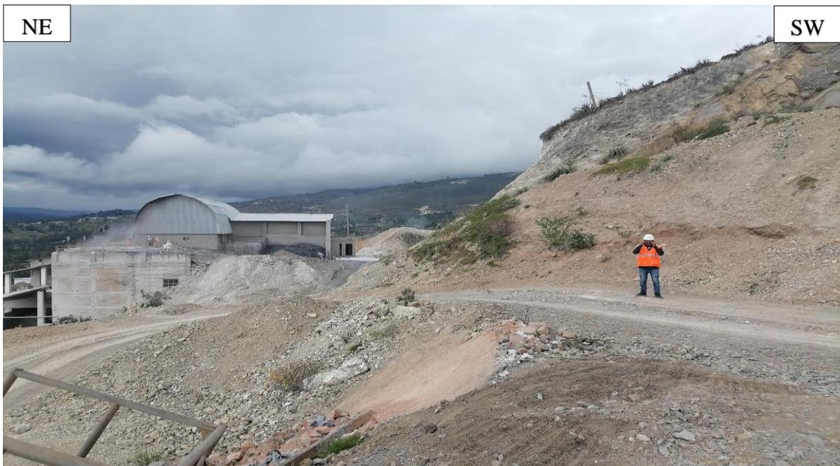
Figura 3.4. Depósitos Antrópicos distribuidos acumulados en la parte baja del tajo de explotación.
