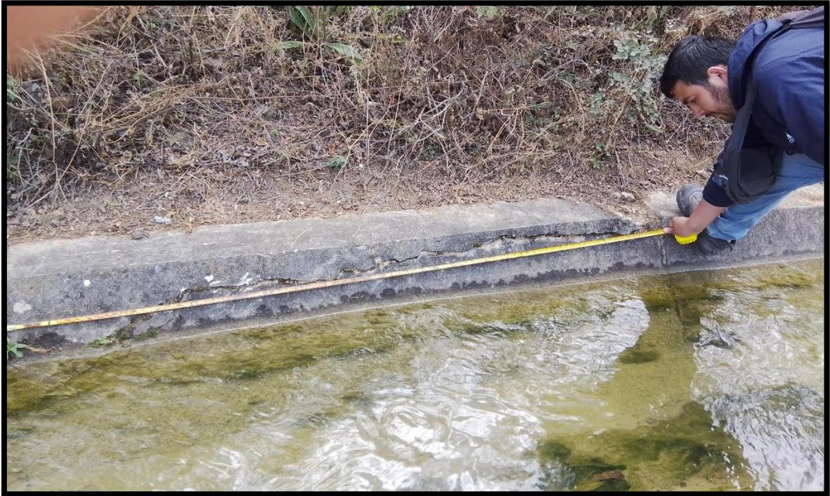
**Anexo 18:** Caracterización del canal de conducción (rotura a lado de la junta de dilatación).
