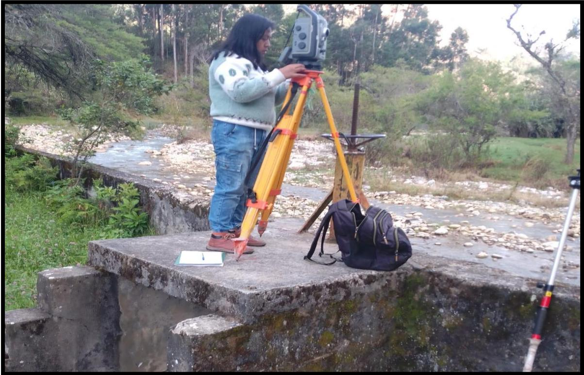
**Anexo 12:** Levantamiento topográfico con estación total robotizada de la captación del canal de riego San Marcos II aguas abajo.
