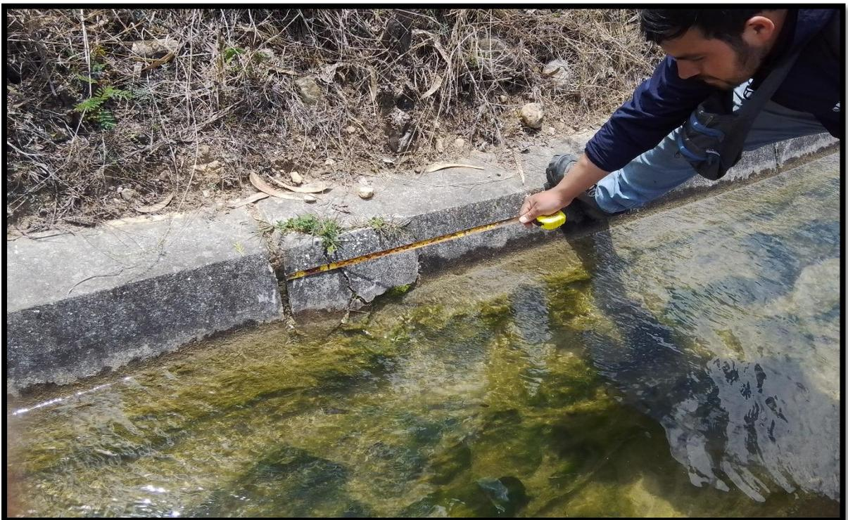
**Anexo 19:** Caracterización del canal de distribución Marcopampa lateral “F” (rotura del canal y junta de dilatación en mal estado con presencia vegetación).
