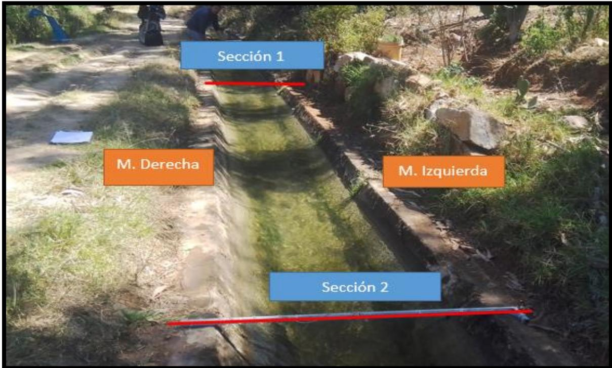
El canal de conducción es de sección trapezoidal, revestido de concreto simple y juntas de material bituminosos ubicado de 2 a 3 m., tiene una base o ancho de solera de 0.45 m., talud de 0.65 m., un borde libre de 0.1 m. y un ancho total del canal de 1.20 m.
