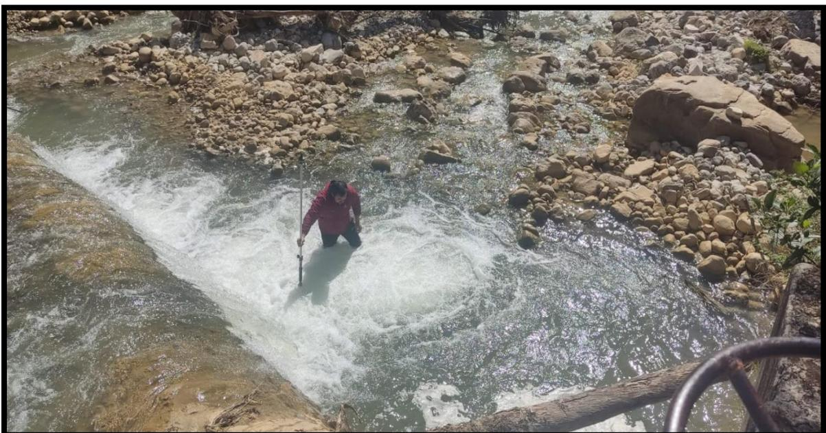
**Anexo 13:** Levantamiento topográfico con estación total robotizada de la captación del canal de riego San Marcos II aguas arriba.
