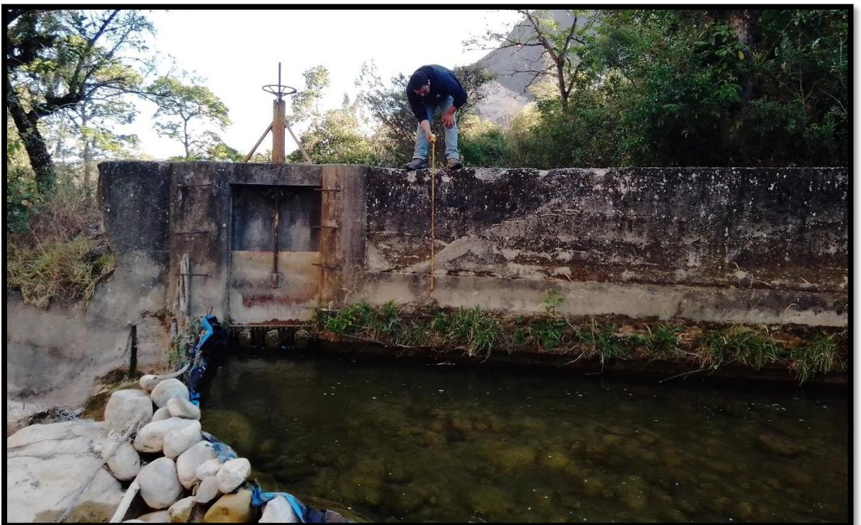
**Anexo 17:** Caracterización del canal de conducción (grieta longitudinal en el paño).
