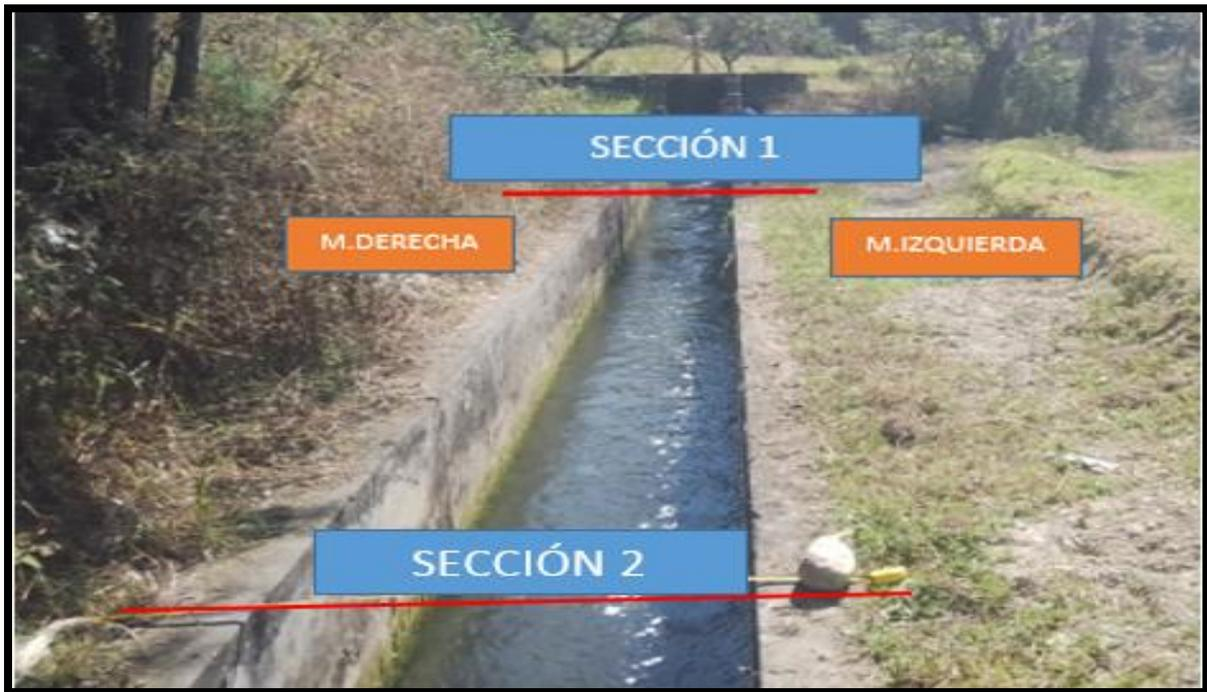
Canal de sección rectangular utilizado para la medición de caudales, para hallar la eficiencia de captación y el volumen de agua que ingresa al sistema.
